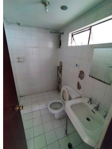
Baño 5 en piso 3
