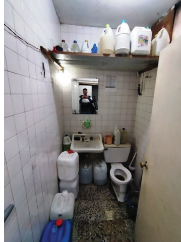
Baño 1 en piso 1
