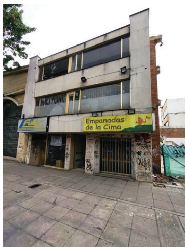
Fachada y zona dura
