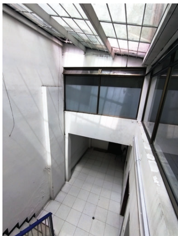
Salón a doble altura
