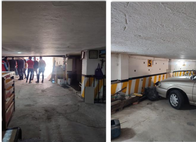
Imagen de referencia 8. Caso especial - Semisótano AK 14 71 11 Interestación 15.
