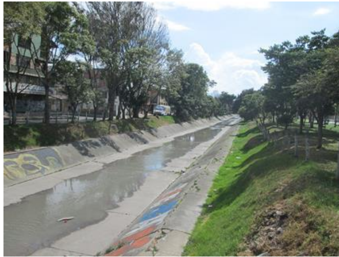
Fotografía 5.2.2.7 Aspecto del Canal Río Seco en inmediaciones del AID del proyecto Fuente: SYSTRA- INGETEC, 2018
