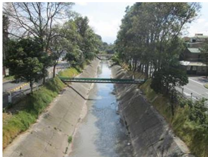
Fotografía 5.2.2.5 Aspecto del Canal Albina
