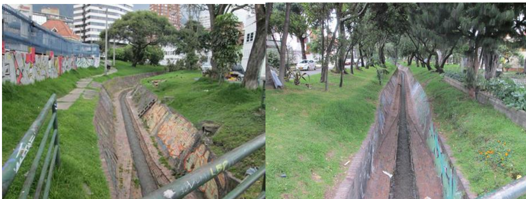
Fotografía 5.2.2.9 Izquierda Canal Arzobispo al oriente de la Avenida Caracas. Derecha: Vista al occidente de la avenida
