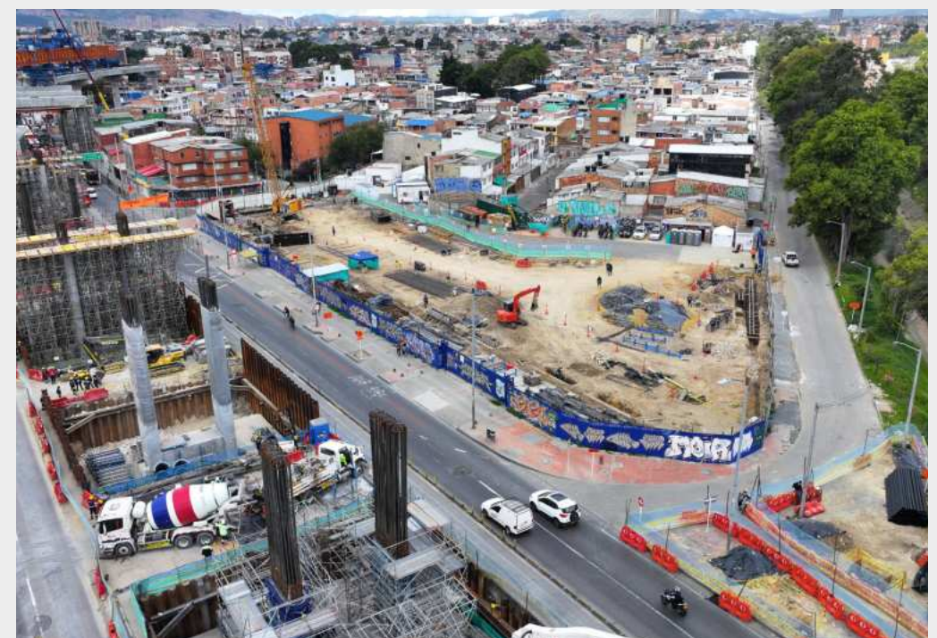
Estación Metro No. 9-Nave Central
