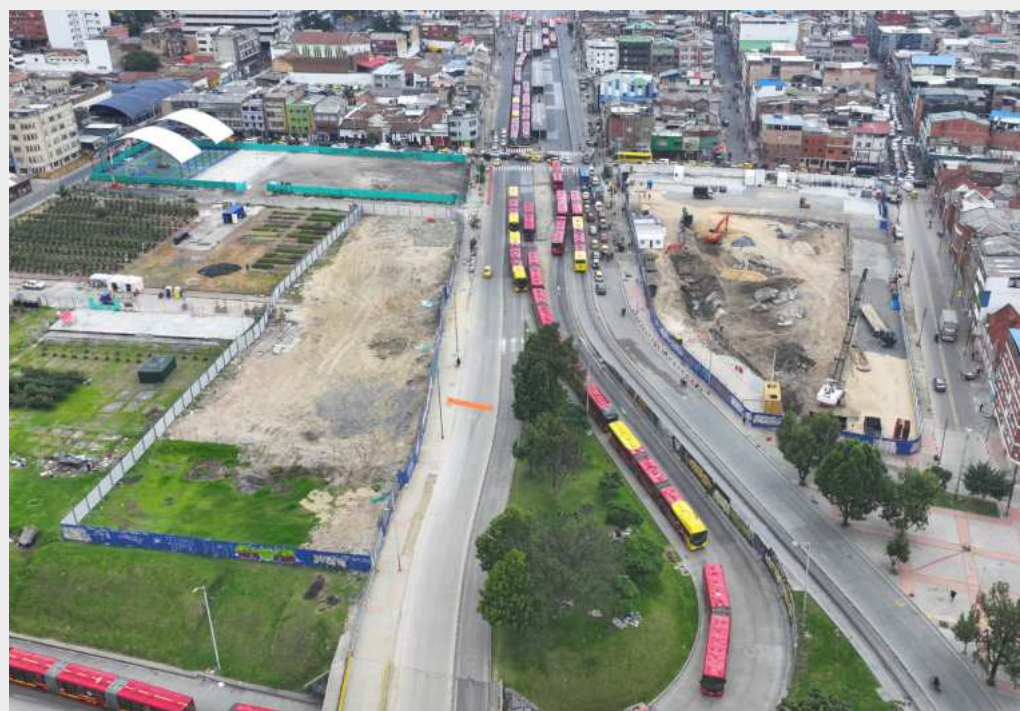
Estación Metro No. 13-Vista general Edificio Ascendente y Descendente
