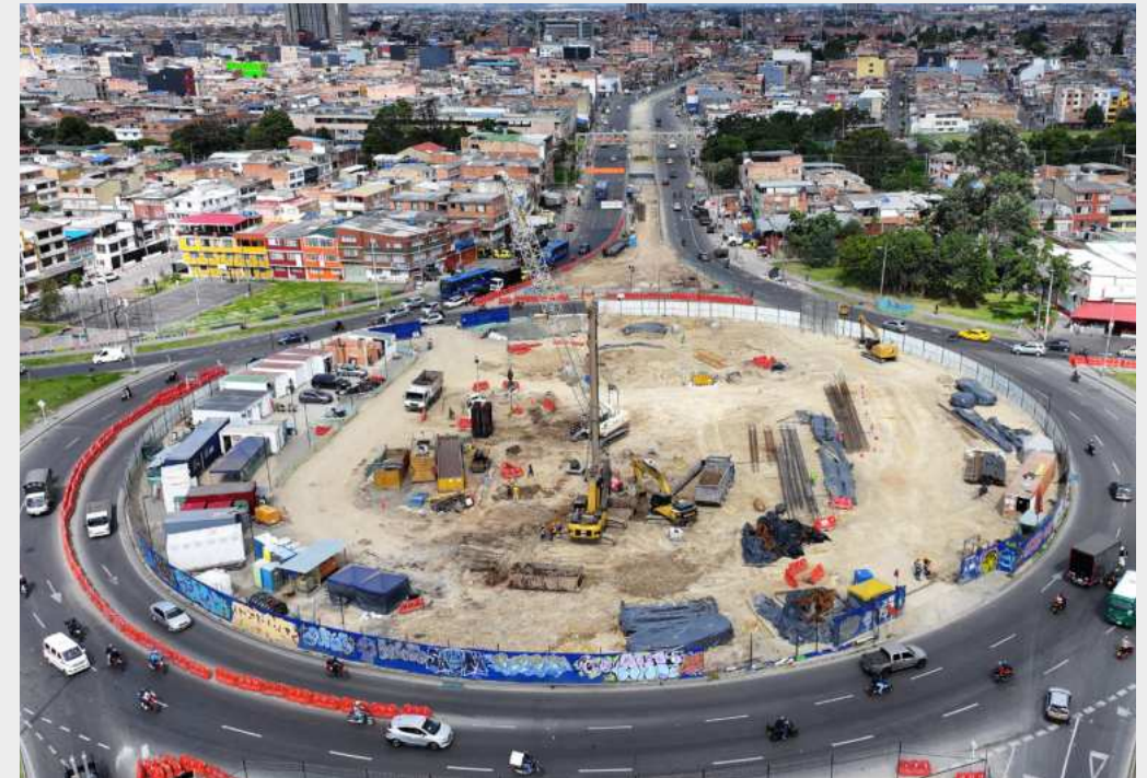
Estación Metro No. 8- Nave Central
