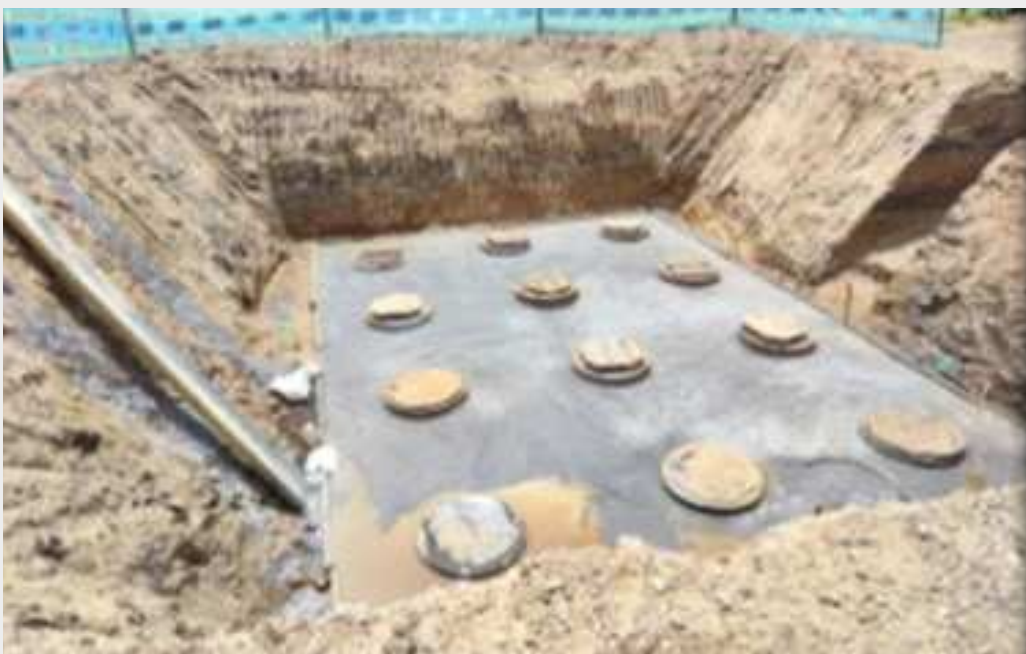
Pilotaje PHC finalizado para el Apoyo S2-10 y Viga capitel del apoyo S1-15
