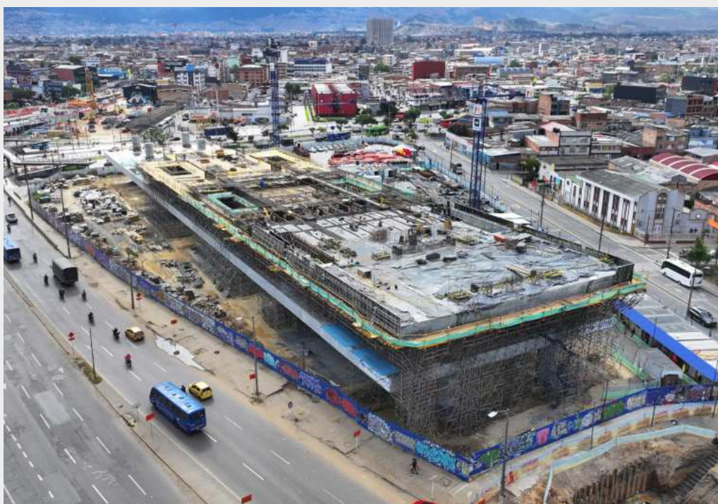
Estación Metro No. 6 – Nave Central
