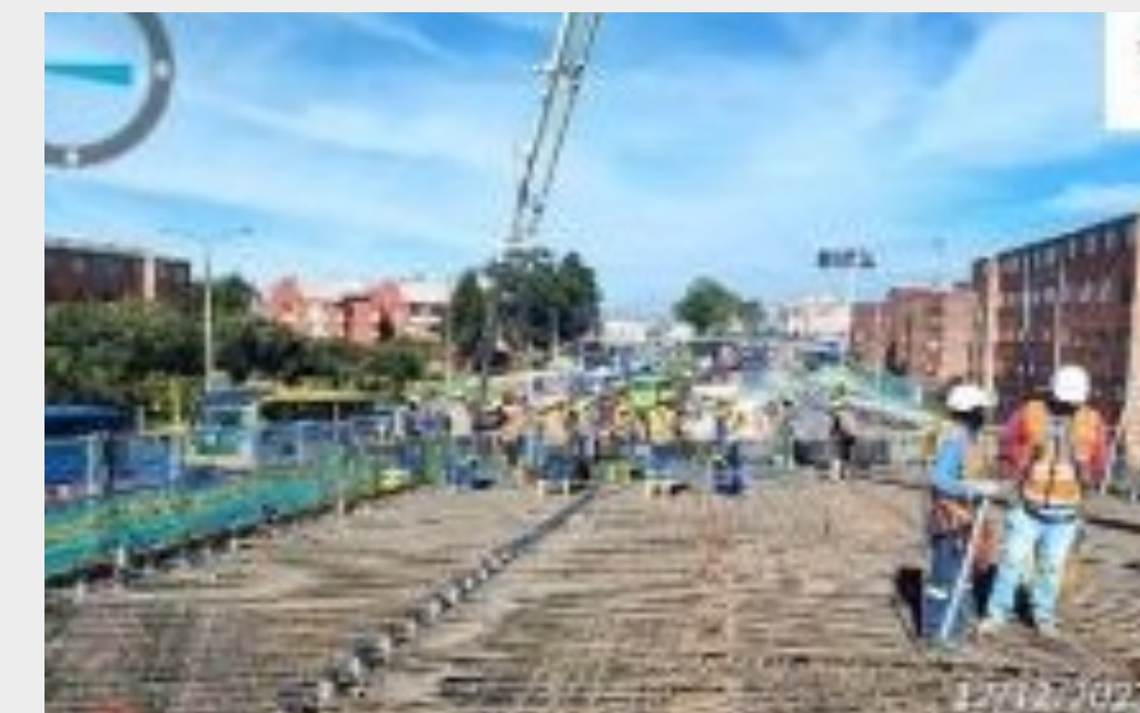
VIGA CAJÓN ENTRE APOYO 1 Y 2: Finaliza construcción de la viga cajón y se realiza tensionamiento de los cables del 35 al 44
