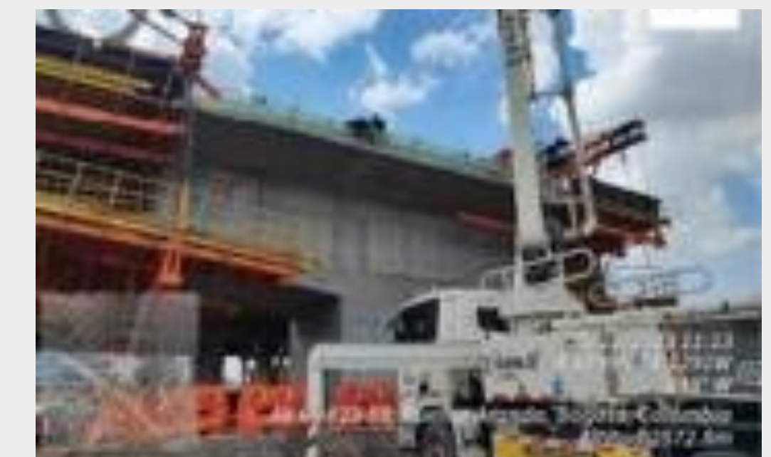
APOYO 3: Finaliza construcción de las dovelas 2 de (voladizos 1 y 2)
