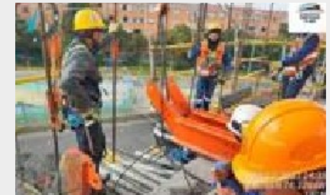
APOYO 3: Se realiza tensionamiento de cales 3 y 4 de dovelas 1 de (voladizos 1 y 2)
