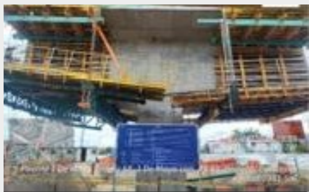
APOYO 4: Finaliza instalación de carros de avance de voladizos 3 y 4
