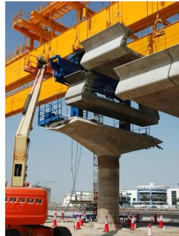
**Ilustración 63. Pila del metro de Dubai (antes y durante construcción de tableros)**
