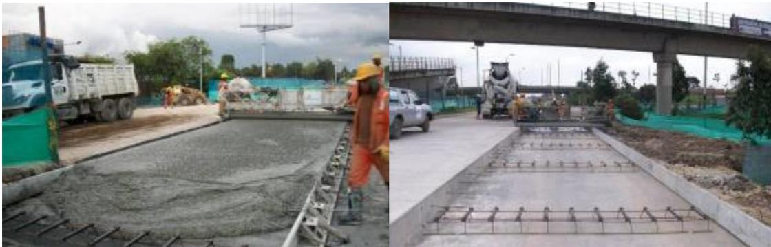
**Ilustración 170. Construcción concreto neumático carril BRT**
