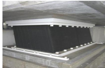
**Ilustración 67. Aparato de apoyo de tipo LRB**
