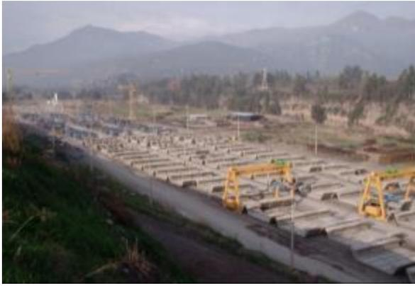
**Ilustración 156. Zona de acopio en parque de prefabricación (línea 4 metro Santiago de Chile)**
