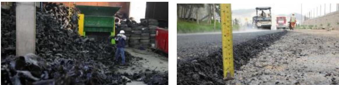
**Ilustración 171. Construcción de capa de rodadura con la utilización de material reciclado de llantas**
