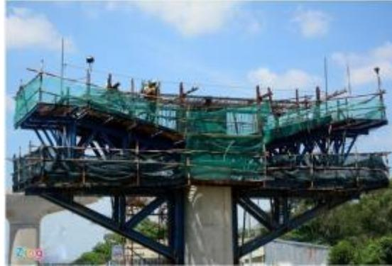
**Ilustración 149. Construcción de capitel in-situ. Fuente: SYSTRA**
