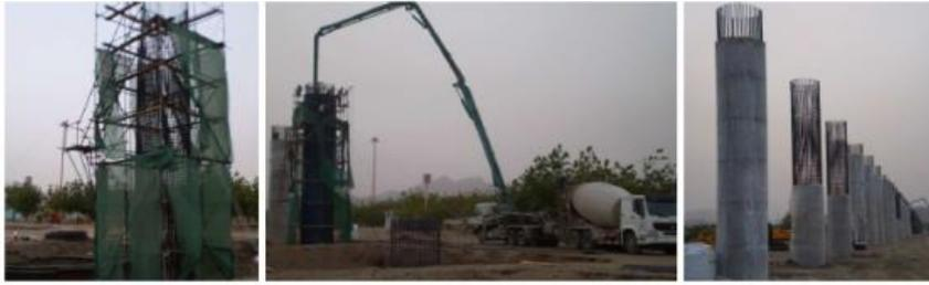
**Ilustración 148. Construcción in-situ de elementos de subestructura. Fuente: SYSTRA**
