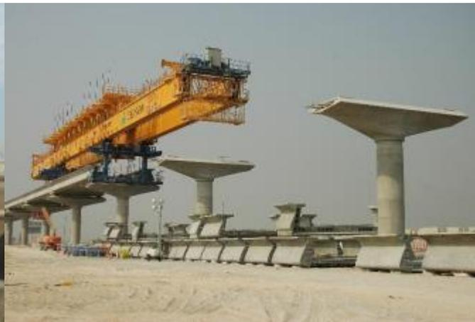
**Ilustración 159. Ubicación de dovelas con viga lanzadora. Acopio de dovelas en obra previo a montaje con viga lanzadora**
