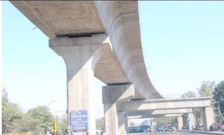
**Ilustración 64. Soportes especiales soportando viaducto de metro elevado**
