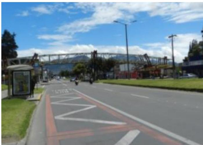
**Ilustración 7. Puente peatonal metálico Av. 1 Mayo con Cra. 39. Ejemplo de puentes peatonales que presentan interferencia con el proyecto. Fuente: Propia Consorcio Metro-Bog**
