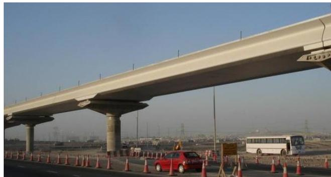
**Ilustración 40. Módulo continuo de dos vanos en Red Line del Metro de Dubai - Fuente: Consorcio Metro-Bog**
