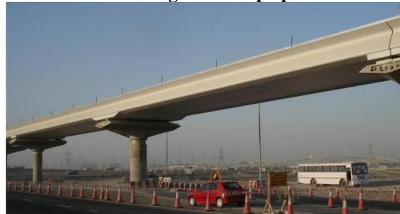
**Ilustración 56. Módulo continuo de dos vanos (Metro de Dubai)**
