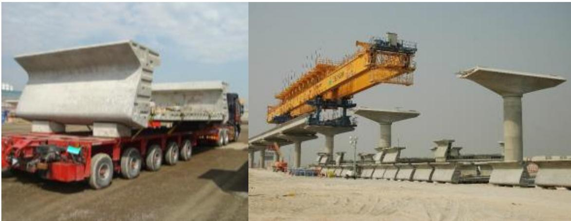
**Ilustración 158. Transporte de dovelas del parque a obra mediante camión-remolque**
