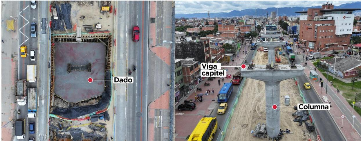
*La construcción de la subestructura del viaducto se compone de dados, columnas y vigas capiteles.*
