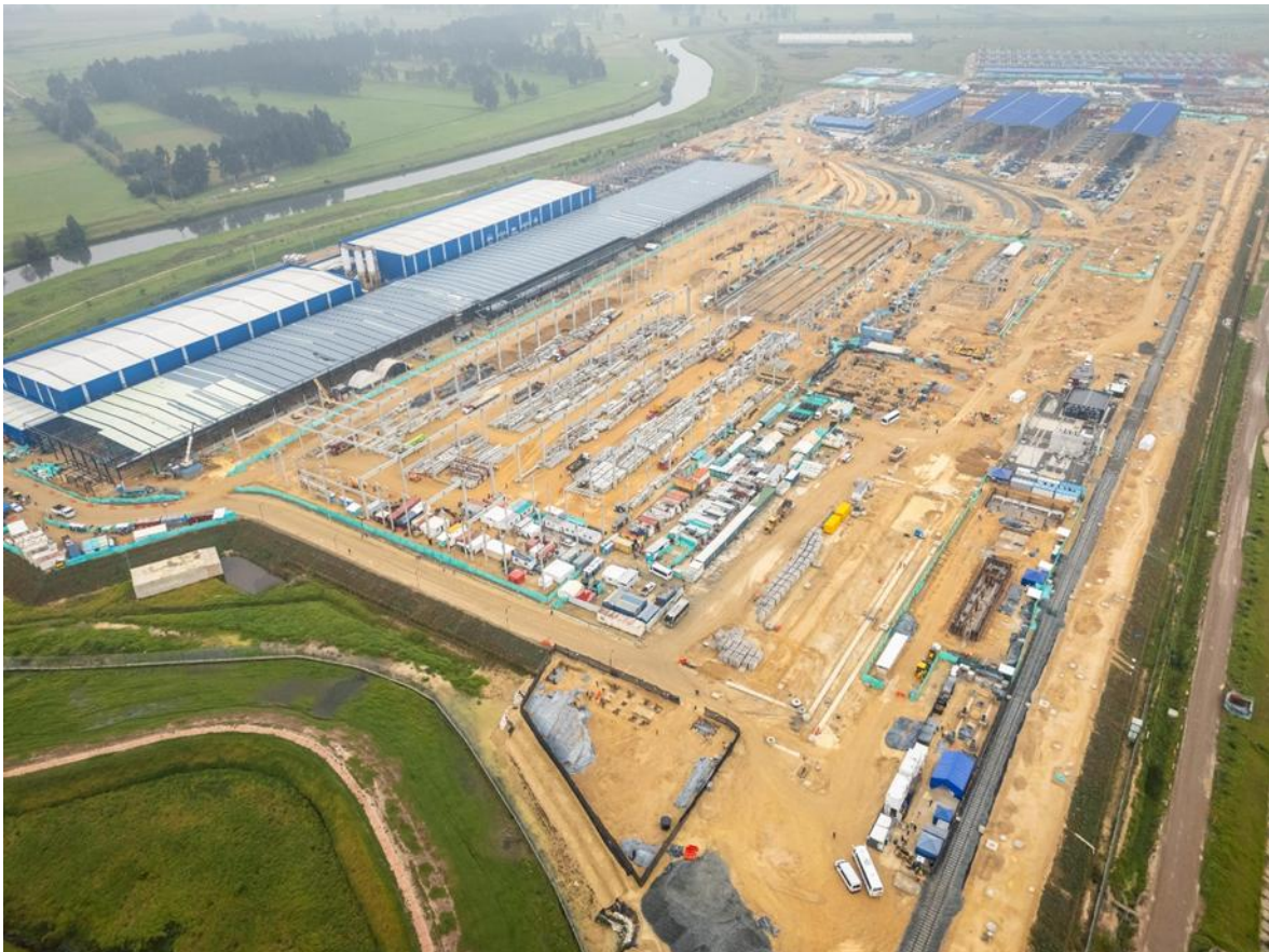
La magnitud del patio taller apreciada desde el aire. Foto: Diego Vega. Empresa Metro de Bogotá.
