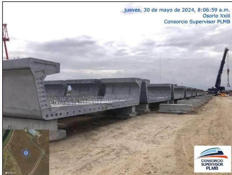
Figura 3.2.1.2-2. Vigas U almacenadas en la planta almacenamiento Vigas U.
