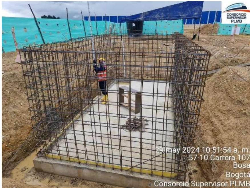
Figura 3.2.1.1-19. Losa de fondo y armado de refuerzo de los muros de la caja de entrada de la SER 1.
