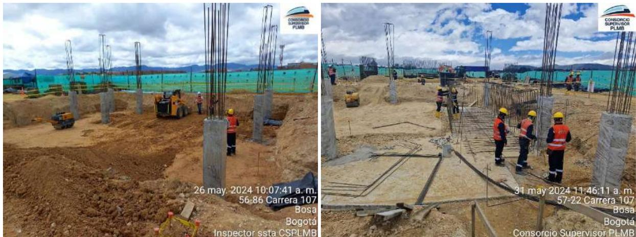
Figura 3.2.1.1-17. Columnas a nivel de entrepiso y relleno en caseta de control SER 1.
