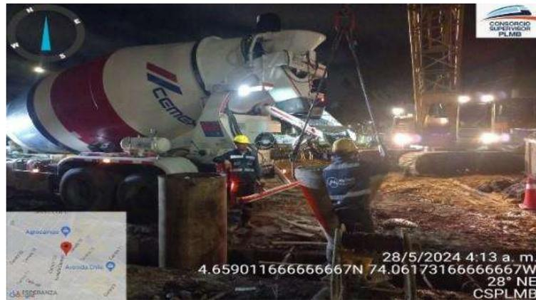
Figura 3.2.1.3-9 Vaciado de concreto para la pantalla No. 179, sector S3E.
