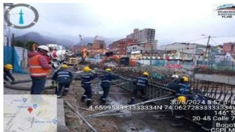
Figura 3.2.1.3-4. Vaciado de concreto viga soporte barrera de tráfico sector occidental
