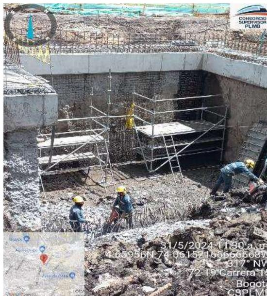
Figura 3.2.1.3-11 Excavación de la EBALL y descabece de la pantalla Tipo 3, sector nororiental.
