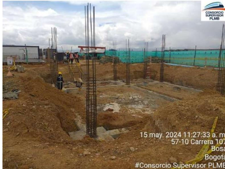
Figura 3.2.1.1-16 Fundida cimentación caseta de control SER 1.
