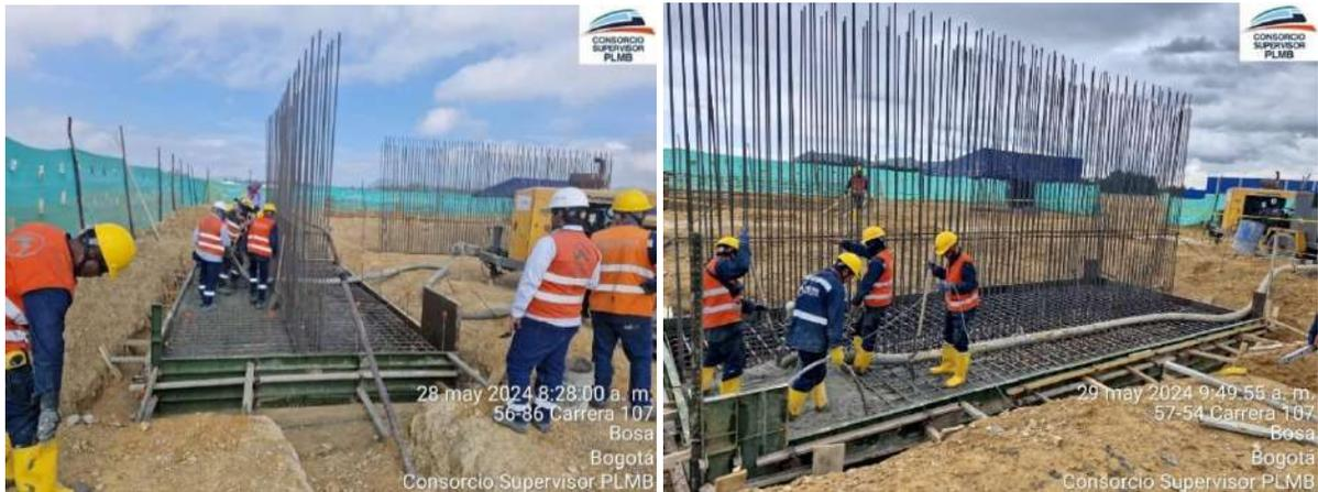
Figura 3.2.1.1-20. Proceso de fundida de las zarpas de los muros cortafuego de la SER 1.
