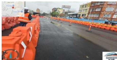
Figura 3.2.1.3-5 Instalación mezcla asfáltica sector caracas occidental.
