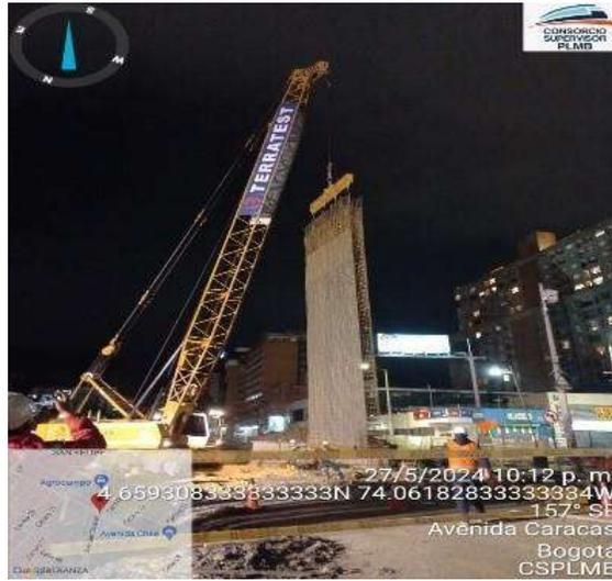
Figura 3.2.1.3-8 Izaje de armado de acero de la pantalla No.179, sector S3E.
