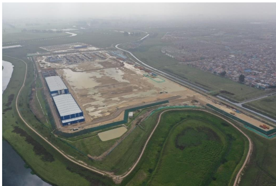
Figura 3.2.1.1-2. Avance físico de obra en Patio taller durante el mes de abril de 2024 planta general
