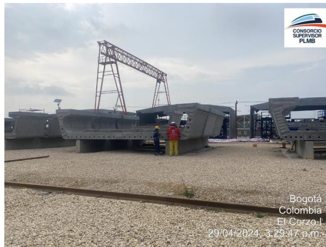
Figura 3.2.1.2-2 Vigas U almacenadas temporalmente en la planta Vigas U.
