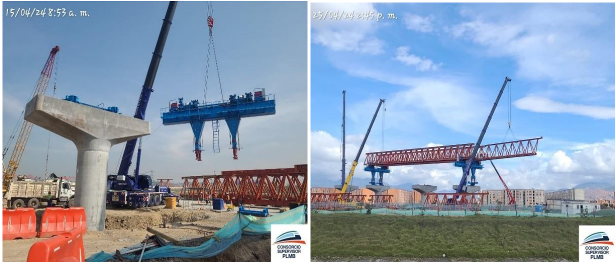
Figura 3.2.1.5.1-1. Avance físico de obra en Frente de Trabajo 1 (WF1) – zona de Ramal técnico, durante el mes de abril de 2024
