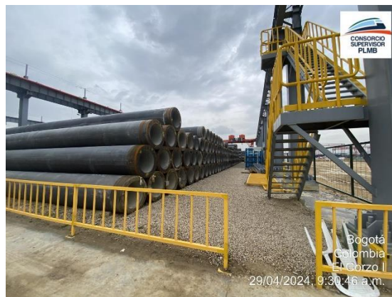
Figura 3.2.1.2-1 Almacenamiento- Producción de módulos PHC
