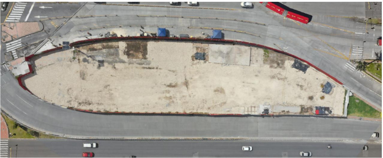
Figura 3.2.1.5.6-1. Avance físico de obra en UE-039 – zona de los Héroes, durante el mes de enero de 2024 planta general
