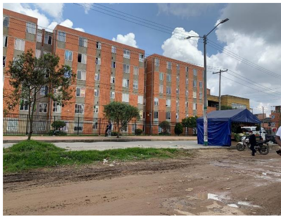
Fotografía 32. Vivienda VIS de Propiedad Horizontal en el Porvenir (Parcela)
