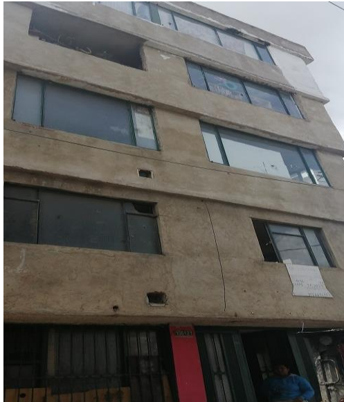
Fotografía 14. Construcción en proceso de ampliación barrio El Recuerdo de Santafé
