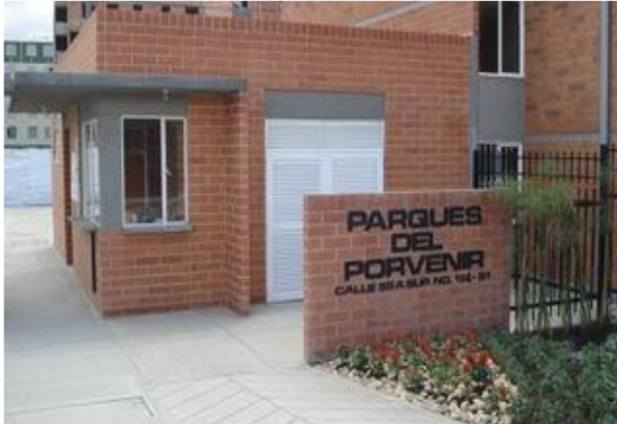
Fotografía 15. Conjunto Residencial Parques del Porvenir. Calle 56 F Sur Carrera 106
