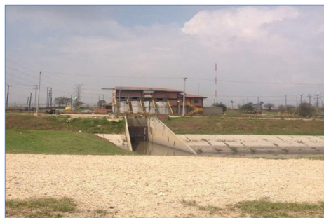
Fotografía 4. Canal Cundinamarca, en el sector que entrega aguas al Río Bogotá, mediante la estación de bombeo
