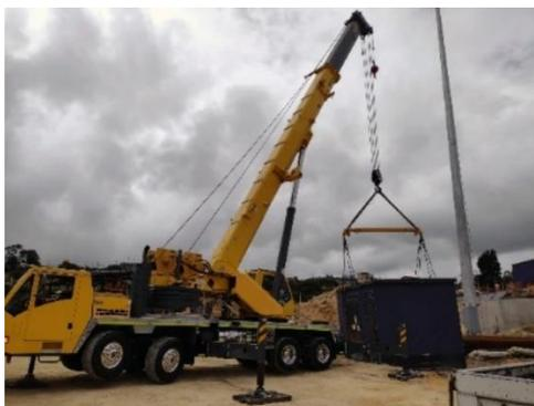
Figura 4 Izaje de planta eléctrica
