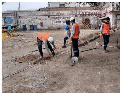
Figura 6 Construcción de redes eléctricas subterráneas
