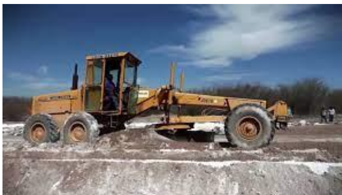
Figura 3. Estabilización con cal – Nivelación
