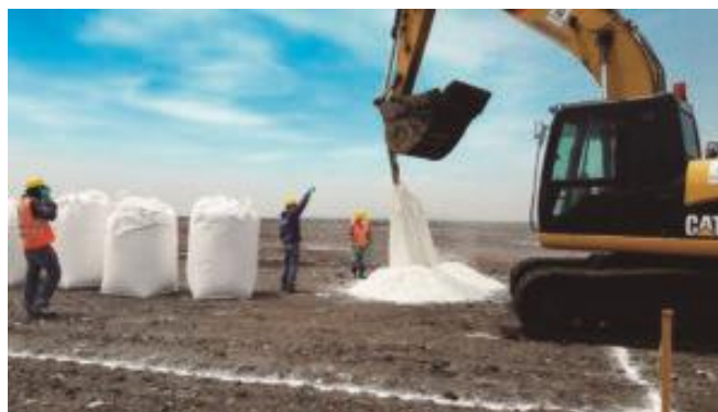
Figura 2. Estabilización con cal – Mezclado
