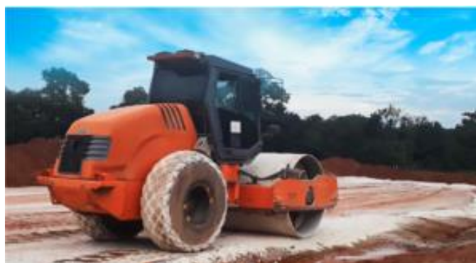
Figura 4. Estabilización con cal – Compactación y curado
