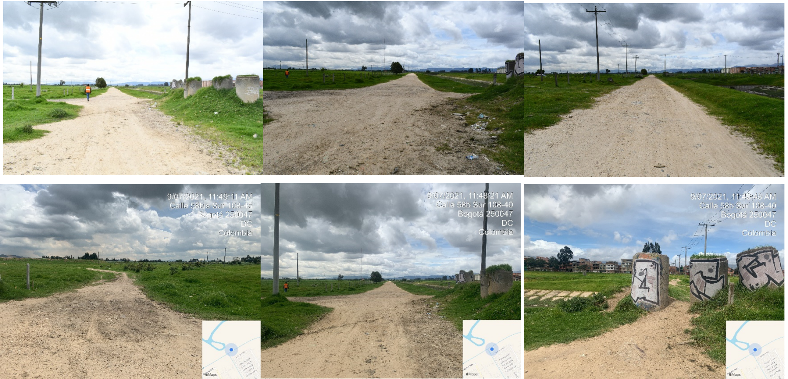
Figura 11. Vía del acueducto
