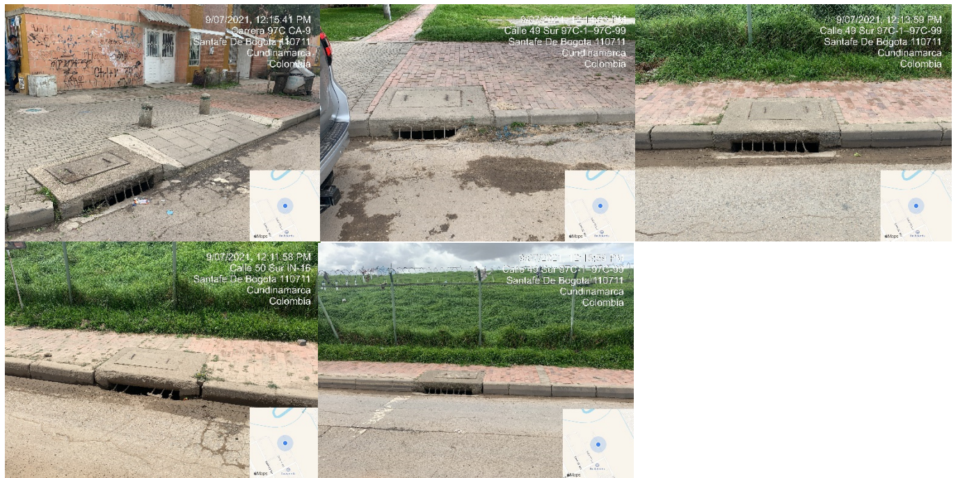
Figura 12. Sumideros cercanos a la entrada
