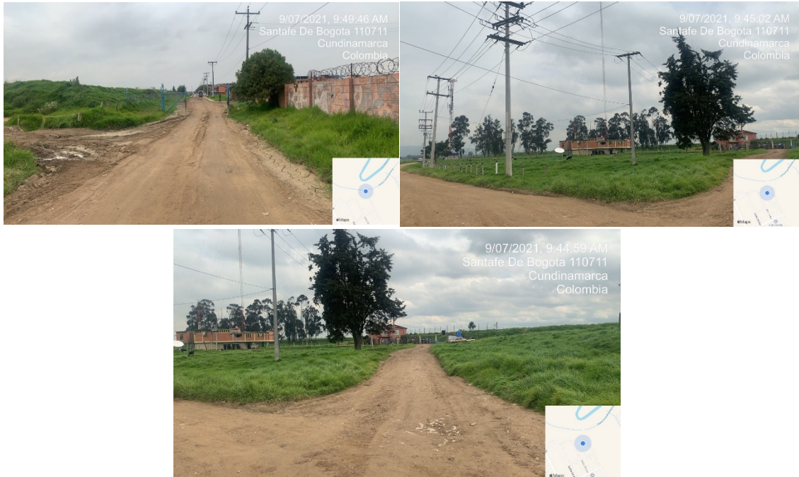
Figura 2. Estado vía de acceso - Patio Taller
