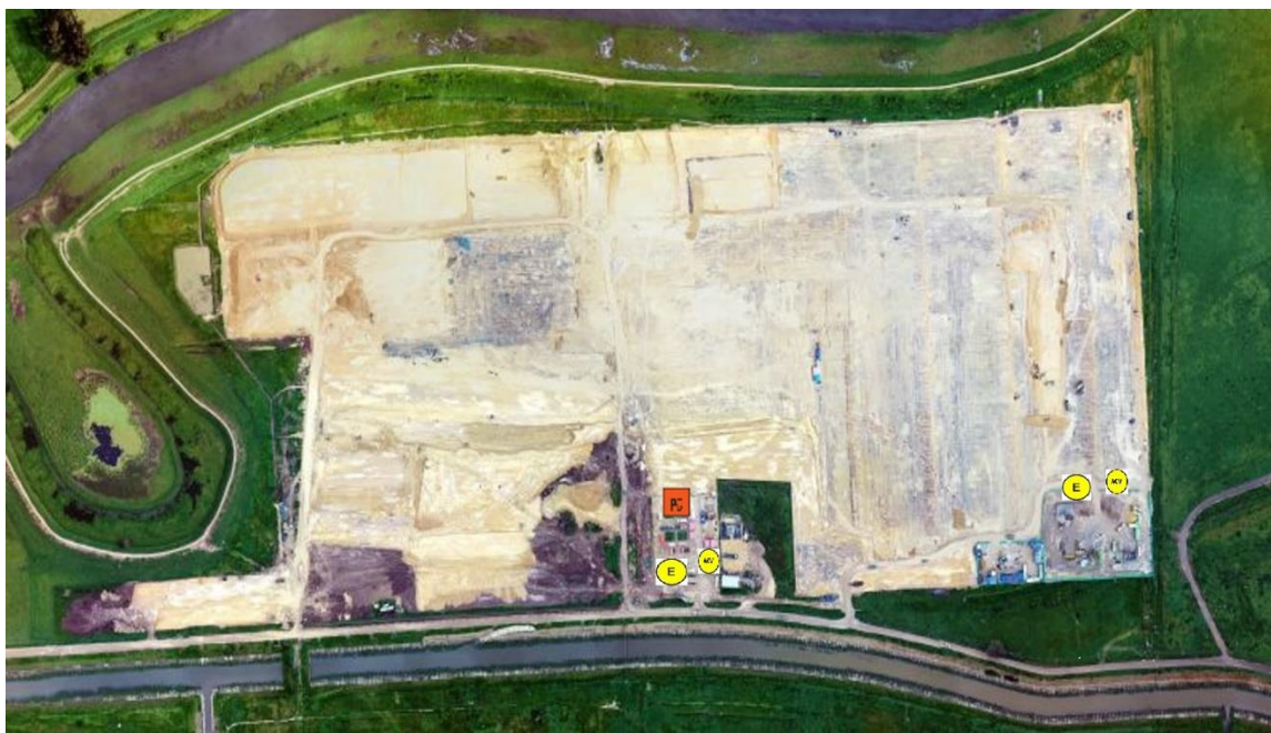
Figura.12 Instalaciones Sistema Comando Incidentes (Consortio Ambiental Metro Bogota Línea 1, 2022)
