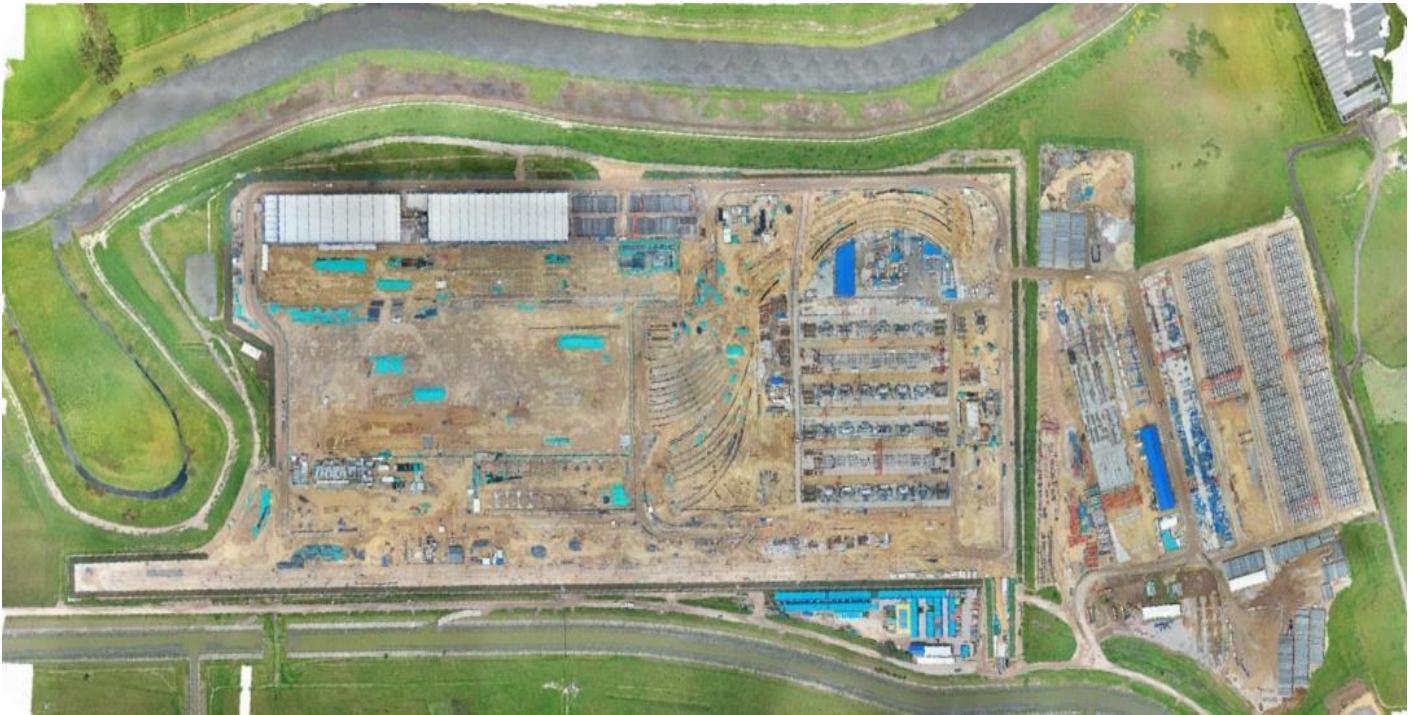
Figura 3.3-10. Avance físico de obra en Patio taller durante el mes de febrero de 2025 planta general
