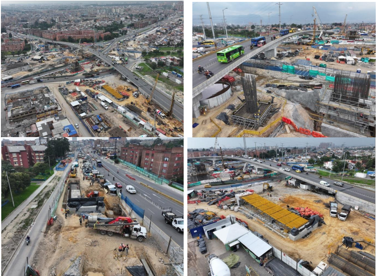
Figura 3.3-17. Registro Fotográfico Puente Norte AV. 68
