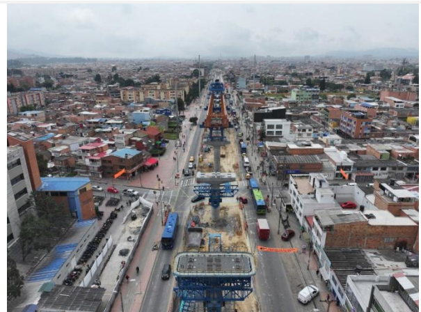
Viga Lanzadora 6 (S5-17)
