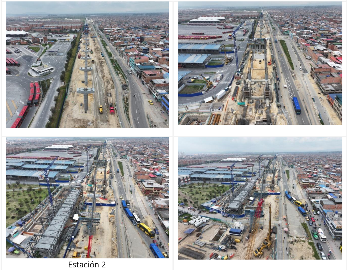
Figura 3.3-20 Avance físico de obra en Frente de Trabajo 1 (WF1), durante el mes de febrero 2025
