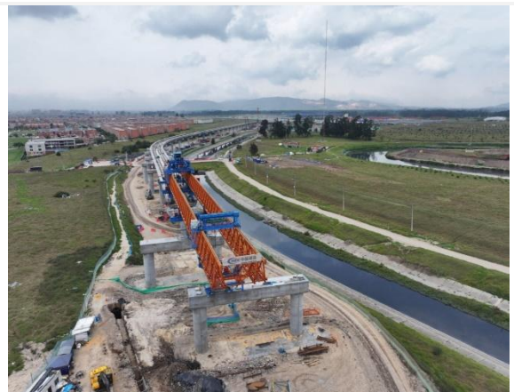
Viga Lanzadora 1 (S1-34)
