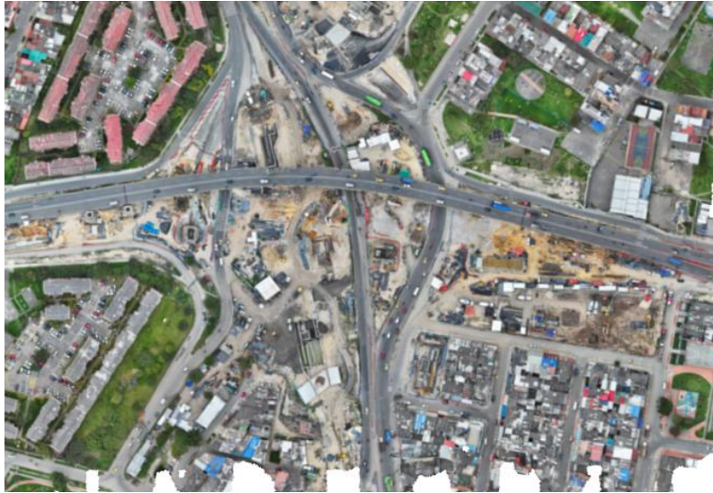
Figura 3.3-16. Avance físico de obra en Av. 68 con Av. 1ro de mayo durante el mes de febrero de 2025 planta general
