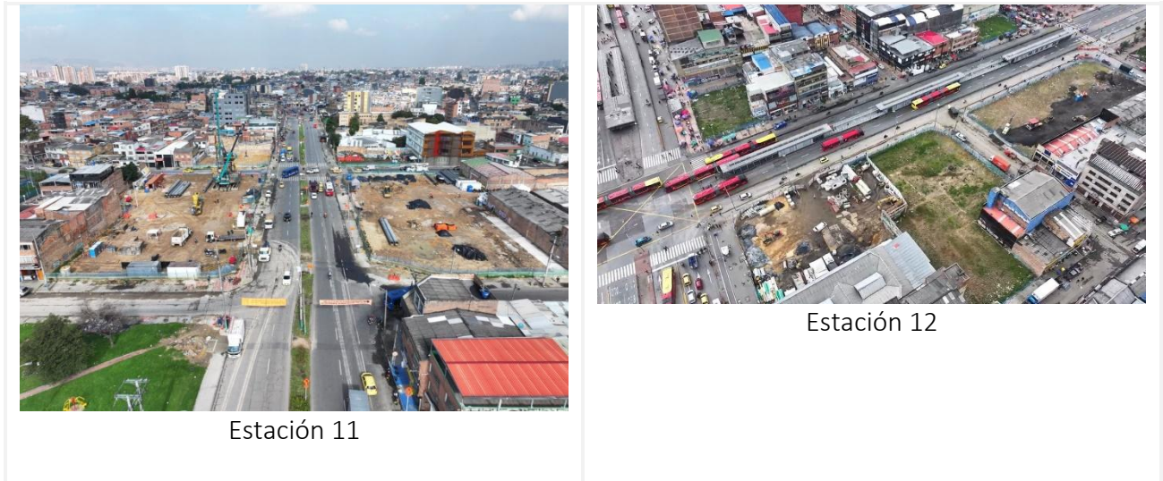
Figura 3.3-23. Avance físico de obra en Frente de Trabajo 4 (WF4), durante el mes de febrero 2025
