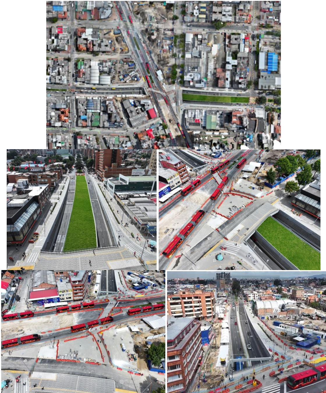
Figura 3.3-14. Intersección Avenida calle 72.
