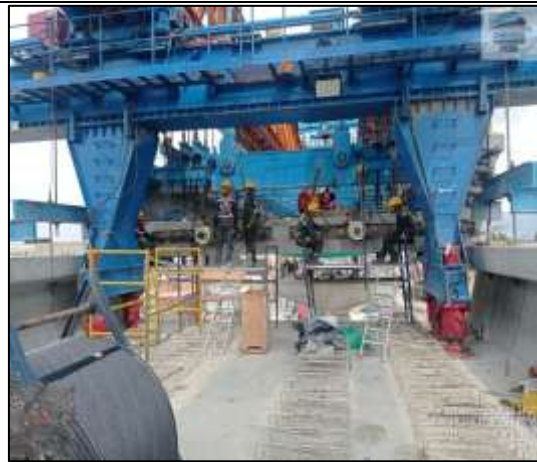
Se realiza tensionamiento de los vanos del S05-13 al S05-16
