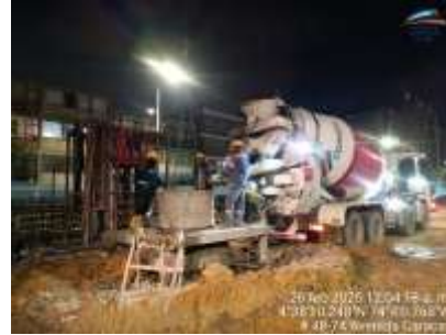
Ilustración a.2.9-1. Fabricación de pilotes pre-excavados UE044
