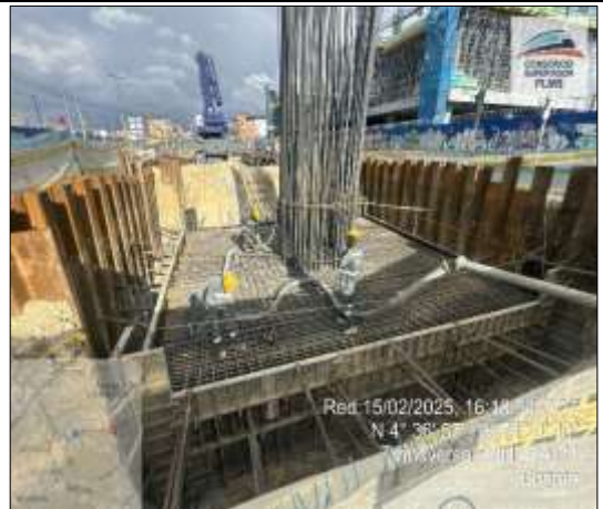
Apoyo E4-3 se realiza instalación de tablestacado para construcción de dado de cimentación.
