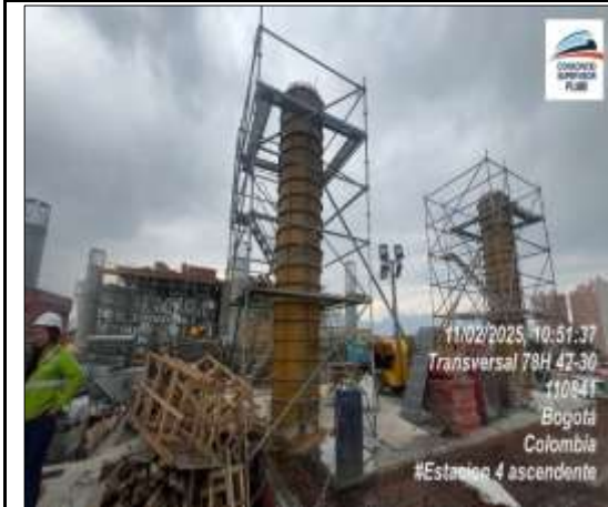
Se hace instalación de formoletas para columnas del eje E en Placa Intermedia del Edificio 1
