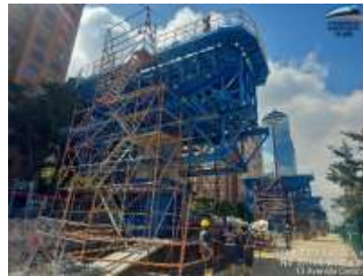
Ilustración a.2.8-7. Amarre de acero viga capitel Apoyo S14-18
