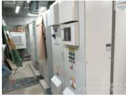
Ilustración a.2.2-10. Instalación de equipos y pruebas, EBALL.
