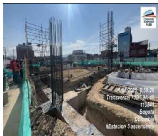
Armado y configuración de aceros en columna B-1
