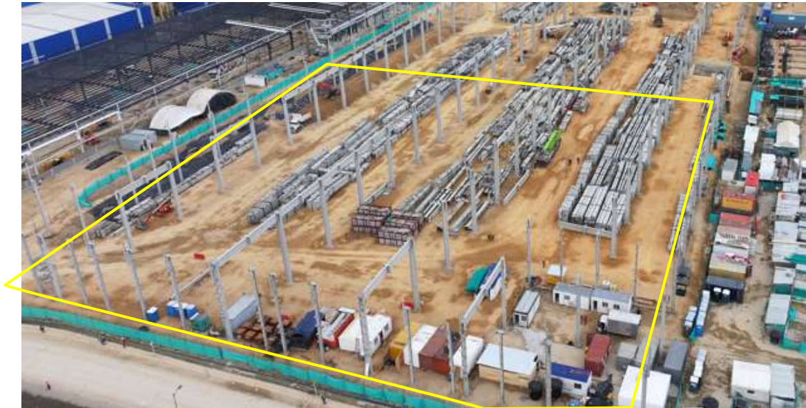
Ilustración a.2.1-8. Avance general de actividades UE 36 Edificio 105, locales técnicos, montaje de columnas y vigas aéreas estructura metálica.
