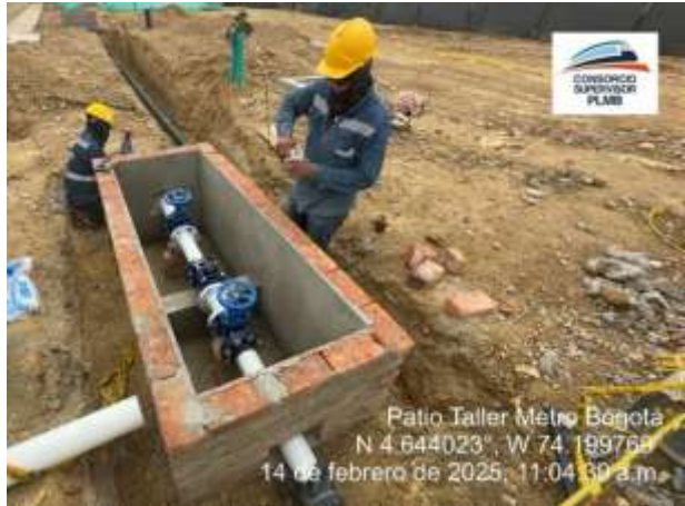
Ilustración a.2.1.-18. UE 38 Redes externas patio taller. Red alcantarillado pluvial y presión.
