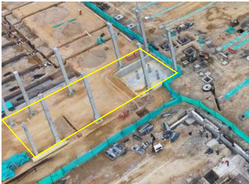
Ilustración a.2.1-11. UE 36 Edificio 111, CCO de respaldo avance de obra al 28 de febrero de 2025 montaje de columnas estructura metálica.
