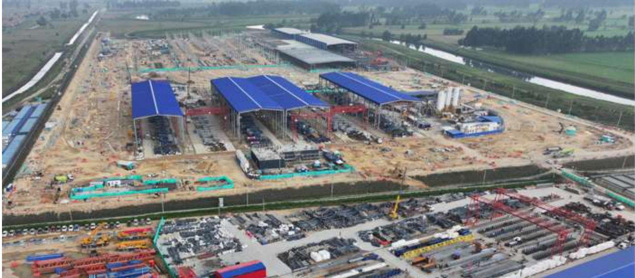
Ilustración a.2.1-24. Avance general patio taller vista desde costado sur.
