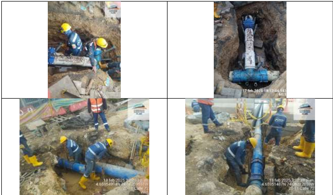
Ilustración a.2.2-11 Tubería HD de 12" Ø sur a norte el deprimido costado occidental
