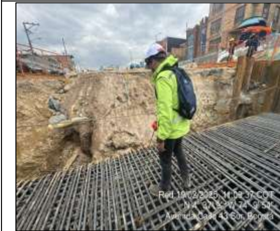
Verificación de armado de acero e instalación de concreto en los dados de cimentación de los apoyos S4-5, S4-8 y S4-9
