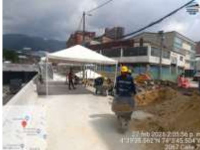
Ilustración a.2.2-5. Construcción de MR en costado suroccidental.
