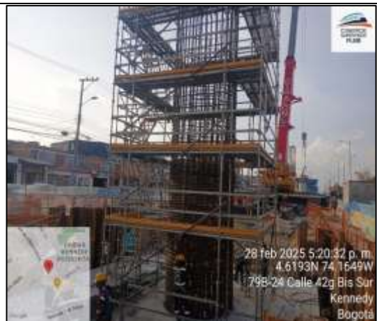
Apoyo S4-9 se realiza verificación de cuantía y configuración de armado de pila
