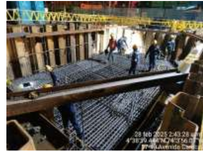
Ilustración a.2.9-9. Construcción para dado de cimentación apoyo S15-43
