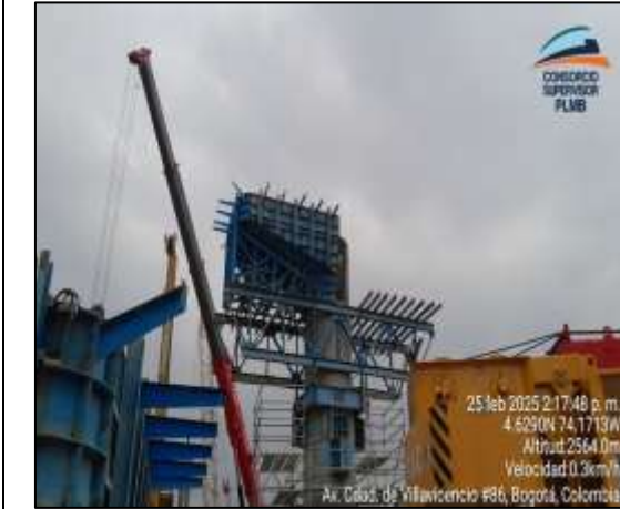
Apoyo S3-03 se realiza el armado de formaleta de la viga
