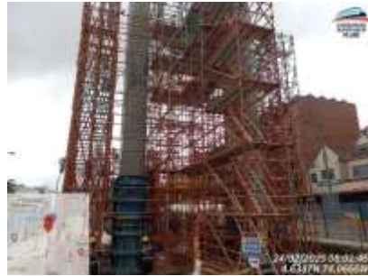
Ilustración a.2.9-6. Desencofre de columnas Apoyo S15-25
