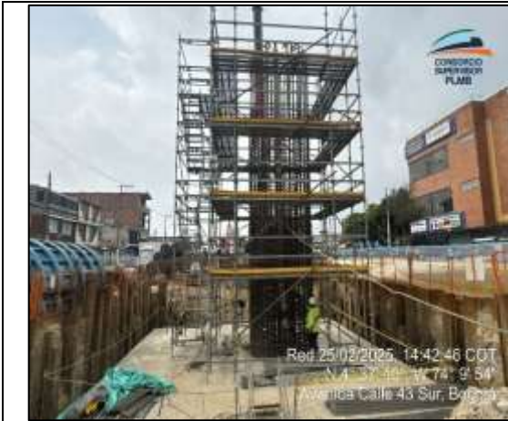
Verificación de armado de acero e instalación de concreto en las pilas de los apoyos S4-5, S4-6 y S4-8
