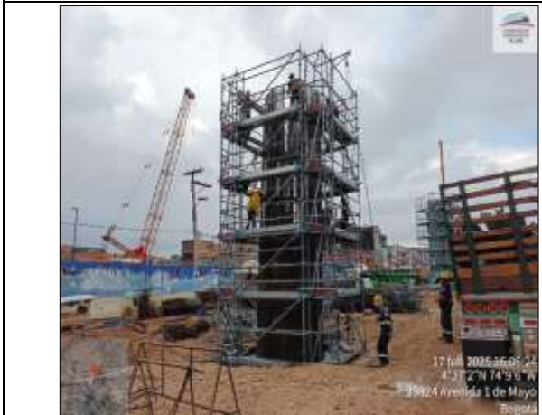
Apoyo E5-6 Se realiza instalación de concreto en columna
