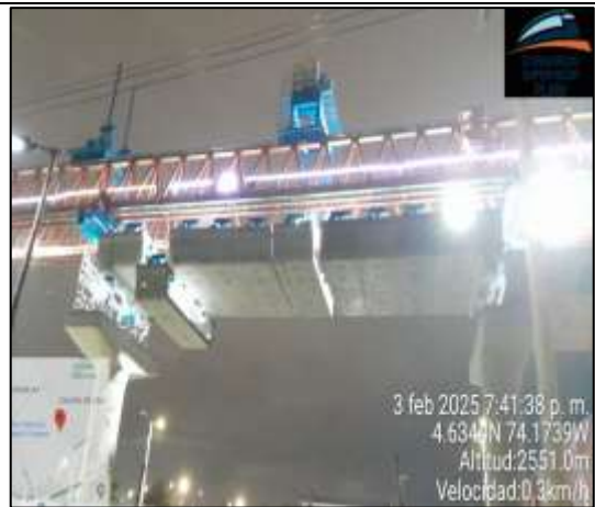
Se realiza la nivelación y posicionamiento de los vanos desde el S02-19 al S02-21
