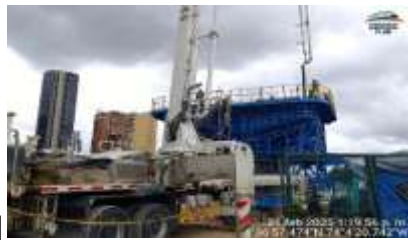
Ilustración a.2.8-1. Vaciado de viga capitel póstica apoyo S14-04.
