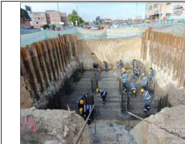
Apoyo E4-1 se realiza armado de acero de refuerzo, parrilla inferior de zapata.
