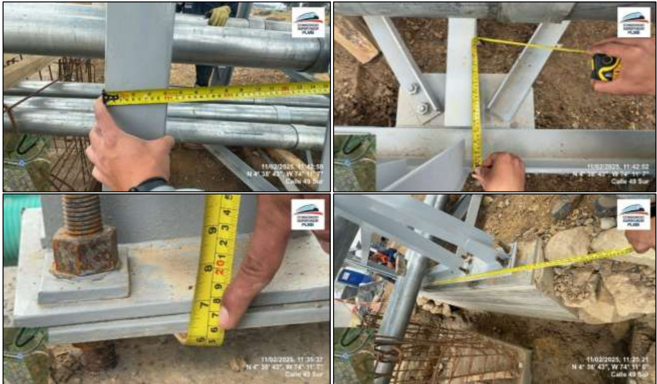
Ilustración a.2.4-4. Registro fotográfico verificación estructural Fuente: Elaboración propia
