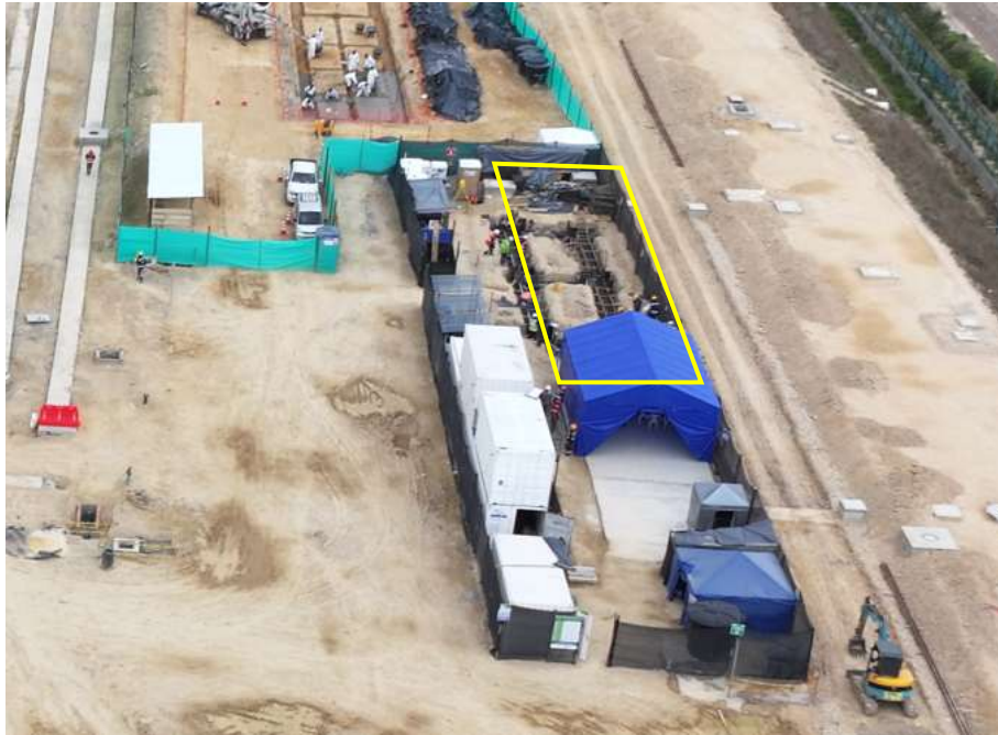
Ilustración a.2.1-14. UE 381 Edificio 900, Zona de Pruebas de PDAP avance de obra al 28 de febrero de 2025, Acero para cimentación.
