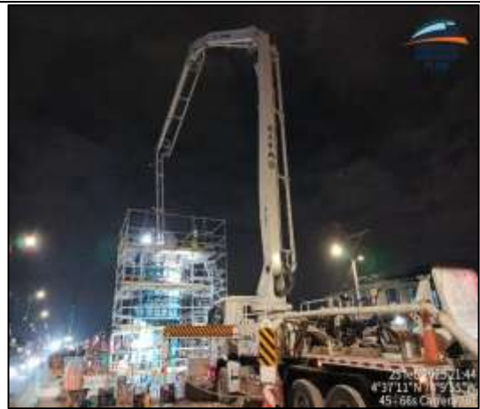
Verificación de armado de acero e instalación de concreto en las pilas de los apoyos S4-5, S4-6 y S4-8
