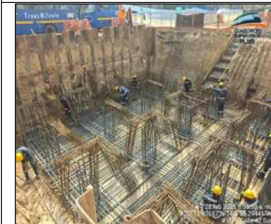
Apoyo S4-7 se realiza el armado e instalación de acero de refuerzo en el dado de cimentación
