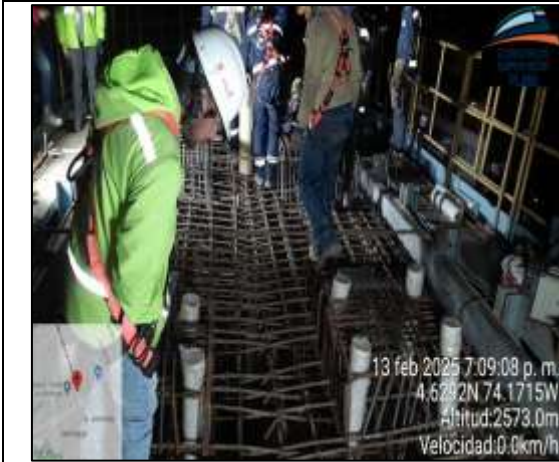
Se realiza la instalación de formaleta de los apoyos S3-01 y S3-02
