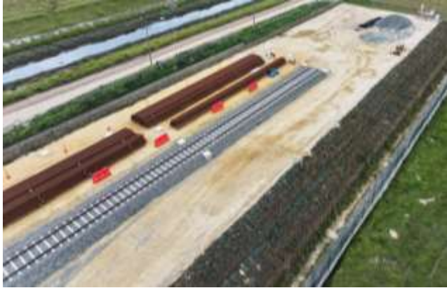
Ilustración a.2.1-22. Montaje de rieles para vía de prueba y área de almacenamiento en patio taller.
