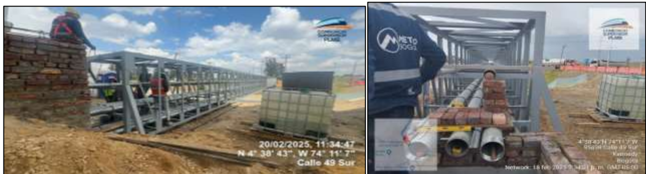
Ilustración a.2.4-2. Registro fotográfico de las actividades adelantadas de la red eléctrica ENE1-01
