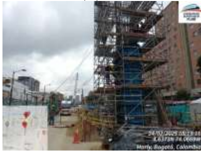
Ilustración a.2.9-5. Descabece de pilotes apoyo S15-20
