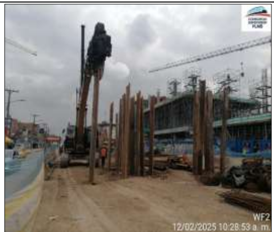
Apoyo E4-3 se realiza instalación de tablestacado para construcción de dado de cimentación.
