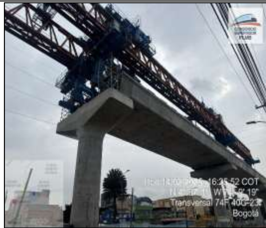
Descenso y posicionamiento de los vanos del S05-13 al S05-16
