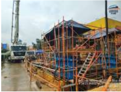
Ilustración a.2.9-3. Vaciado de muro BRT y arranque columnas apoyo S15-27
