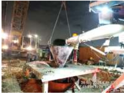
Ilustración a.2.9-8. Fabricación de pilotes preexcavados UE042
