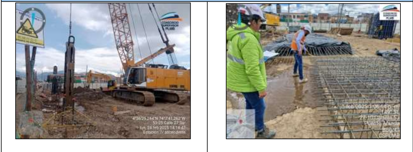
Se realiza excavación para Barrete y revisión de acero de refuerzo.
