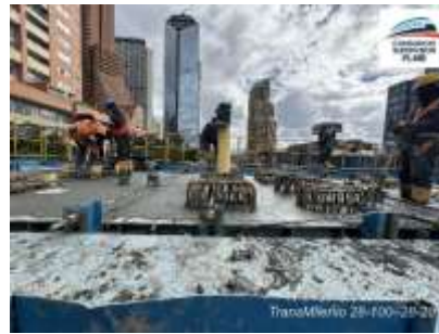
Ilustración a.2.8-9. Vaciado de viga capitel Apoyo S14-14.
