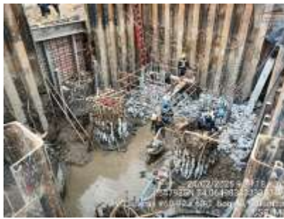
Ilustración a.2.9-11. Descabece de pilotes apoyo S15-55
