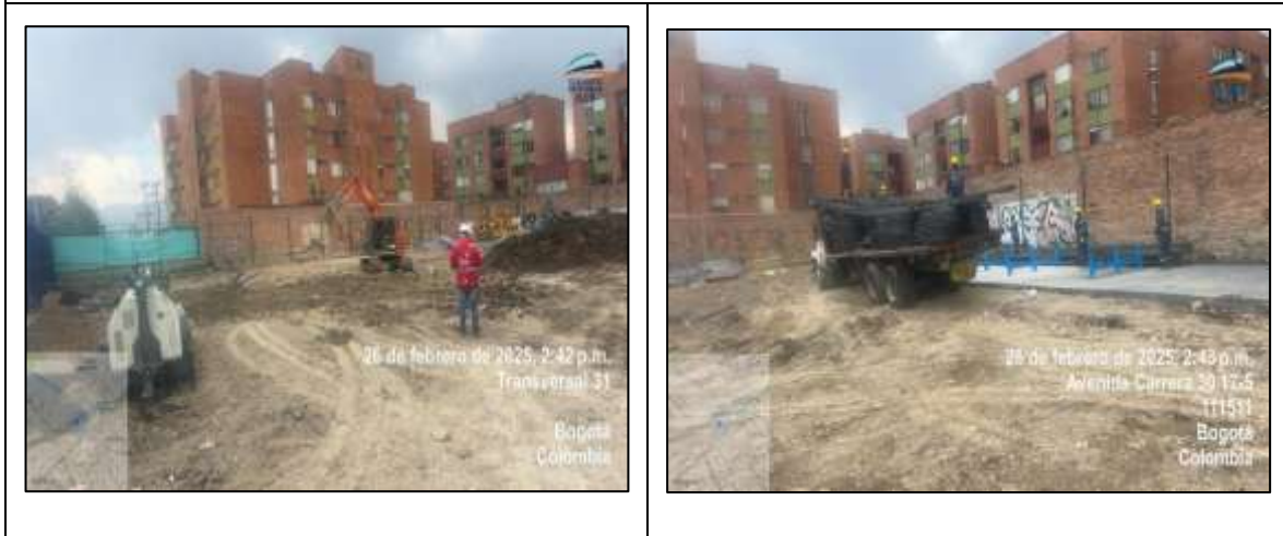
Se adelantan trabajos de retiro de material sobrante y recibo de acero para pilote pre excavado.
