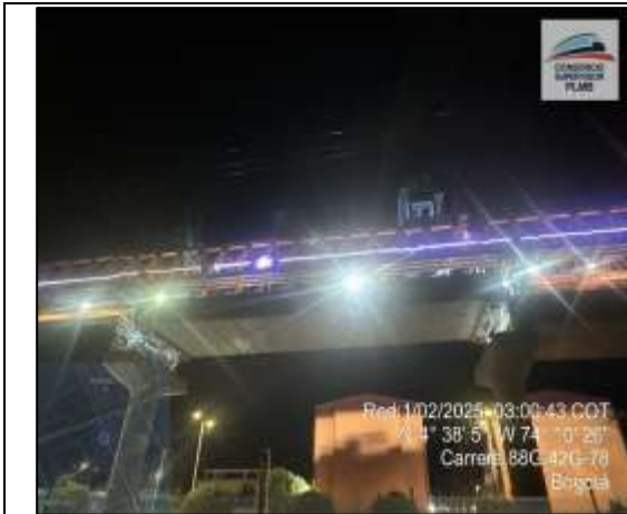
Se realiza tensionamiento de los vanos desde el S02-19 al S02-21
