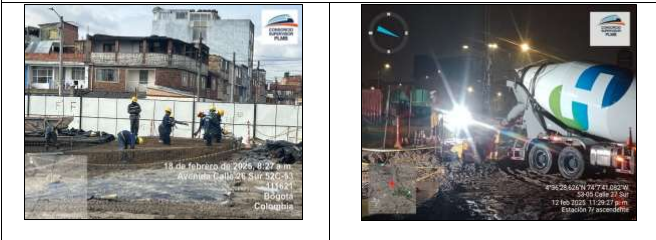
Armado de parrilla para Bárrete y acompañamiento al vaciado.
