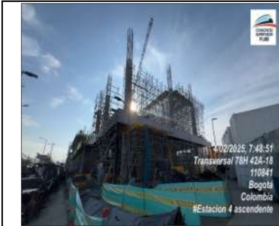
Se continua con la instalación de obra falsa en Edificio 1, para nivel de plataforma
