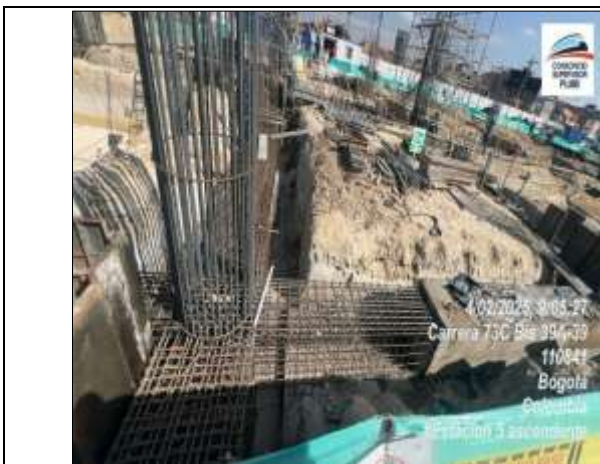
Armado y configuración de aceros en dado eje C-3
