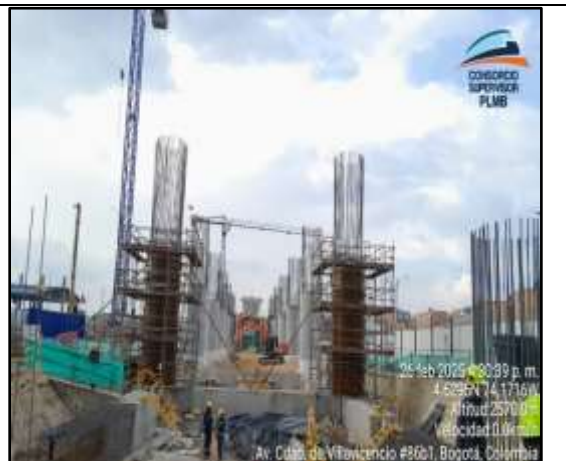
Instalación de concreto en columnas eje 7B y 7D Nave Central
