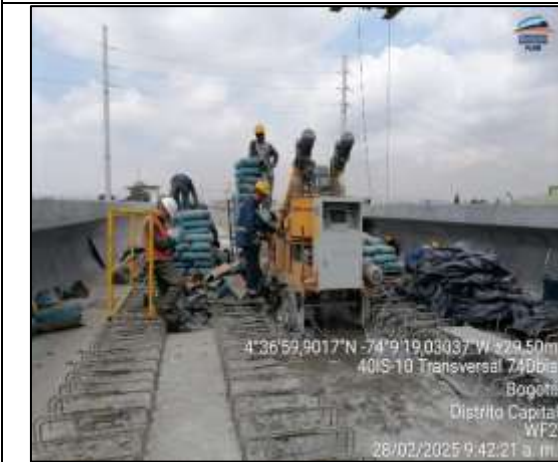
Se realiza inyección de lechada en ductos en el vano S05-15
