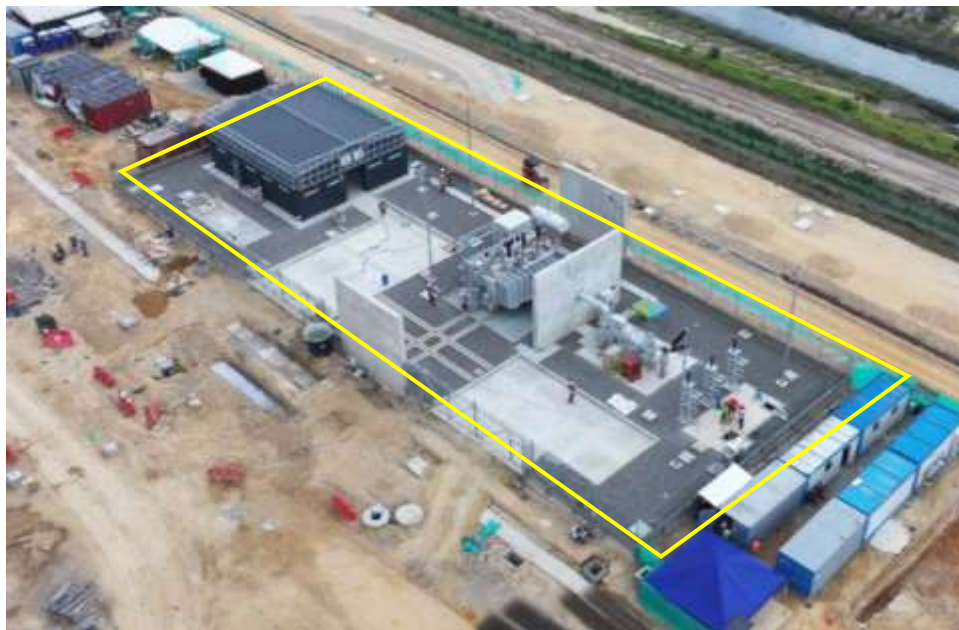
Ilustración a.2.1-15. Avance general SER 1 vista sur-occidental, se aprecia el avance de las obras al 28 de febrero 2025, con un porcentaje de ejecución del 98.65%.
