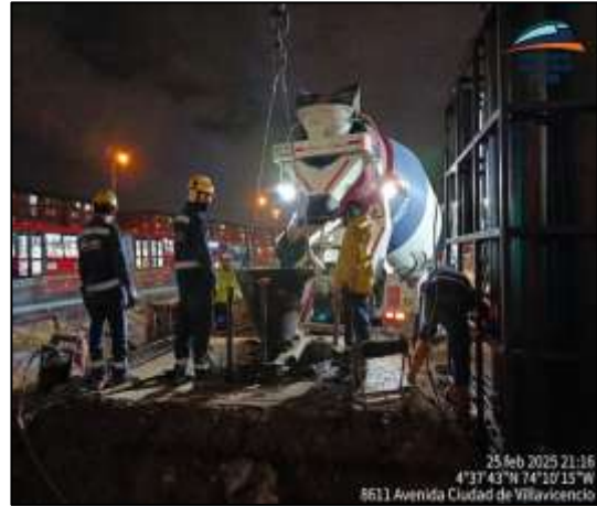
Se realiza el vaciado del pilote No.9 del apoyo S3-04
