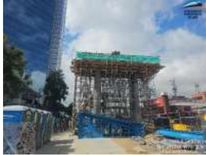
Ilustración a.2.8-3. Amarre de acero viga capitel apoyo S14-09.
