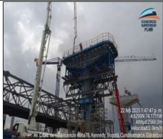
Se realiza el vaciado de la viga capitel de los apoyos S3-01 y S3-02
