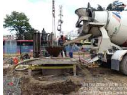
Ilustración a.2.8-11 Construcción de pilotes UE199.
