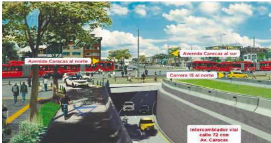
Ilustración a.2.2-1. Paso a desnivel de la Avenida calle 72 por debajo de la Avenida caracas y la carrera 15.
