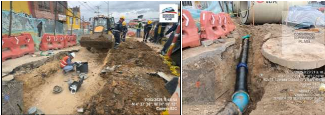
Ilustración a.2.5-8. Registro fotográfico de las actividades adelantadas de la red menor de acueducto ACU2-01 Fuente: Recorrido de interventoría – elaboración propia, registro fotográfico incluido en anexo a.2.5, numeral a.2.5-4 Registro fotográfico actividades realizadas para el traslado de redes
