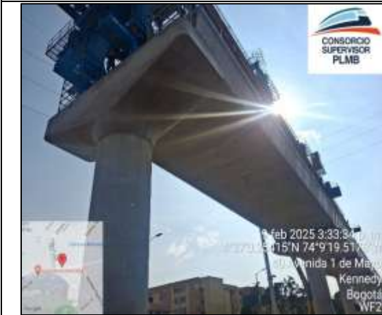
Descenso y posicionamiento de los vanos del S05-13 al S05-16
