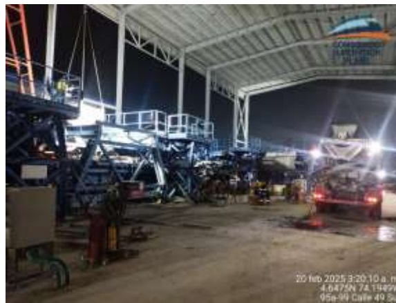
Figura k.ii.2-1-5. Avance Instalación Cubierta Planta de prefabricados de U-Beam.
