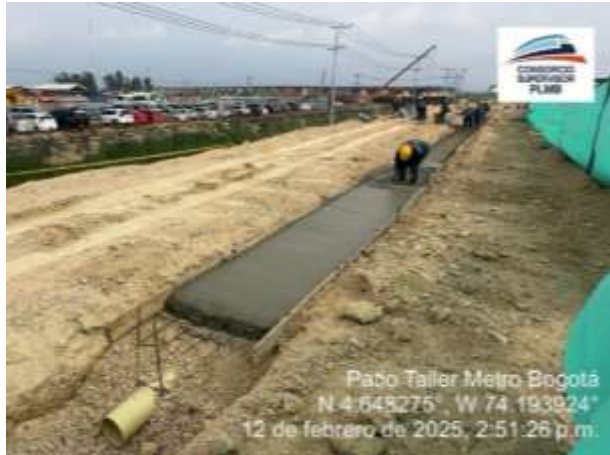
Ilustración a.2.1.-18. UE 38 Redes externas patio taller. Red alcantarillado pluvial y presión.
