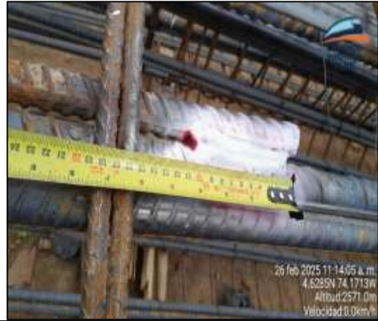
Se realiza la verificación de prueba de tintas en el pilote No.3 del apoyo S3-04
