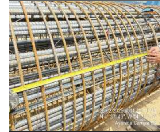
Apoyo S3-04 se realiza verificación de acero de refuerzo del pilote No.3
