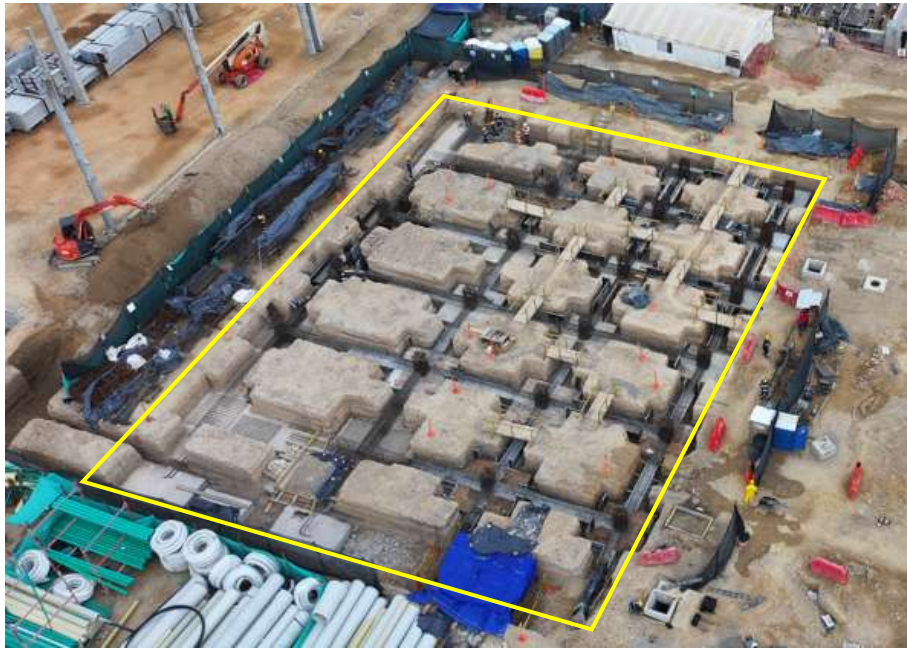
Ilustración a.2.1-2. UE 31 Edificio 102, Administrativo avance de obra al 28 de febrero de 2025, colocación de concretos en zapatas, armado de acero de refuerzo y solados ejes MB-1 y MB-2.
