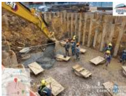
Ilustración a.2.9-13. Vaciado de solado para construcción de dado apoyo S16-01
