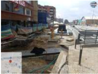
Ilustración a.2.2-3. Instalación de bordillo y espacio público.
