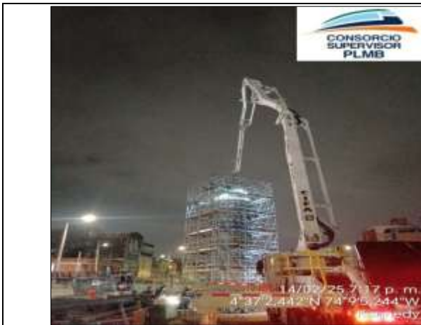
Apoyo E5-6 Se realiza instalación de concreto en columna
