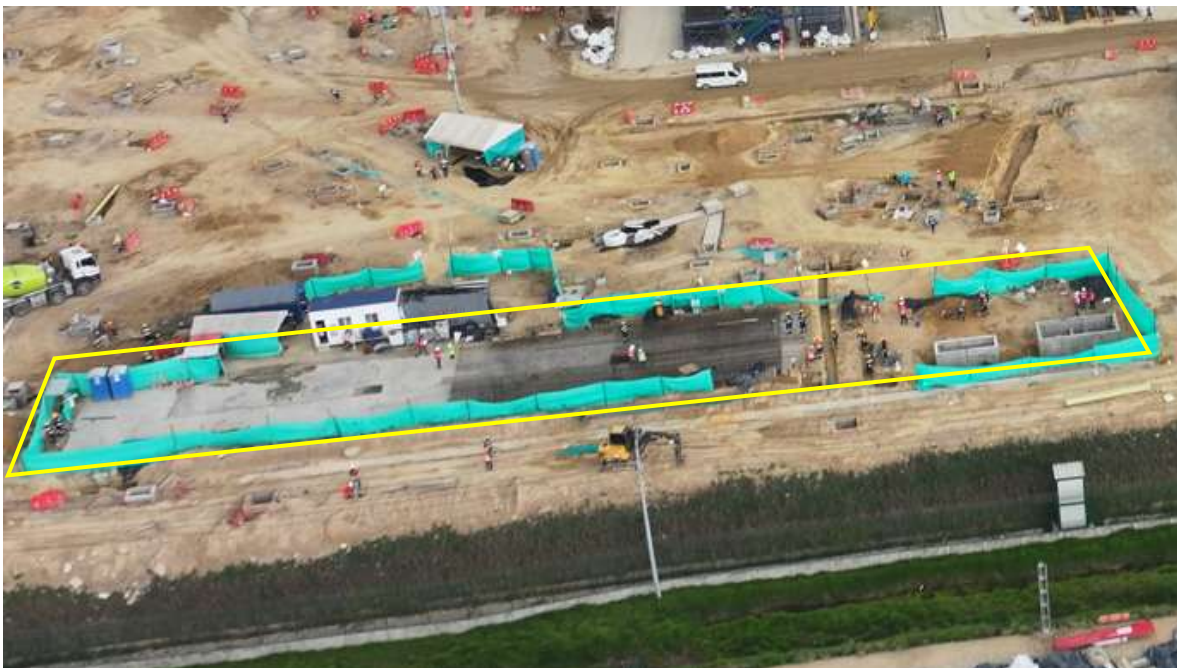
Ilustración a.2.1-6. UE 34 Edificio 106, Máquina de Lavado avance de obra al 28 de febrero de 2025, armado de acero de refuerzo placa.
