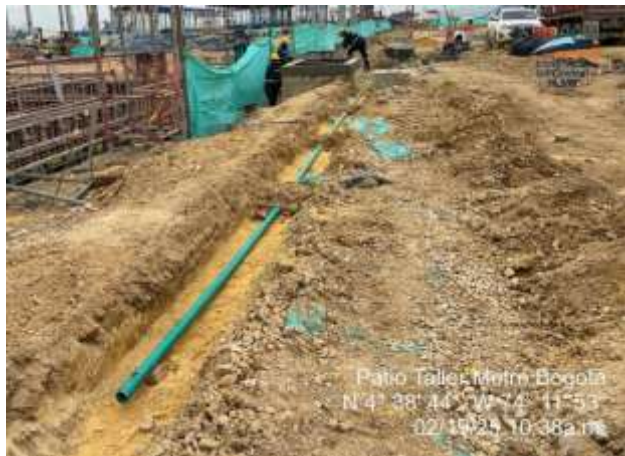
Ilustración a.2.1.-19. UE 38 Redes externas patio taller. Prueba red hidráulica y tubería TDP.
