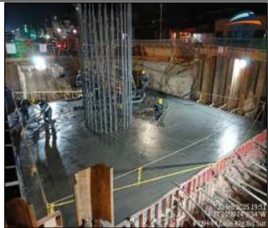
Verificación de armado de acero e instalación de concreto en los dados de cimentación de los apoyos S4-5, S4-8 y S4-9
