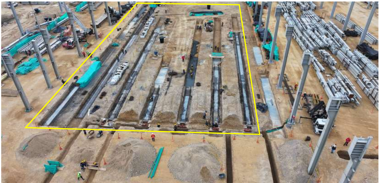
Ilustración a.2.1-10. Actividades UE 36 Edificio 108, Mantenimiento mayor y menor, construcción de fosos para pilarillos.
