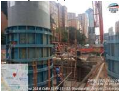
Ilustración a.2.8-8. Desencofre columna S14-20
