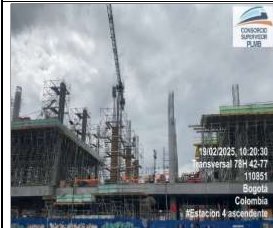
Se hace armado e instalación de concreto columnas placa intermedia en E y en nivel de plataforma columnas eje F'
