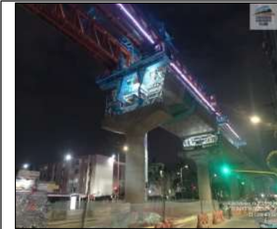
Se realiza tensionamiento de los vanos del S05-13 al S05-16
