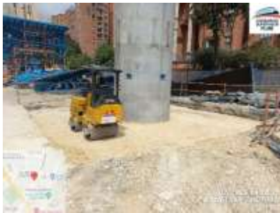
Ilustración a.2.8-6. Lleno y compactación de material granular apoyo S14-15.
