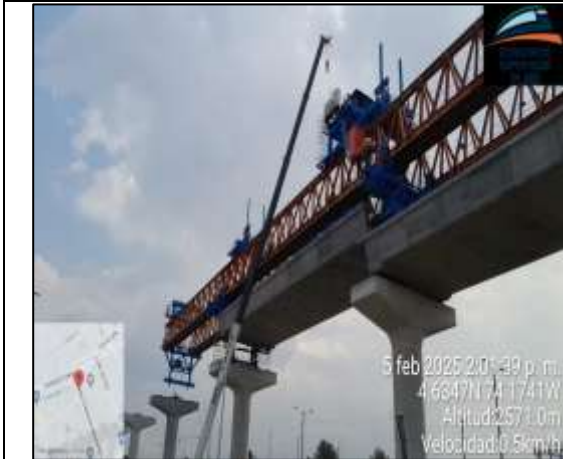
Se realiza nivelación y posicionamiento de los vanos S02-19 al S02-21.
