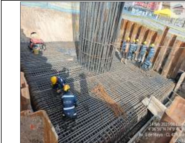
Apoyo E4-1 se realiza armado de acero de refuerzo, parrilla inferior de zapata.
