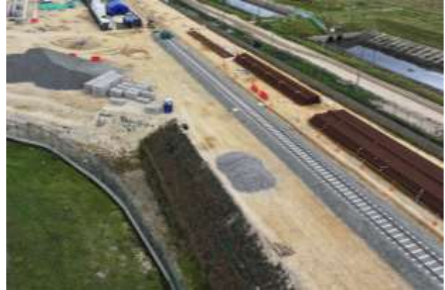
Ilustración a.2.1-22. Montaje de rieles para vía de prueba y área de almacenamiento en patio taller.
