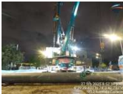
Ilustración a.2.9-18. Hincado de pilotes PHC UE204
