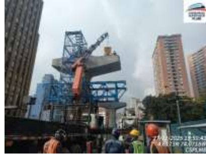
Ilustración a.2.8-4. Vaciado de padstones y stoppers viga capitel apoyo S14-10
