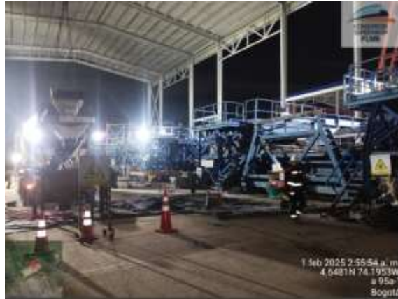
Figura k.ii.2-1-4. Avance Instalación Cubierta Planta de prefabricados de U-Beam.
