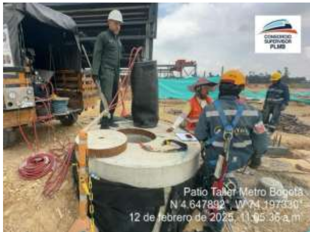
Ilustración a.2.1.-19. UE 38 Redes externas patio taller. Prueba red hidráulica y tubería TDP.
