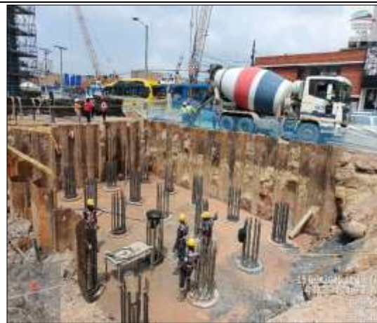
Apoyo E5-7 Se realiza instalación de concreto para 10 núcleos de pilotes PHC.
