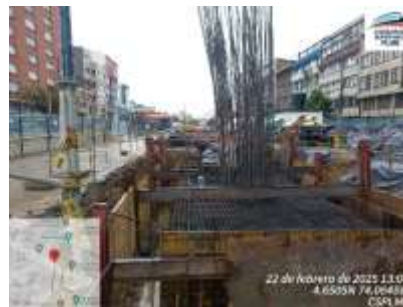
Ilustración a.2.9-14. Construcción de dado de cimentación apoyo S16-03
