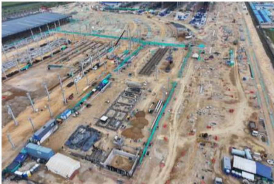
Ilustración a.2.1-21. UE 38 Redes externas patio taller costado occidental, construcción de cajas.
