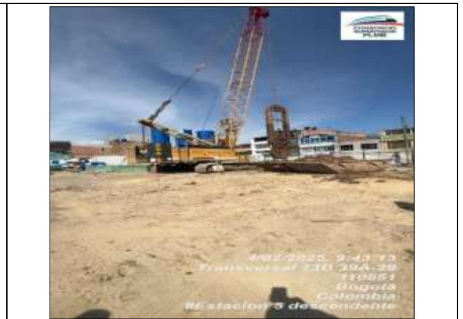
Se realiza excavación para barrete G19
