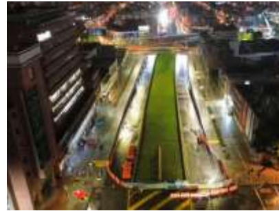
Ilustración a.2.2-4. Instalación de iluminación en deprimido.
