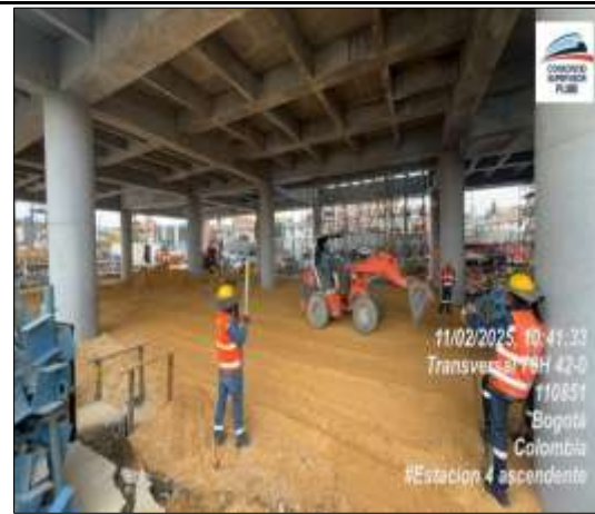
Se realiza actividad de llenos en Placa de acceso del Edificio 1
