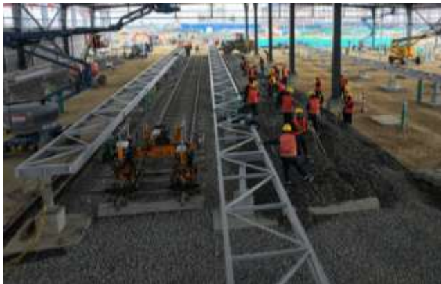
Ilustración a.2.1-23. Montaje de rieles hall de cocheras y acceso a taller de mantenimiento de infraestructura en patio taller.
