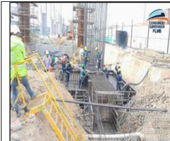
Instalación de concreto dado 8B Nave Central
