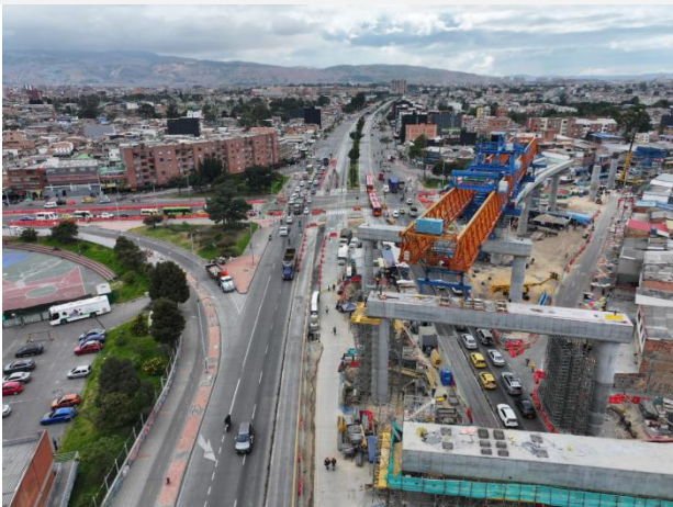
Viga Lanzadora 7 (S9-33)
