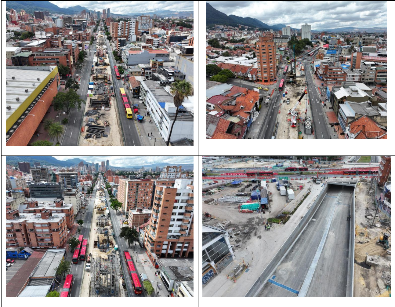
Figura 3.3-25. Avance físico de obra en Frente de Trabajo 6 (WF6), durante el mes de enero 2025
