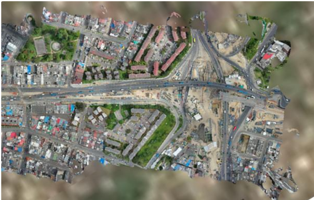
Figura 3.3-16. Avance físico de obra en Av. 68 con Av. 1ro de mayo durante el mes de enero de 2025 planta general
