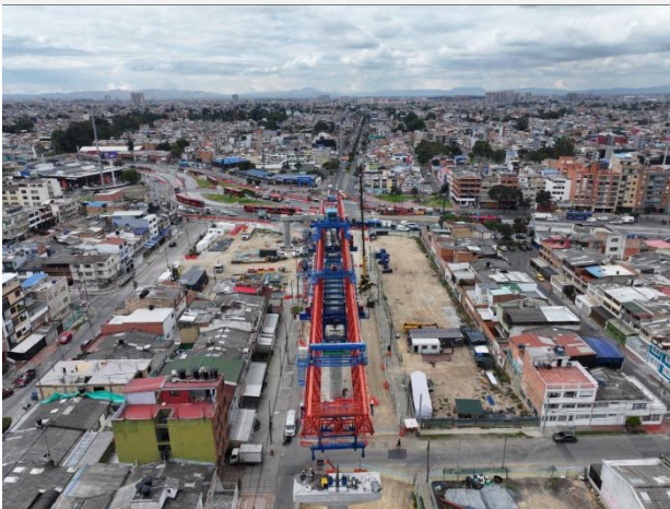
Viga Lanzadora 8 (S10-10)
