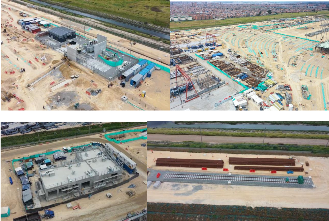
Figura 3.3-12. Avance físico de obra en Patio taller durante el mes de enero de 2025
