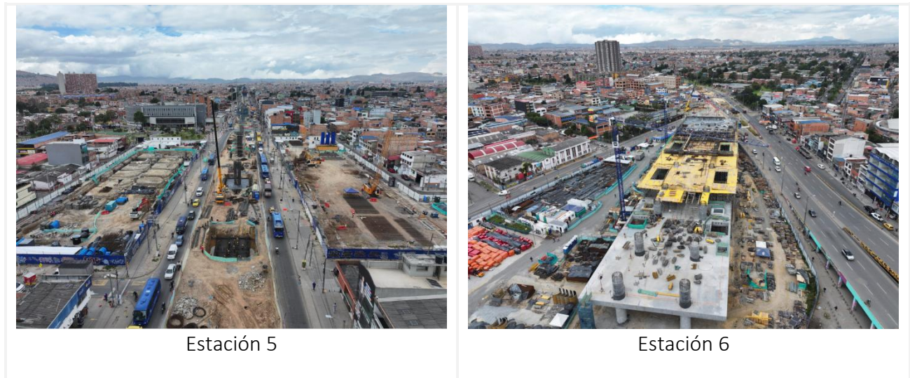
Figura 3.3-21 Avance físico de obra en Frente de Trabajo 2 (WF2), durante el mes de enero 2025
