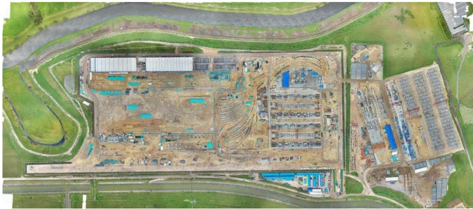
Figura 3.3-10. Avance físico de obra en Patio taller durante el mes de enero de 2025 planta general
