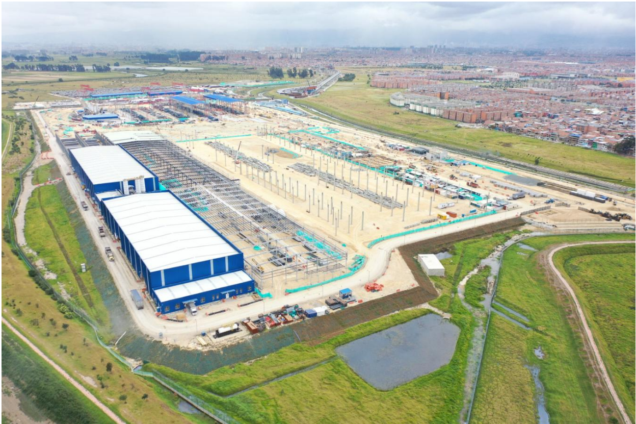
Figura 3.3-11. Avance físico de obra en Patio taller durante el mes de enero de 2025
