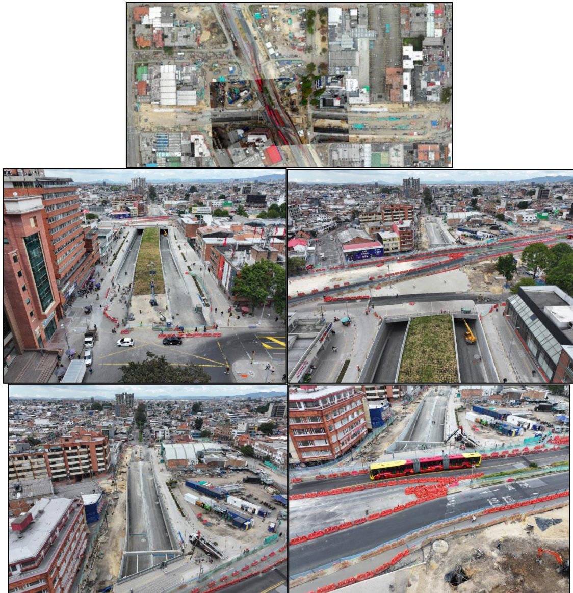
Figura 3.3-14. Intersección Avenida calle 72.
