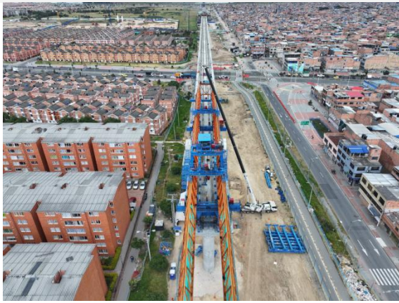
Viga Lanzadora 3 (S2-18)
