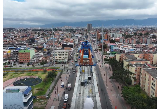
Viga Lanzadora 6 (S5-12)
