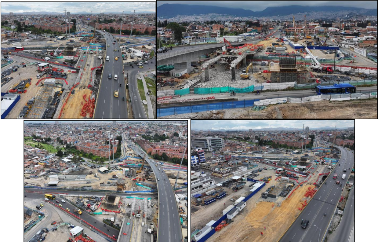
Figura 3.3-17. Registro Fotográfico Puente Norte AV. 68
