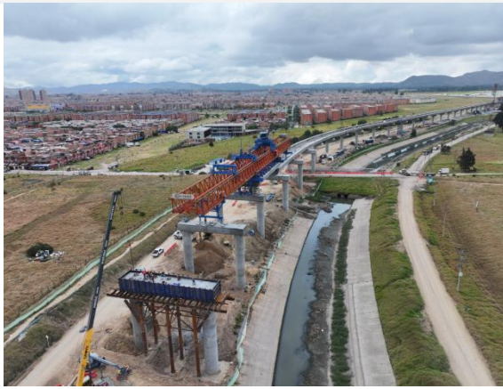
Viga Lanzadora 1 (S1-29)
