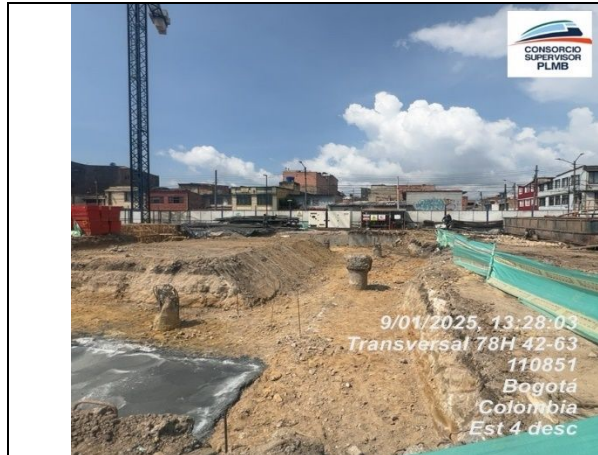
Se continua con excavación para placa andén
