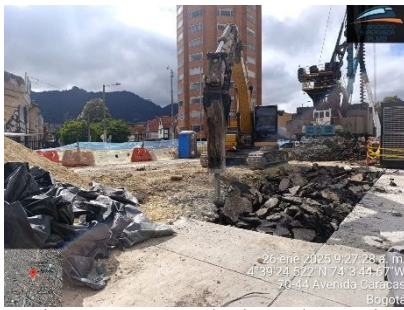
Ilustración a.2.9-16. Demolición y adecuación de plataforma para hincado de pilotes PHC
