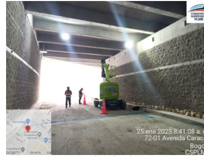
Ilustración a.2.2-4. Instalación de soportes y tubería de iluminación en deprimido.
