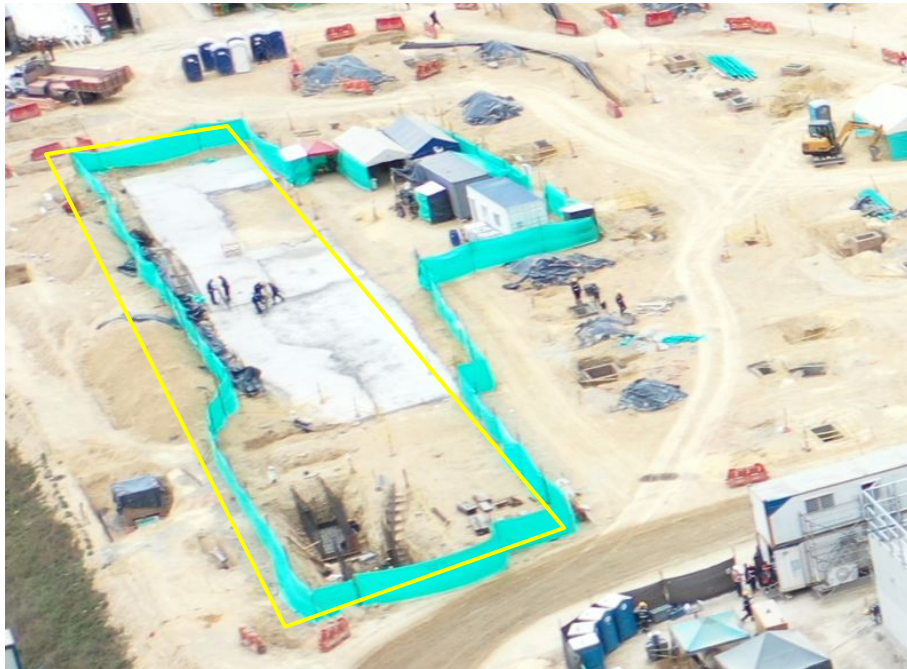
Ilustración a.2.1-6. UE 34 Edificio 106, Máquina de Lavado avance de obra al 31 de enero de 2025.
