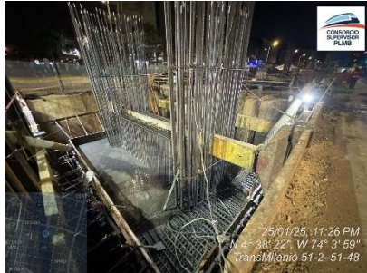
Ilustración a.2.9-3. Vaciado de dado apoyo S15-27
