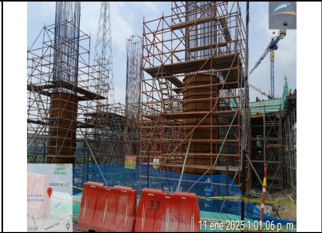
Columnas construidas correspondientes al eje 9 de sótano a intermedio
