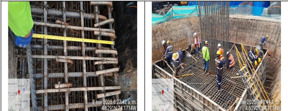
Apoyo S3-2 se realiza verificación de acero de refuerzo e instalación de concreto en dado de cimentación
