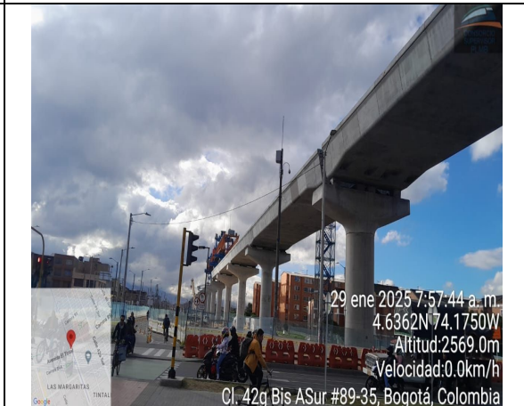
Avance de obra
