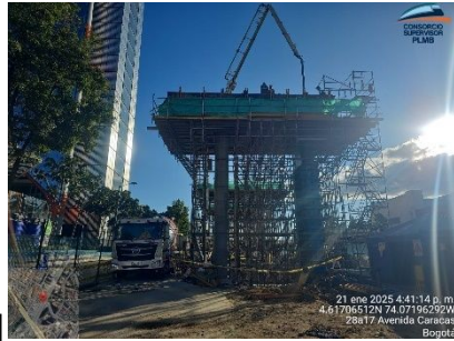
Ilustración a.2.8-1. Vaciado de viga capitel pórtico apoyo S14.08.
