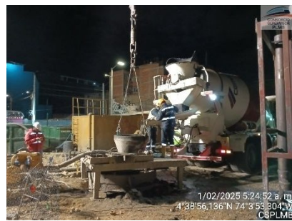
Ilustración a.2.9-10. Fabricación de pilotes preexcavados UE202
