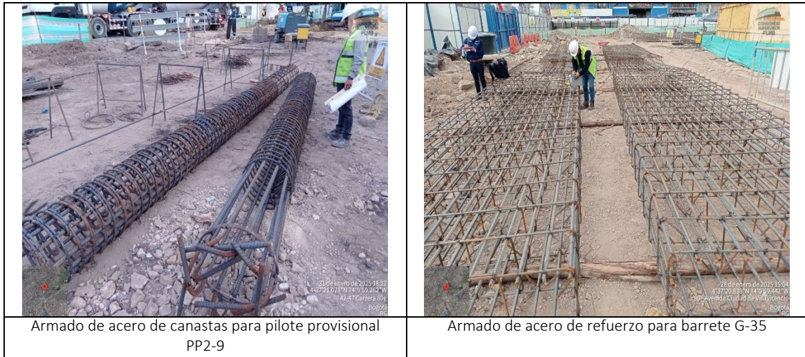
Ilustración a.2.5-34. Actividades de construcción de barretes desarrolladas durante el periodo UE307.
