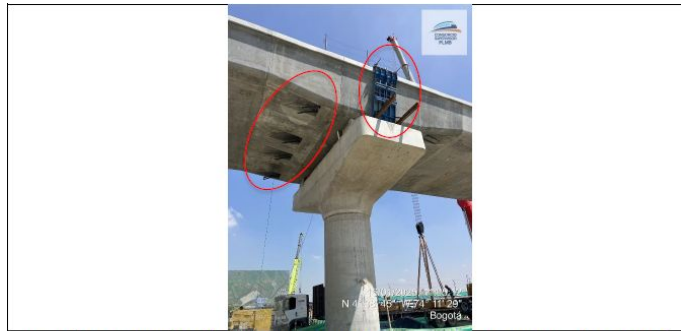
Formaleta y sistema de cables para tensionamiento de los vanos S01-06 y S01-07 (tipo W2- G). UE156
