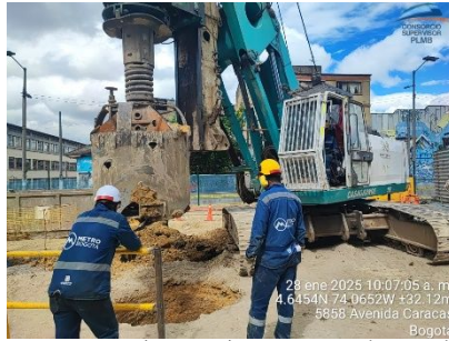
Ilustración a.2.9-8. Fabricación de pilotes preexcavados UE042
