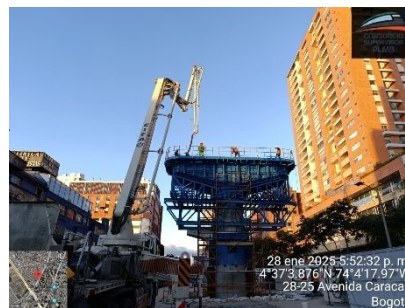
Ilustración a.2.8-7. Vaciado de viga capitel Apoyo S14-12.
