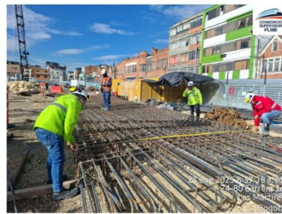
Excavación Armado y de parrillas de pantallas pre-excavados
