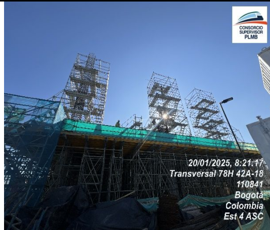
Se realiza Armado de acero Columnas placa intermedia
