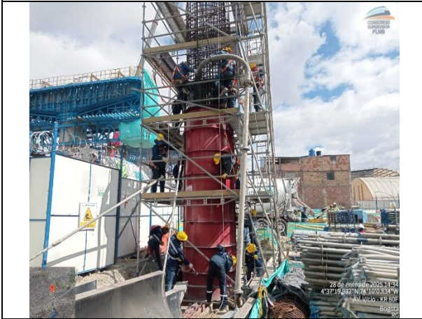
Instalación de concreto Columna F-1
