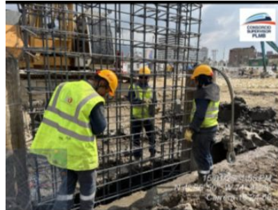
Izaje y posicionamiento de parrillas de pantallas pre-excavados
