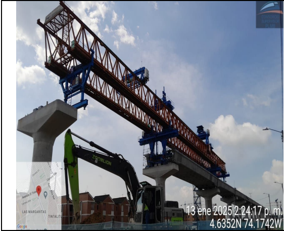
Movilización de viga lanzadora al vano S02-16
