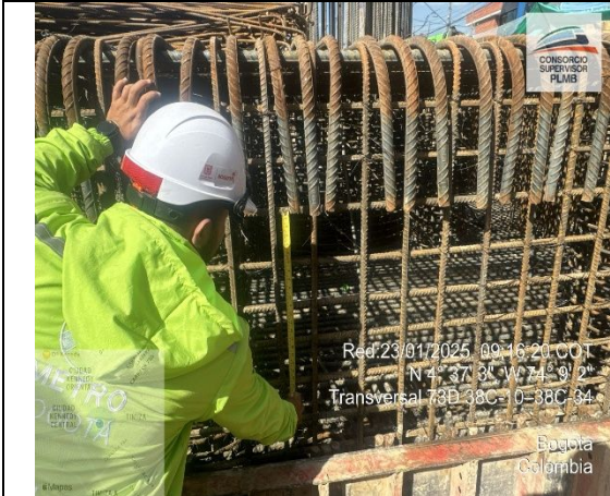
Verificación de cuantía y configuración de acero de refuerzo en torsión del dado de cimentación en los apoyos S6-1 y S6-3
