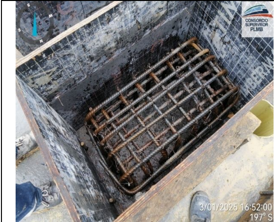
Apoyo S2-21 se realiza la verificación de aceros padstone y stopper
