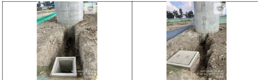
Estado actual de construcción del drenaje del viaducto entre los apoyos el S1-6 al S1-15 al 16 de enero de 2025.
