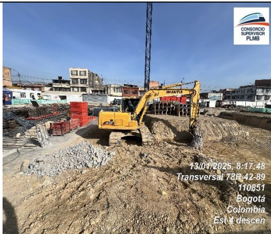
Se realiza excavación y limpieza para placa andén
