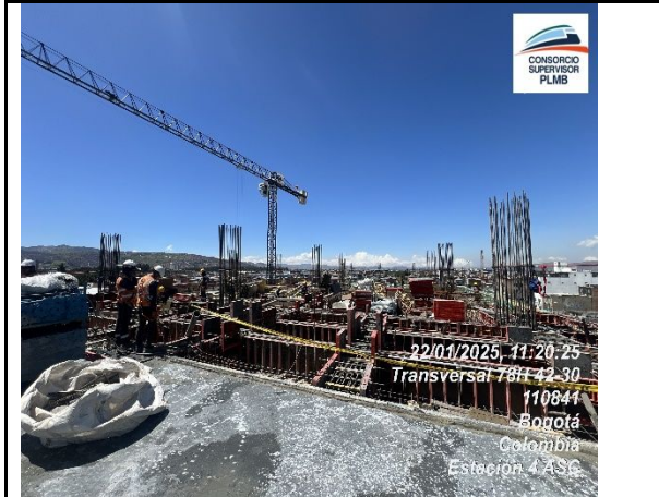
Se hace instalación de concreto vigas nivel bajo plataforma ejes 1-3 I-J
