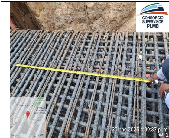
Verificación de armado de acero e instalación de concreto en el dado de cimentación del apoyo S4-6
