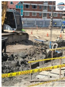
Excavación Armado y de parrillas de pantallas pre-excavados
