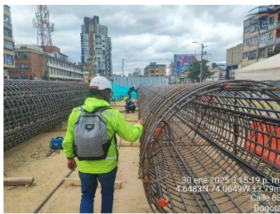
Ilustración a.2.9-10. Fabricación de pilotes preexcavados UE202
