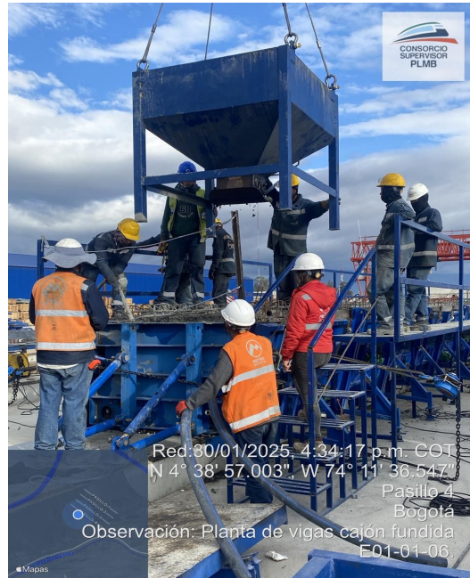
Ilustración k.ii.1.1-3. Producción Vigas Cajón.
