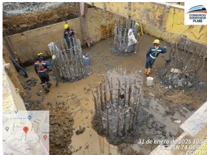
Ilustración a.2.9-5. Descabece de pilotes apoyo S15-20
