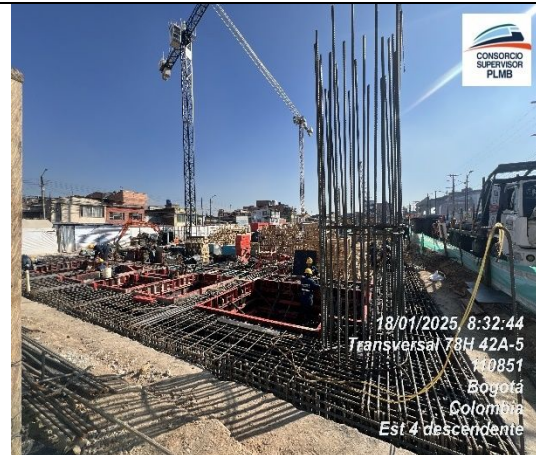
Se hace armado de acero placa andén
