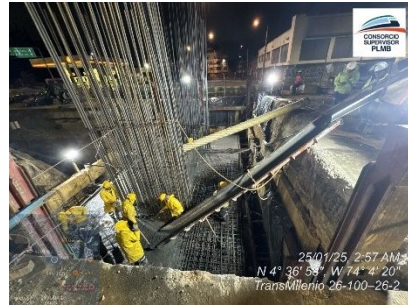
Ilustración a.2.8-2. Vaciado de dado apoyo S14.05.
