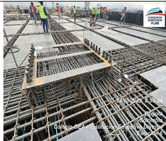
Se realiza instalación de concreto placa (Nivel 15,85) Ejes 1-2 A-E
