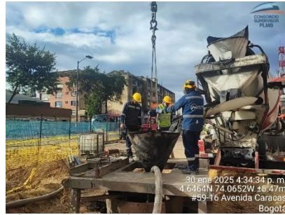
Ilustración a.2.9-8. Fabricación de pilotes preexcavados UE042
