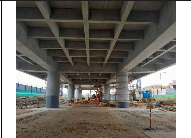
Intervenciones en acabados en placa de nivel intermedio Eje 1 - 2
