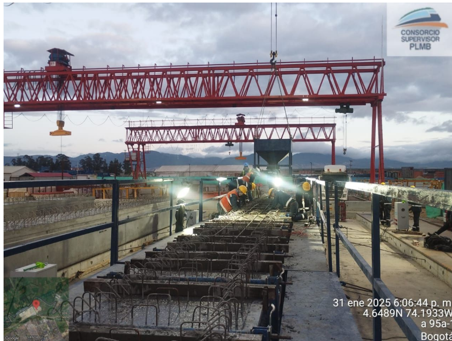
Ilustración k.ii.1.1-4. Producción Vigas Cajón.
