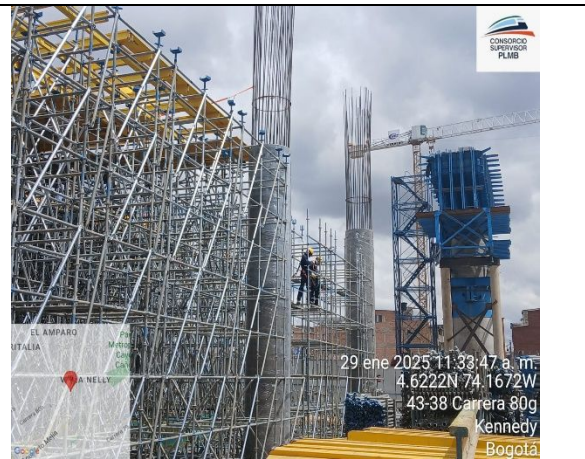
Instalación de obra falsa para placa nivel intermedio
