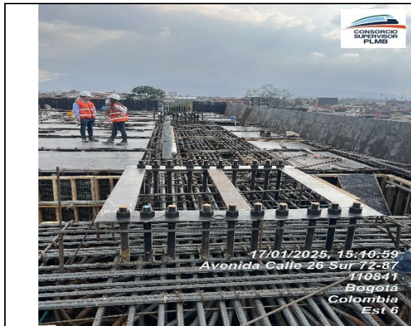
Se desarrolla actividad de Armado y posicionamiento de pernos en eje A (Nivel 15,85)
