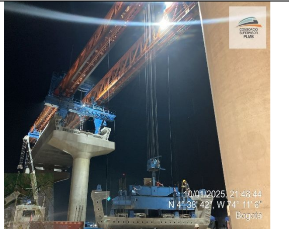
Se realiza izaje de dovelas en los vanos S01-24, S01-25 y S01-26
