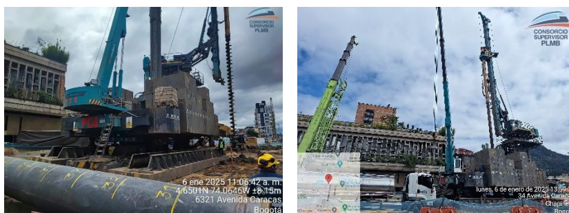
Ilustración a.2.9-12. Hincado de pilotes PHC UE41
