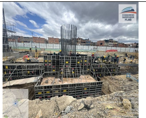
Amarre de acero de refuerzo para vigas y dados de cimentación Nave Central
