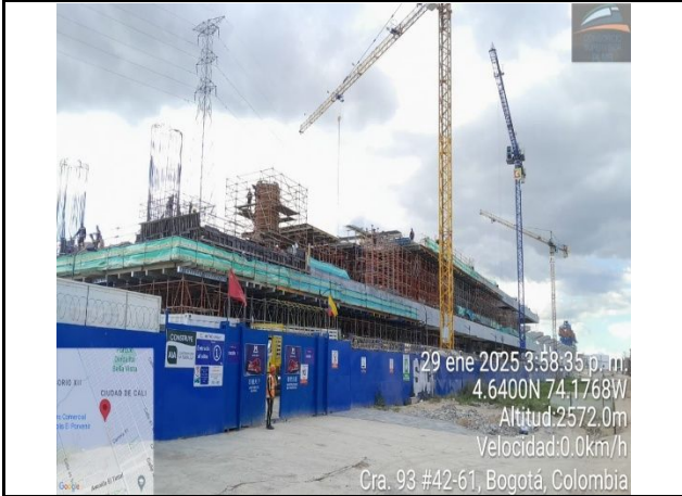
Avance de la estación general
