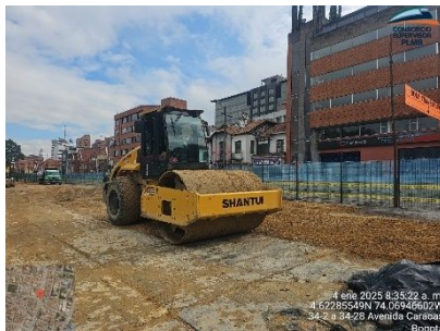
Ilustración a.2.8-11 Adecuación de plataforma para cimentación UE199.
