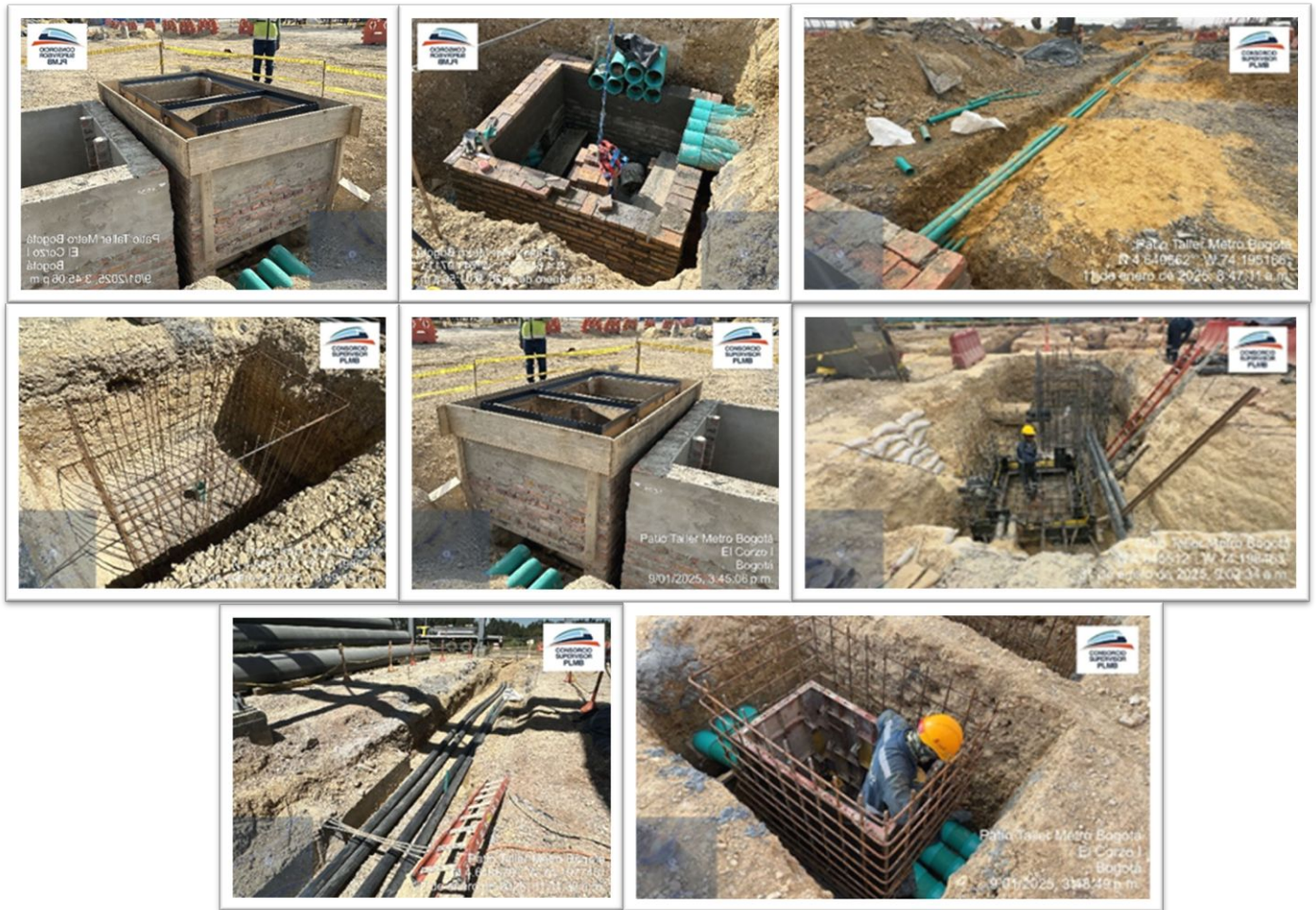
Ilustración k.ii.5.5-3. Avance de construcción de las canalizaciones en explanada de SMF en PT
