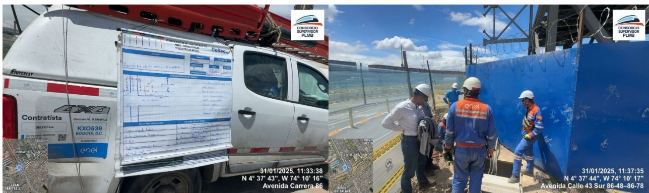
Ilustración a.2.4-5. Registro fotográfico de las actividades adelantadas de la red eléctrica en pila S03-04 Fuente: Recorrido de interventoría – elaboración propia, registro fotográfico incluido en anexo a.2.4, numeral a.2.4-3 Registro fotográfico actividades realizadas para el traslado de redes
