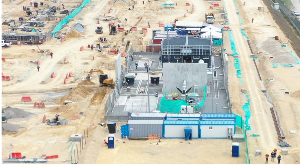
Ilustración a.2.1-15. Avance general SER1 vista costado sur.
