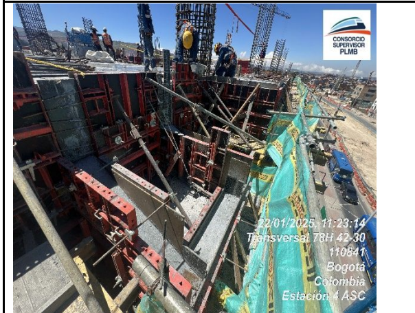
Se hace armado e instalación de concreto ménsula en ejes J-I Nivel bajo plataforma
