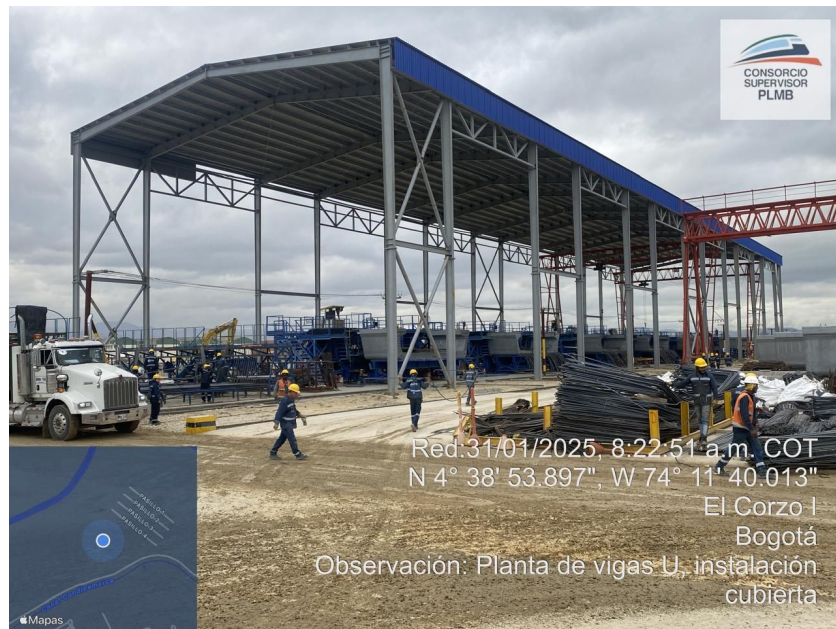
Figura k.ii.2-1-5. Avance Instalación Cubierta Planta de prefabricados de U-Beam.
