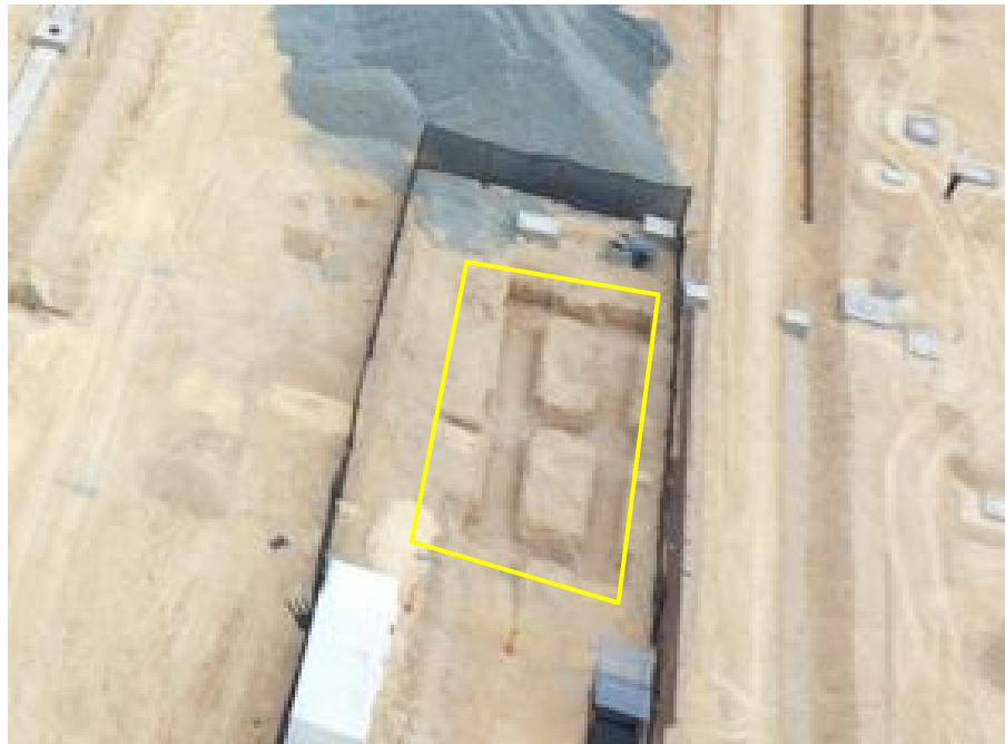
Ilustración a.2.1-13. UE 381 Edificio 900, Zona de Pruebas de PDAP avance de obra al 31 de enero de 2025.
