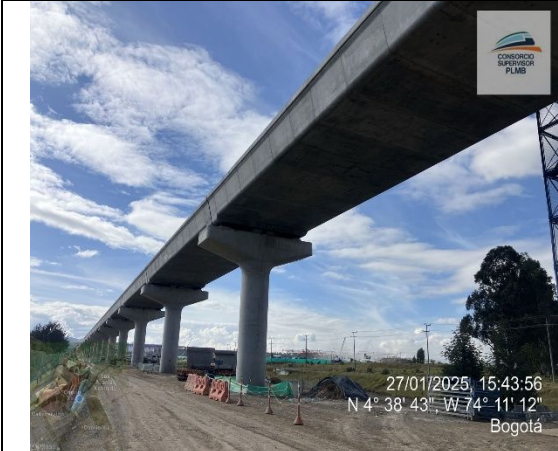
Se realiza actividades de nivelación y posicionamiento de los vanos S01-24, S01-25 y S01-26
