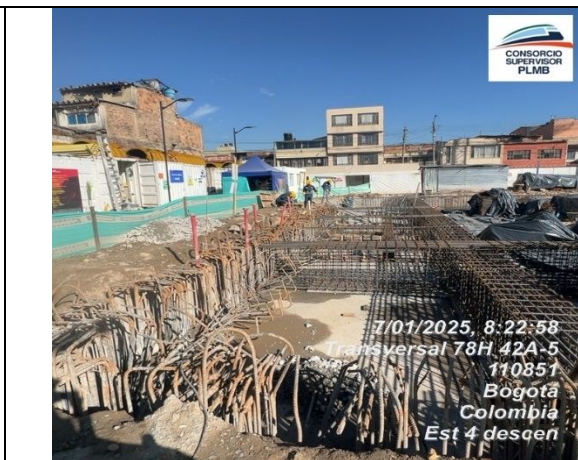
Se realiza armado de acero placa andén C1
