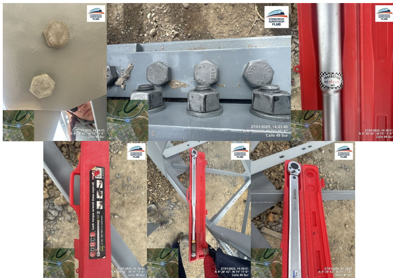
Ilustración a.2.4-7. Registro fotográfico verificación procedimiento torque
