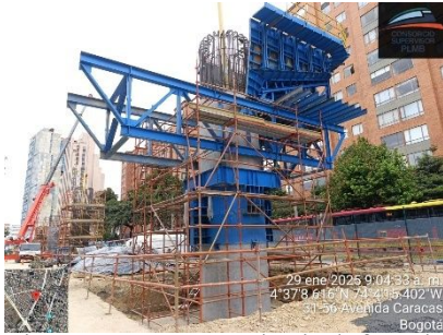
Ilustración a.2.8-8. Izaje e instalación de formaleta para viga capitel S14-16
