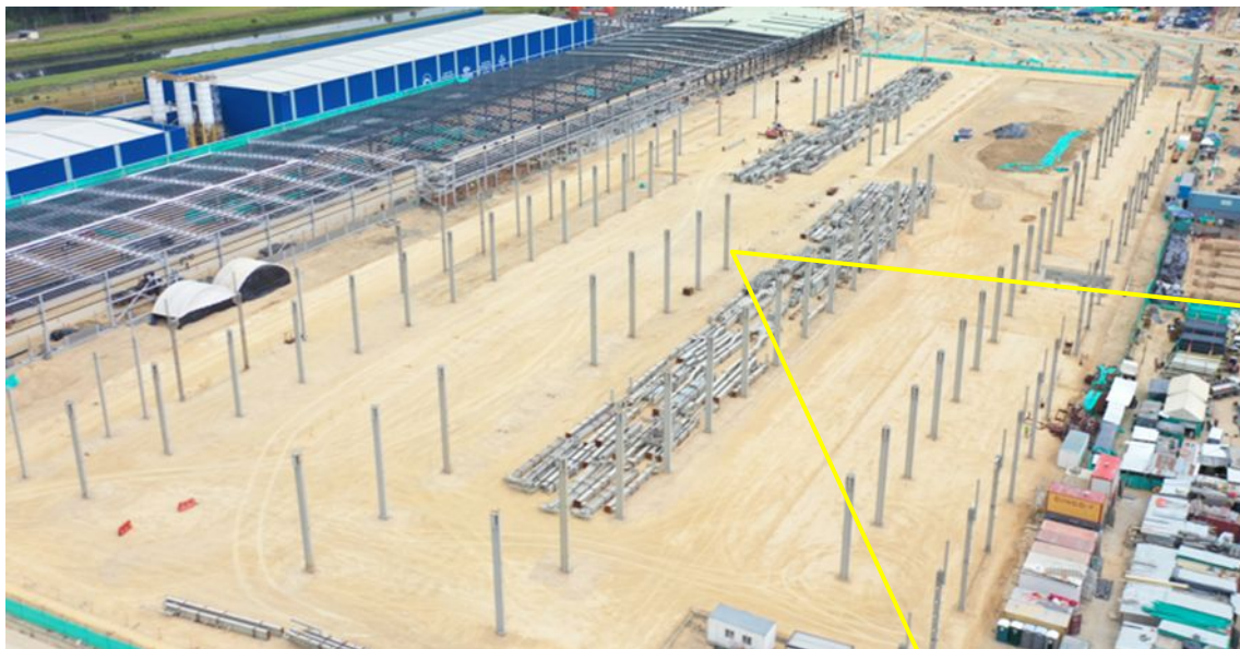
Ilustración a.2.1-8. Avance general de actividades UE 36 Edificio 105, locales técnicos.
