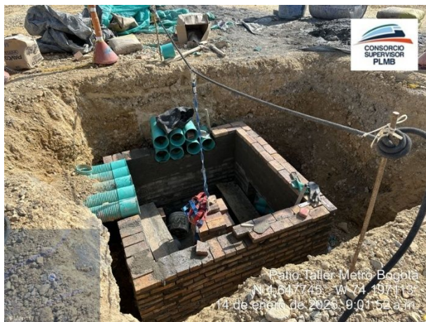
Ilustración a.2.1.-19. UE 38 Redes externas patio taller. Red alcantarillado pluvial y eléctrica.
