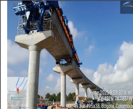
Se realiza actividades de nivelación y posicionamiento de los vanos S01-24, S01-25 y S01-26
