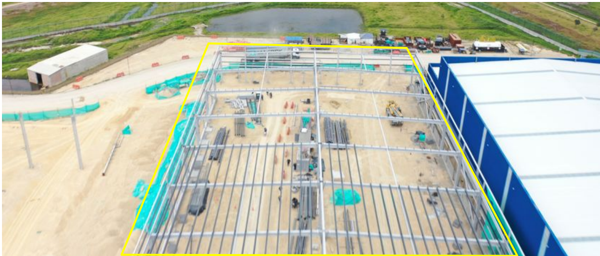
Ilustración a.2.1-5. Actividades UE 32 Hall de cocheras Edificio 104, módulo 3.
