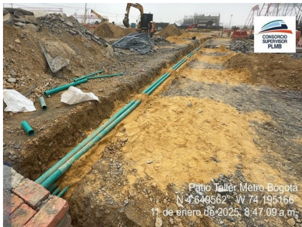
Ilustración a.2.1.-20. UE 38 Redes externas patio taller. Red hidráulica con protección.
