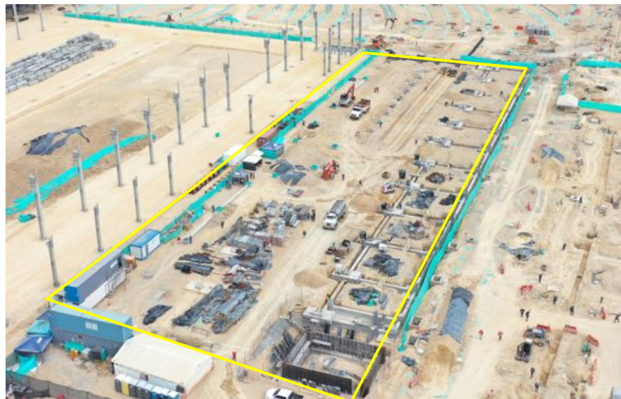
Ilustración a.2.1-7. Avance general de actividades UE 35 Edificio 107, Mantenimiento de infraestructura.
