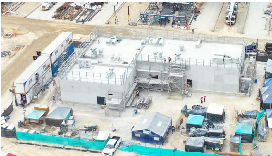
Ilustración a.2.1-18. UE 408 SET. Avance general vista costado norte.
