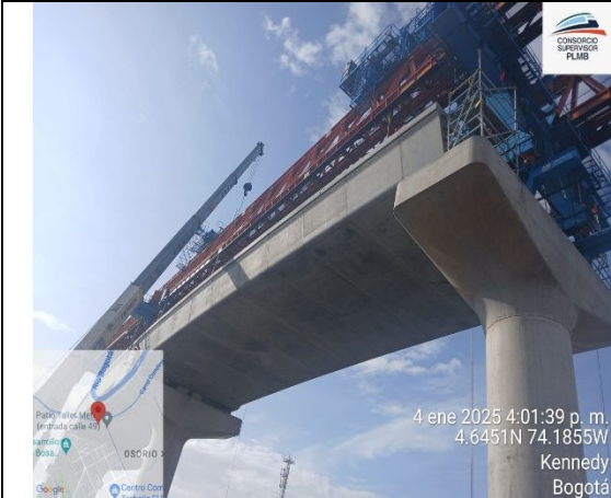
Se realiza alineación, aplicación de epoxico, unión y pretensado de dovelas en vanos S01-24, S01-25 y S01-26
