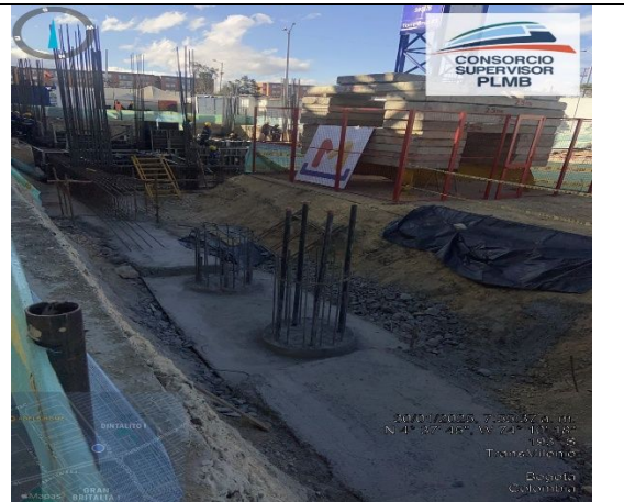
Pilotes y concreto de limpieza para cimentación Ascendente 2
