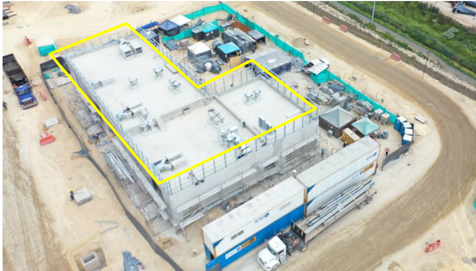
Ilustración a.2.1-17. UE 408 SET. Avance general vista costado nororiental.
