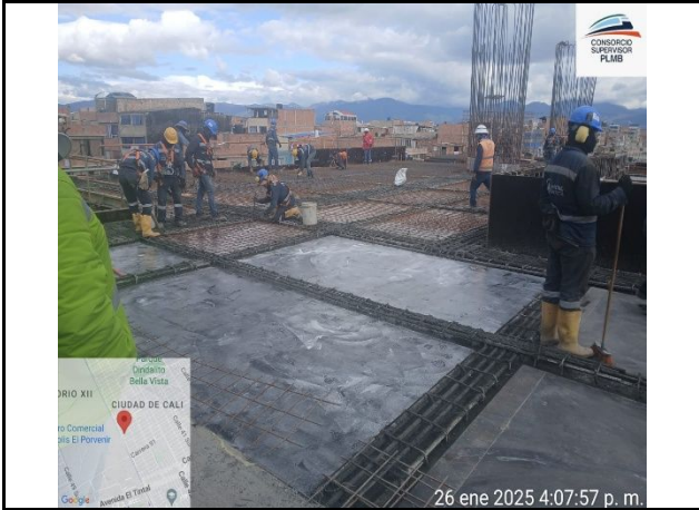
Instalación de concreto en placa de nivel intermedio eje 7 a 8
