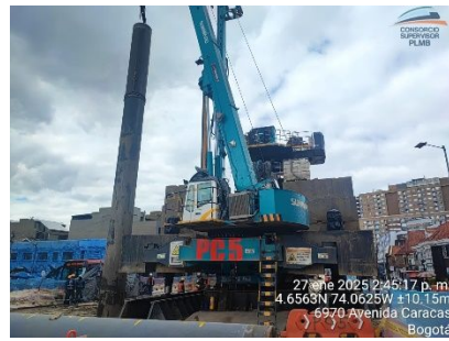
Ilustración a.2.9-17. Hincado de pilotes PHC UE204
