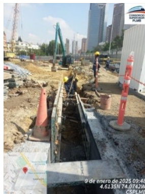
Ilustración a.2.8-13. Fabricación de vigas guía Estación 13 descendente
