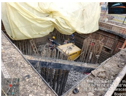
Ilustración a.2.8-6. Descabece de pilotes apoyo S14-20.
