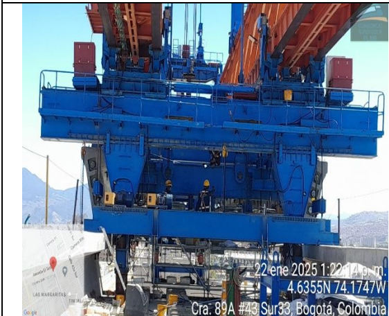
Se realiza corte de torones de los vanos desde el S02-15 al S02-18
