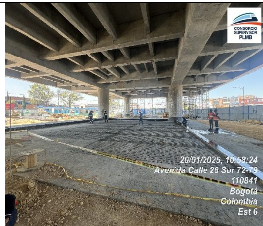
Se realiza armado de parrilla para placa de acceso ejes 2-3 B-D
