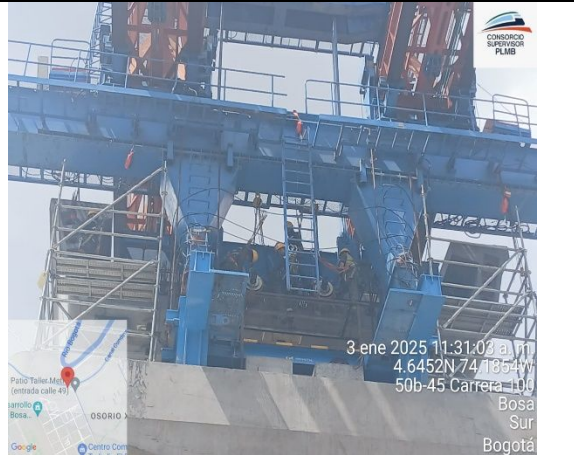
Se realiza instalación de torones, bloques y cuñas para proceso de tensionamiento en vanos S01-24, S01-25 y S01-26
