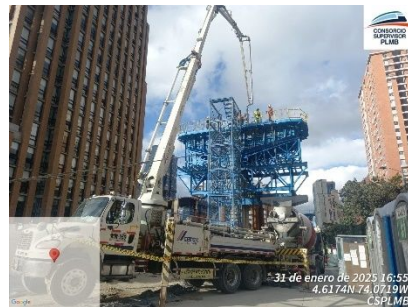
Ilustración a.2.8-4. Vaciado de viga capitel apoyo S14-10
