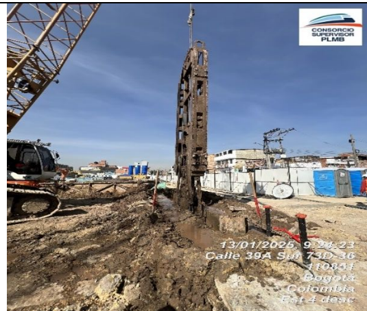
Se realiza excavación para barrete G27
