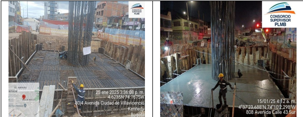
Armado de acero de refuerzo e instalación de concreto de los dados de los apoyos S3-26 y S3-27
