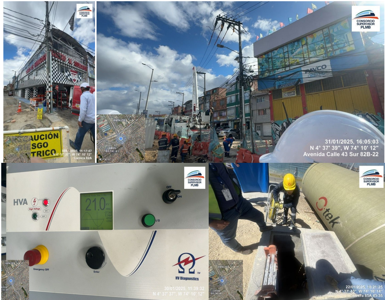
Ilustración a.2.5-2. Registro fotográfico de las actividades adelantadas de la red ENE2-18, ENE2-SM3 y ENE2-SM4. Fuente: Recorrido de interventoría – elaboración propia, registro fotográfico incluido en anexo a.2.5, numeral a.2.5-6 Registro fotográfico actividades realizadas para el traslado de redes.
