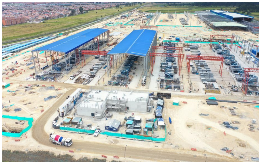
Ilustración a.2.1-24. Avance general patio taller vista desde costado sur.
