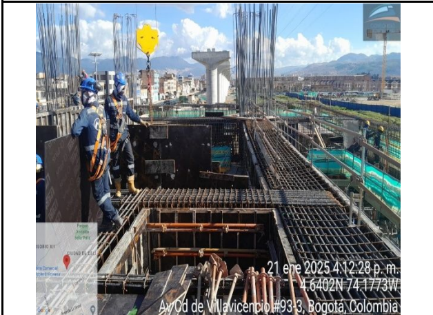
Amarre de acero de placa de nivel bajo plataforma y localización de pernos vigas cajón
