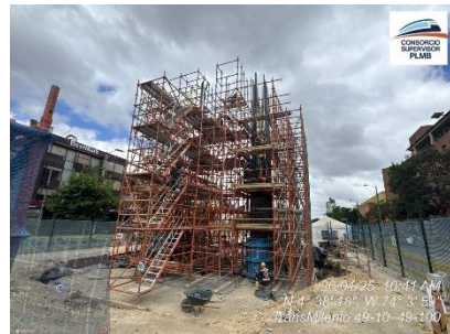
Ilustración a.2.9-6. Armado de columnas Apoyo S15-25
