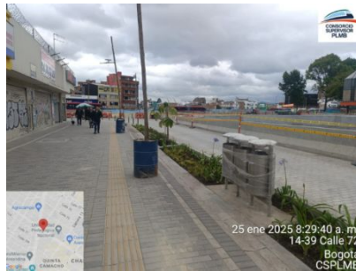
Ilustración a.2.2-5. Instalación de especies en zona verde.
