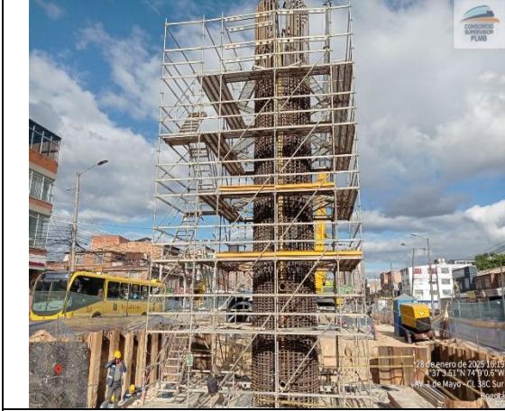
Verificación de cuantía y configuración de acero de refuerzo en torsión del apoyo S6-3 y S6-5
