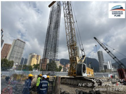
Izaje y posicionamiento de parrillas de pantallas pre-excavados
