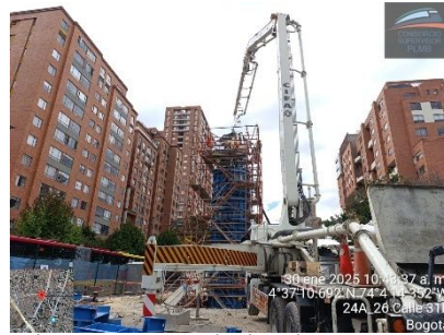
Ilustración a.2.8-9. Vaciado de columna Apoyo S14-18.
