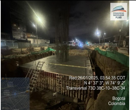
Instalación de concreto dado de cimentación en el apoyo S6-01 y el S6-03
