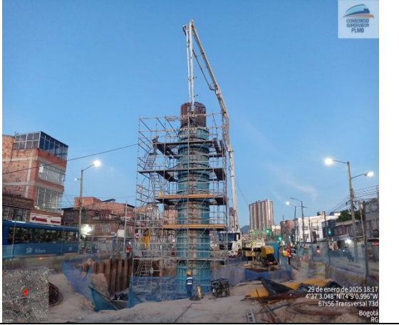
Instalación de concreto pila en el apoyo S6-3 y el S6-5
