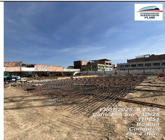
Se hace configuración de acero para pantalla
