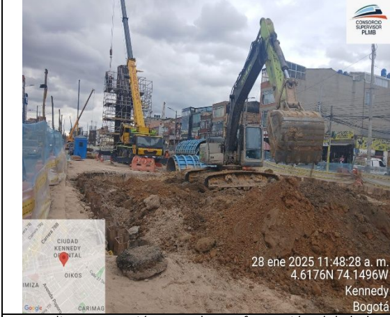
Se realiza excavación para la conformación del dado de cimentación en los apoyos S6-4 y S6-2
