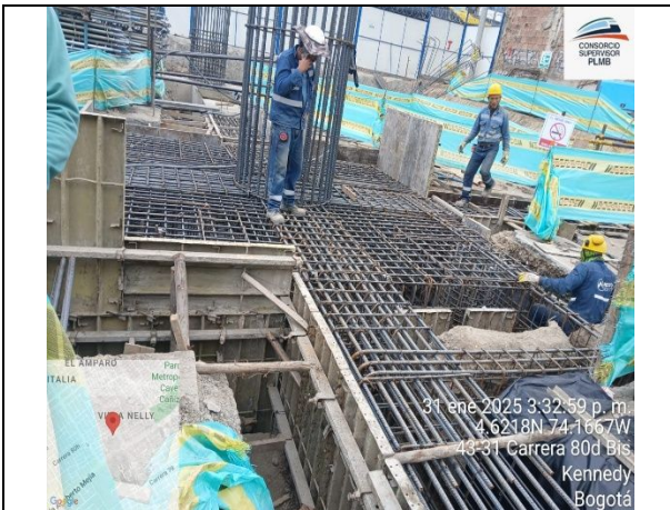
Acero de refuerzo en vigas 1002 y 1012 a eje I y Dado I2
