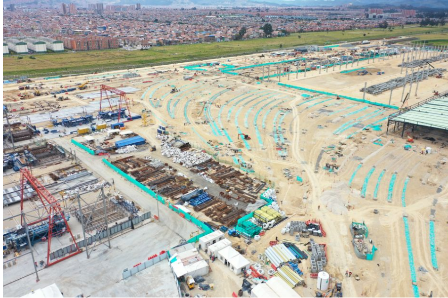
Ilustración a.2.1-21. UE 38 Redes externas patio taller. Construcción de filtros en haz de vías y de cajas de inspección para red pluvial.
