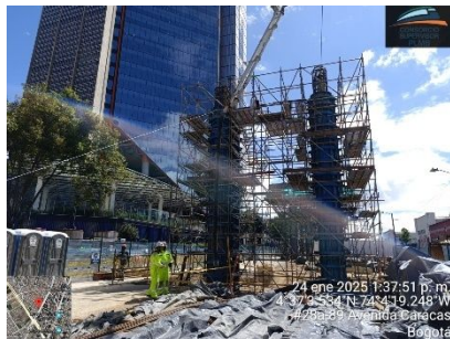
Ilustración a.2.8-3. Vaciado de columnas apoyo S14-09.
