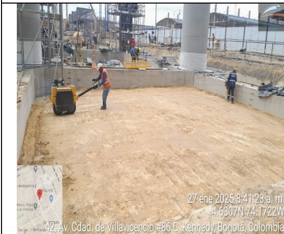
Llenos en material granular entre vigas de Nave Central
