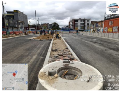
Ilustración a.2.2-3. Instalación de bordillo, e instalación de asfalto sector occidental.
