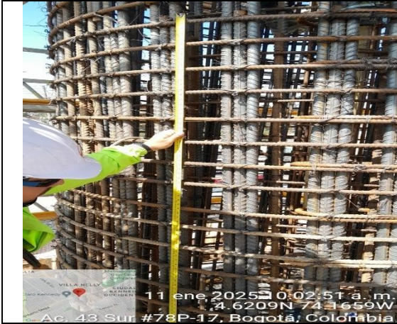
Verificación de armado de acero e instalación de concreto en las pilas de los apoyos S4-3 y S4-4
