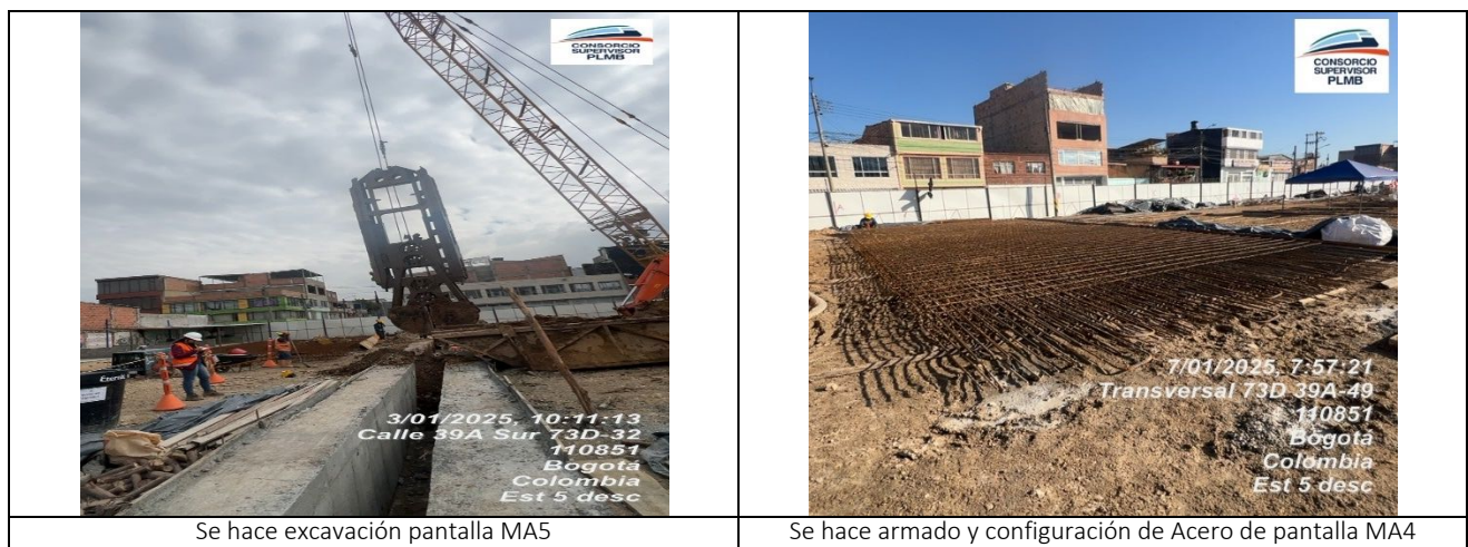
Ilustración a.2.5-48. Actividades desarrolladas durante el periodo correspondientes a pantallas y vigas guía UE315
