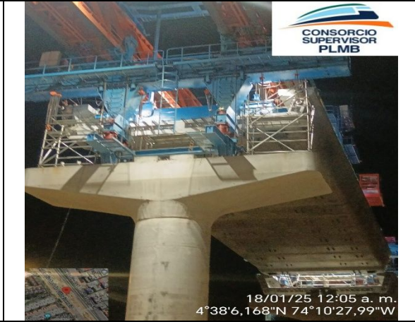
Se realiza tensionamiento de los vanos desde el S02-15 al S02-18
