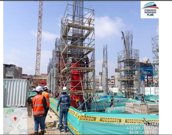
Instalación de formaleta columna G-3
