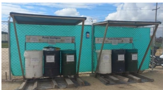
Figura 12 Punto ecológico TIPO para residuos sólidos convencionales en frentes de obra para de la PLMB
