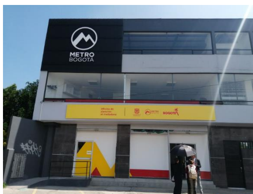
Figura 141 Fachada oficina de atención al ciudadano av. Primero de Mayo con av. 68 con marca Metro de Bogotá.
