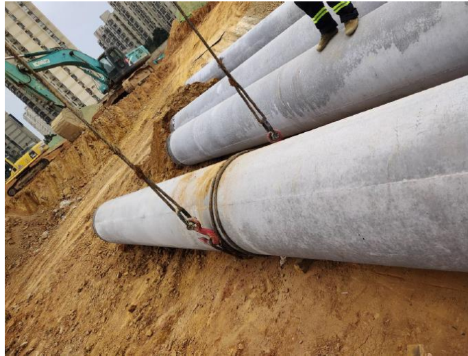
Fotografía 9 Abrazadera para Izaje de pilotes
