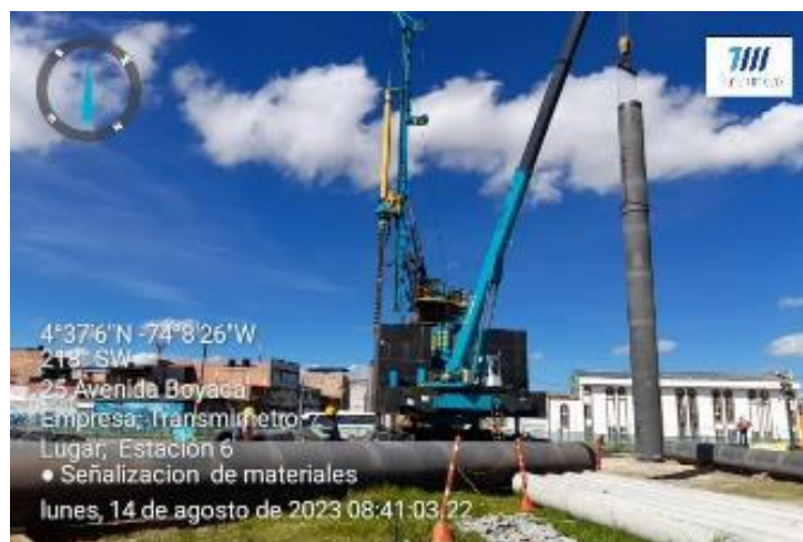
Fotografía 12 Hincado de pilote
