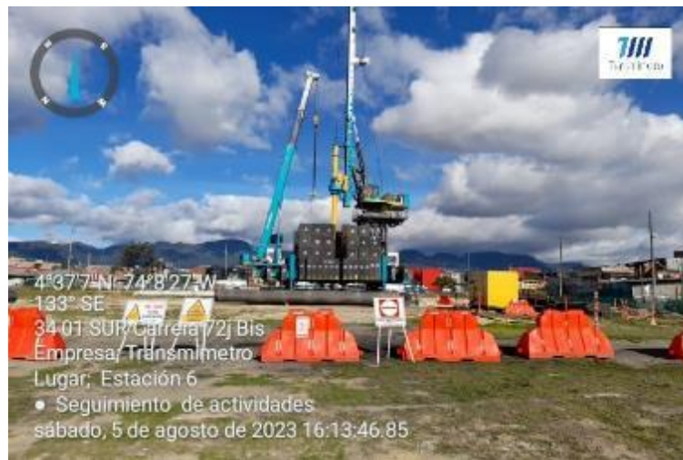
Fotografía 11 Piloteadora para el incado de pilotes
