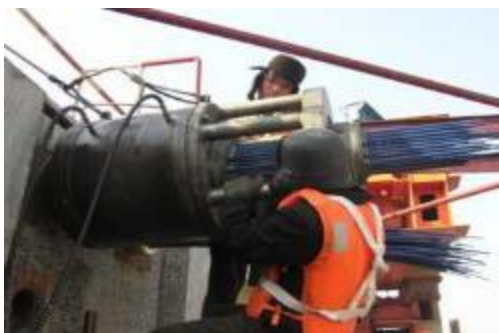
Fotografía 29 Tensado Viga U (fotos de referencia)
