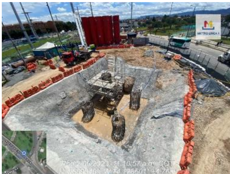
Fotografía 18 Construcción de Dados. Alternativa 2
