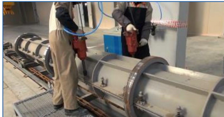
Fotografía 47 Armado del molde o formaleta
