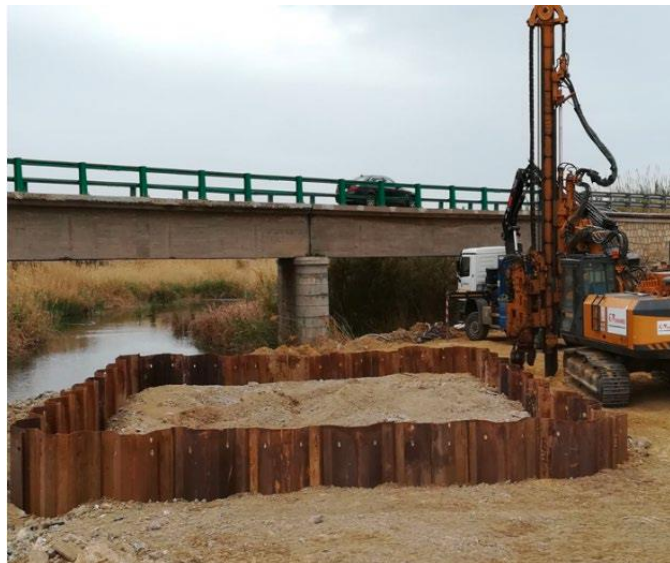
Fotografía 16 Construcción de Dados. Alternativa 1
