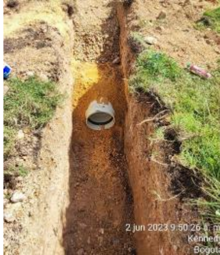
Fotografía 5 Material de Relleno
