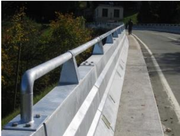
Fotografía 74 Instalación de barreras de protección
