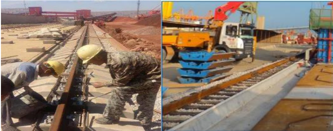
Figura 315 Construcción de cimentación de grúa pórtico
