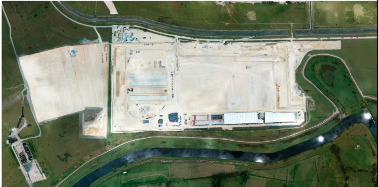
Vista aérea Patio Taller (sep-2023)
