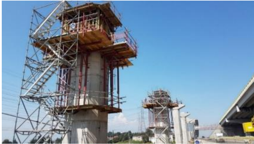
Fotografía 23 Construcción de pilas y vigas capitel
