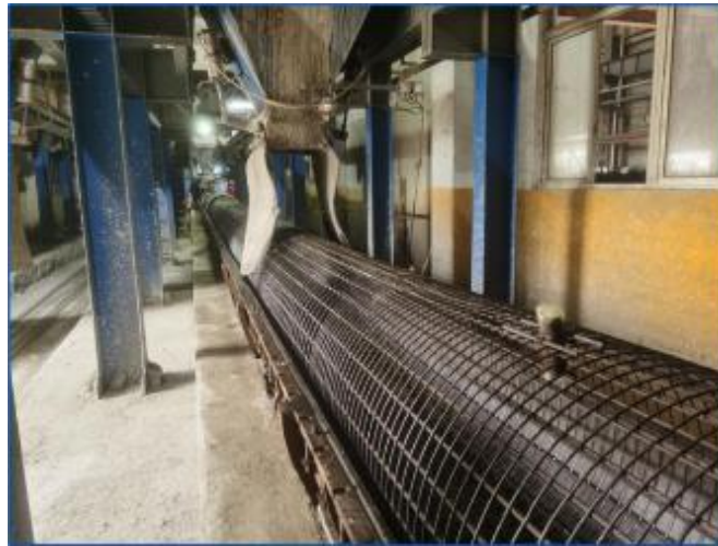
Fotografía 46 Vaciado de concreto
