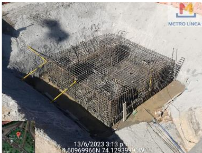
Fotografía 19 Armado de hierro para la construcción de Dados Alternativa 2
