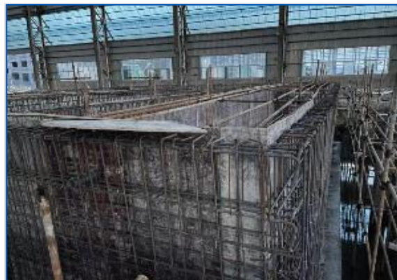
Fotografía 35 Construcción Cámaras de curado
