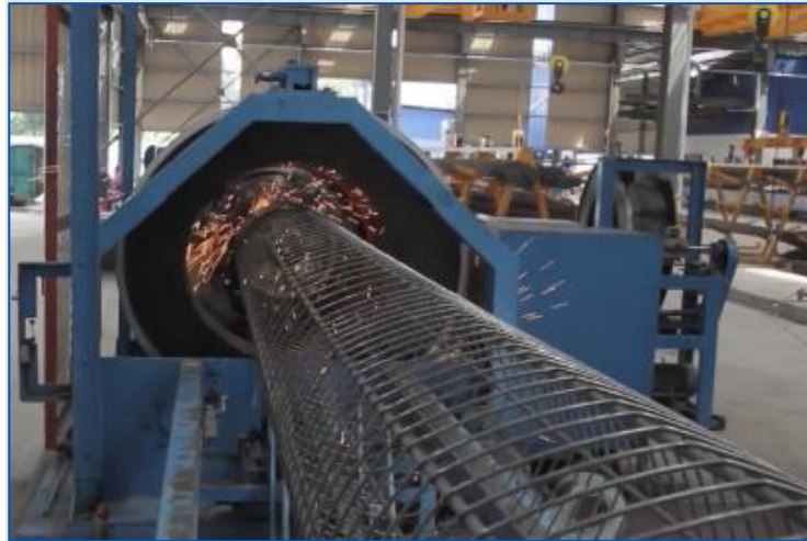
Fotografía 44 Soldadura del refuerzo espiral para la canasta
