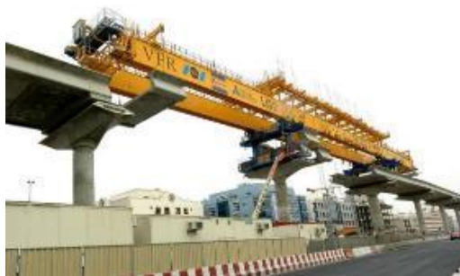
Fotografía 27 Ensamble Vigas U (fotos de referencia)
