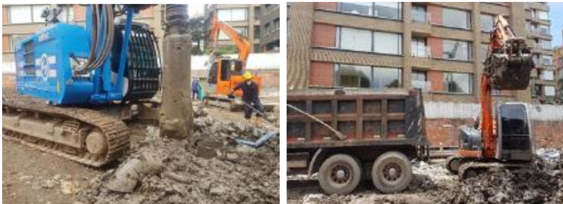
Fotografía 64 Cimentación (fotos de referencia)
