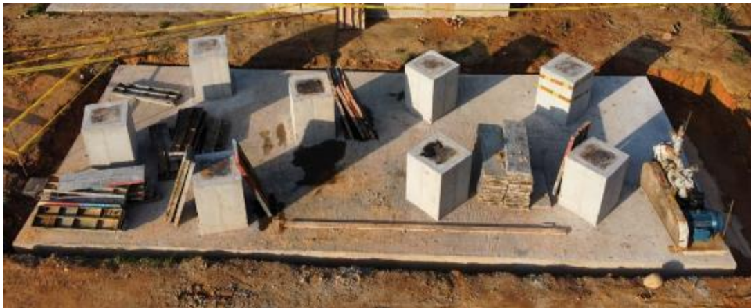
Fotografía 56 Construcción placas y pedestales de silos
