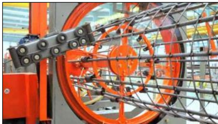
Fotografía 38 Equipo principal de canasta de refuerzo
