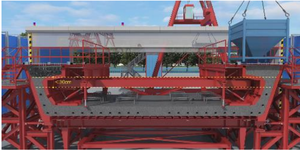
Figura 279 Capas horizontales de vertido de concreto
