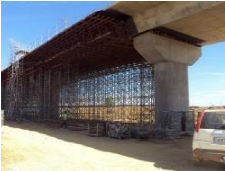
Fotografía 72 Construcción de dovelas de cierre y viga cajón cimbrada
