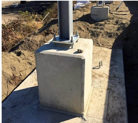
Figura 328. Imagen de referencia de estructura metálica armada sobre pedestales en concreto.
