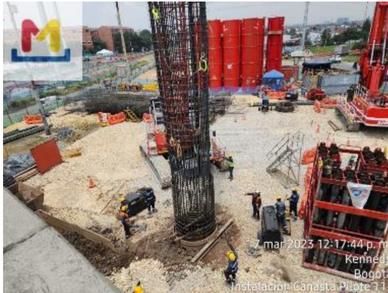
Fotografía 65 Instalación de Parrilla (fotos de referencia)
