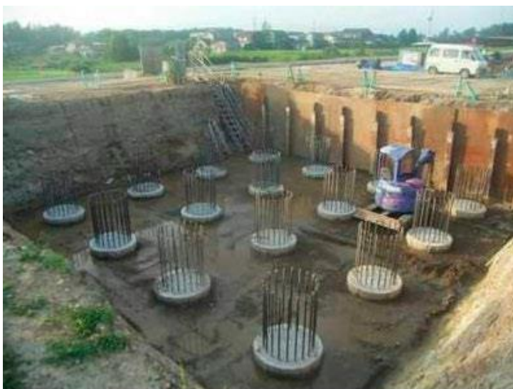
Fotografía 17 Inicio metodología de construcción de Dados Alternativa 2
