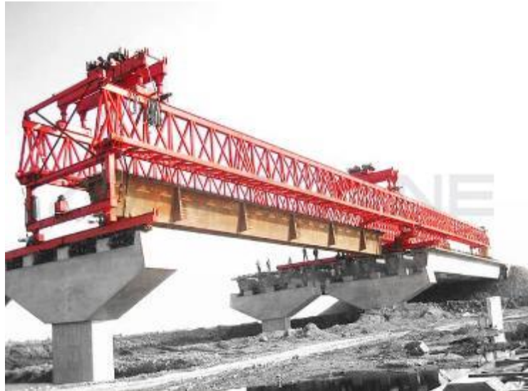
Fotografía 24 Instalación de vigas por medio de lanzador de vigas
