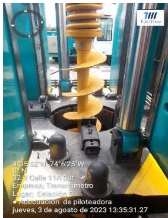
Fotografía 13 Sistema de barrenado para el centro del pilote
