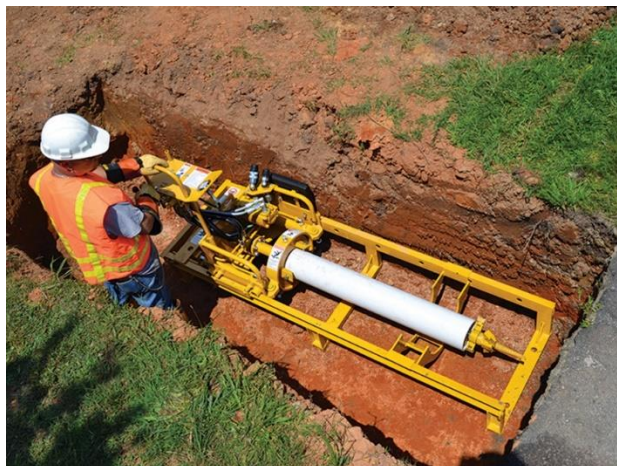
Fotografía 7 Sistema Auger Boring
