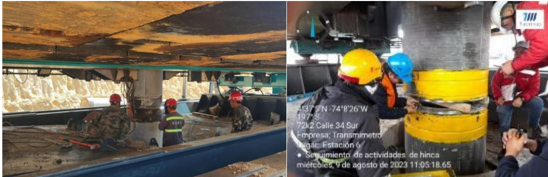
Fotografía 15 Soldadura en sitio entre Pilotes
