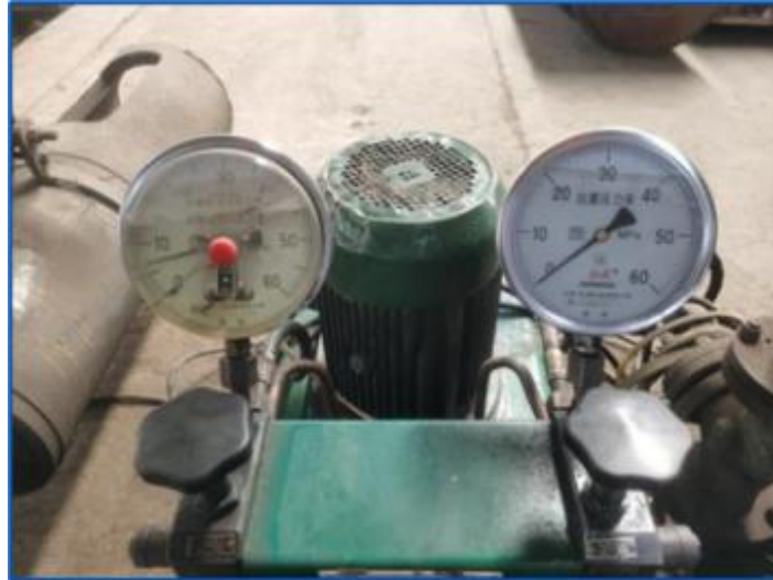
Fotografía 48 Proceso de tensionamiento
