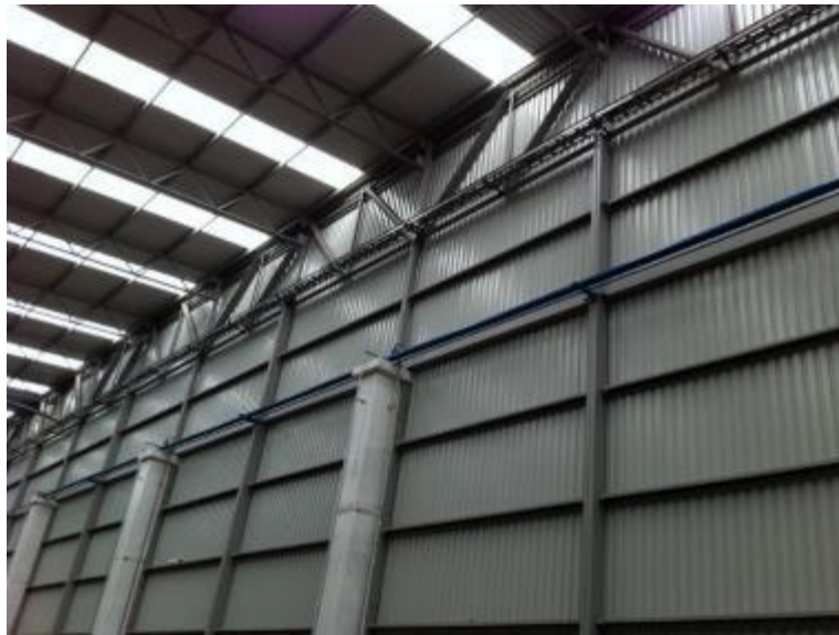
Fotografía 54 Instalación de muros
