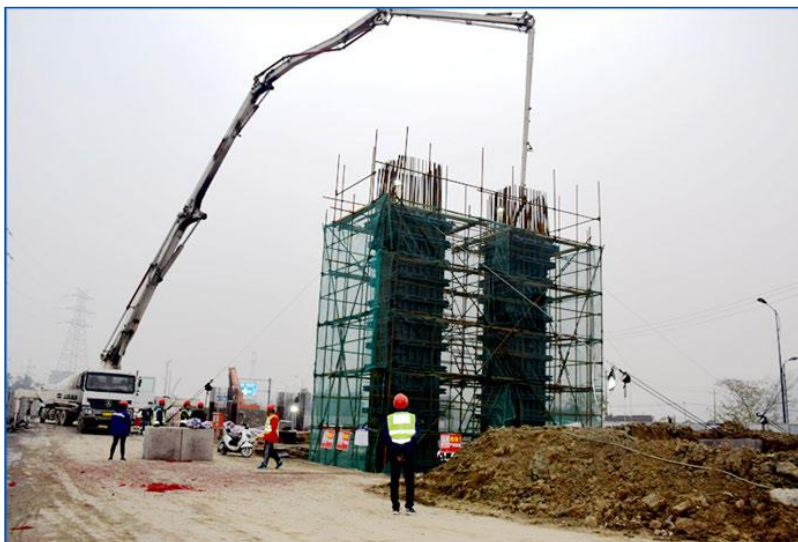
Fotografía 21 Fundida de concreto construcción de pila (fotos de referencia)
