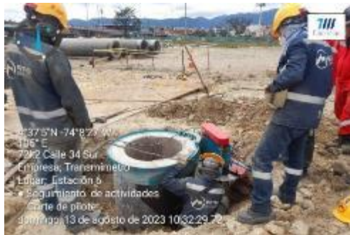
Fotografía 14 Descabece de Pilotes PHC
