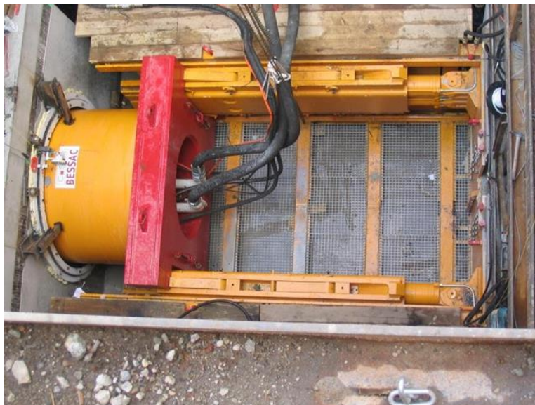
Figura 397 Esquema Estación de empuje
