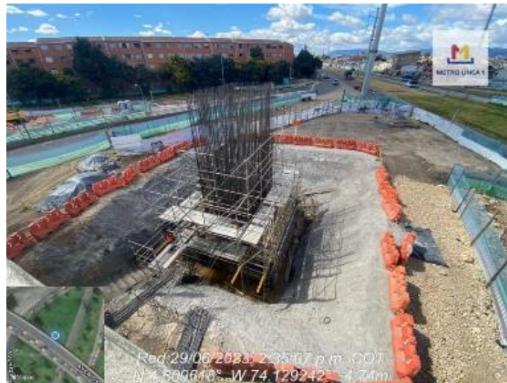
Fotografía 20 Armado de hierro construcción de pila (fotos de referencia)
