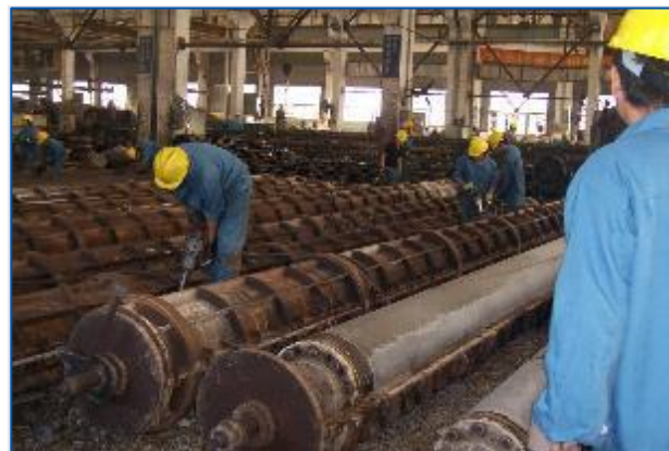
Fotografía 51 Proceso de liberación del pretensado y retiro de la formaleta
