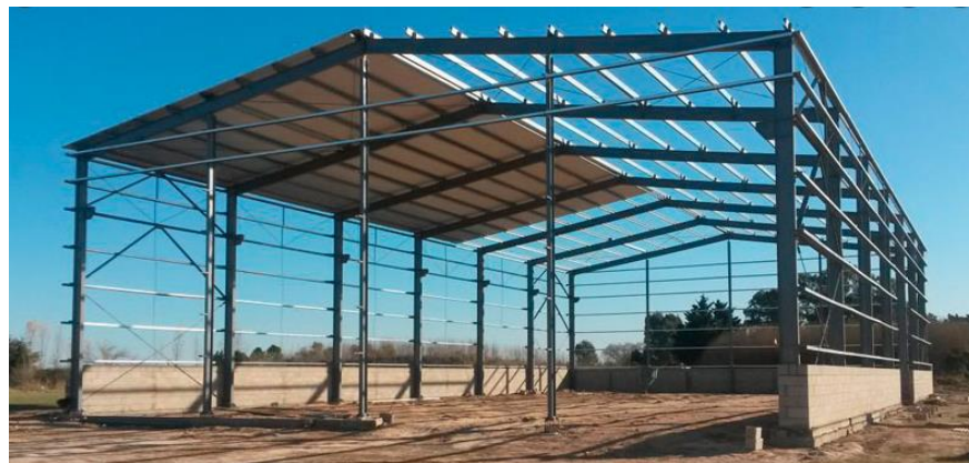
Figura 334 Instalacion de Cubierta metalica Standing Seam
