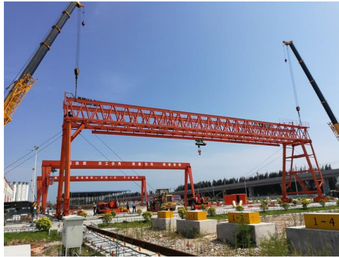
Fotografía 59 Instalación grúas pórtico
