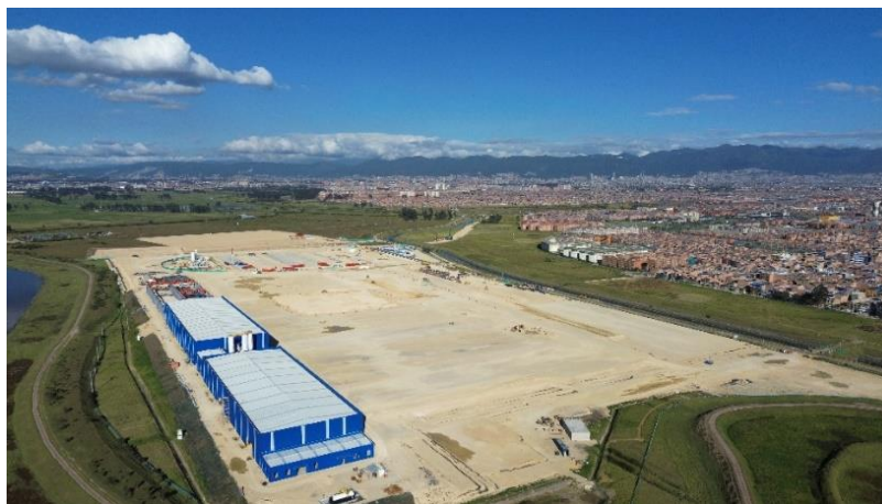
Fotografía 32. Estado actual del patio de prefabricados
