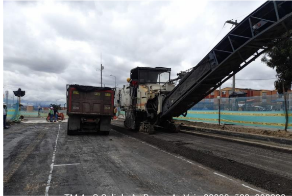
Fotografía 68 Fresado capa asfáltica
