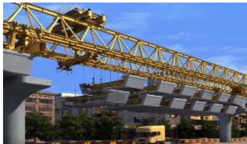
Fotografía 26 Elevación y suspensión vigas U (fotos de referencia)
