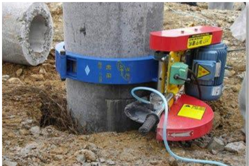
Fotografía 14 Descabece de Pilotes PHC
