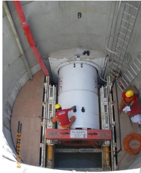
Figura 387 Montaje de la microtuneladora sobre el banco de empuje
