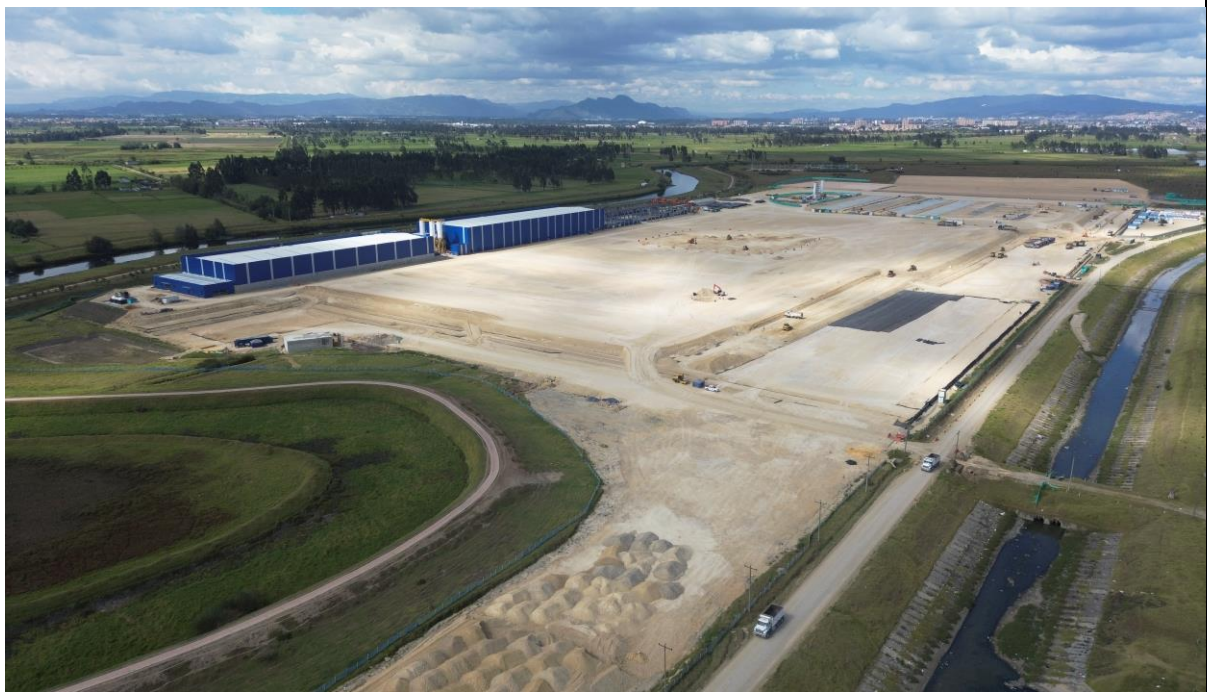
Vista aérea Patio Taller (sep-2023)
