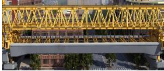
Fotografía 30 Proceso instalación Viga U (fotos de referencia)
