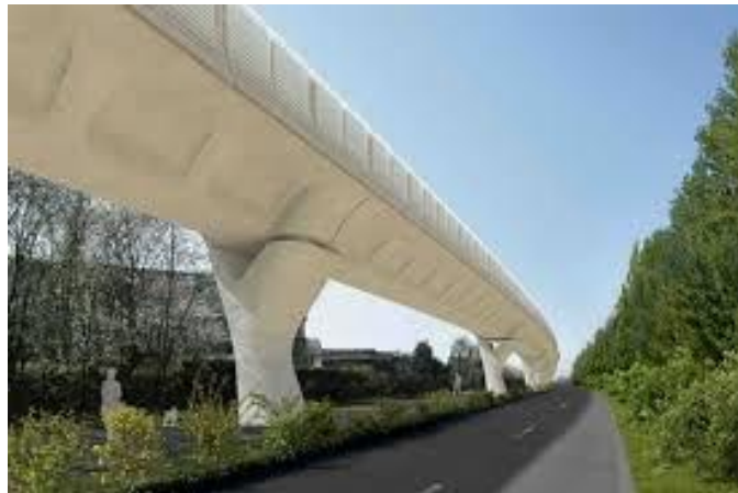
Fotografía 67 Puentes especiales en concreto
