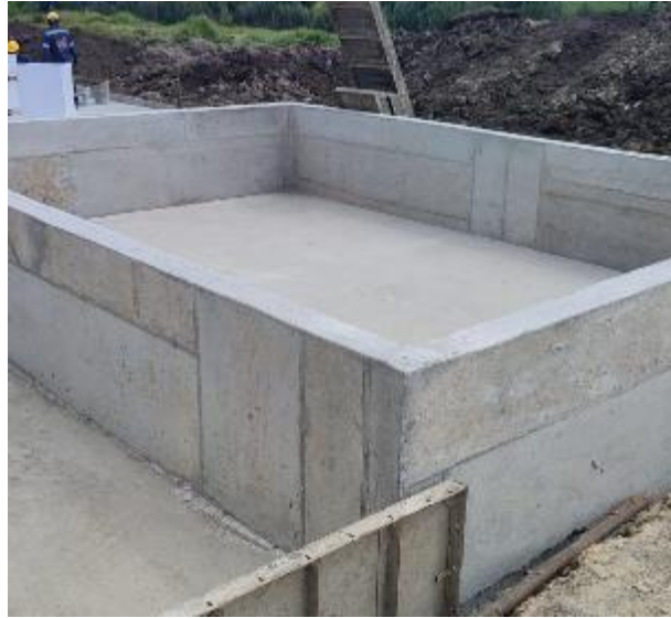
Fotografía 57 Cimentación para tanques con diques
