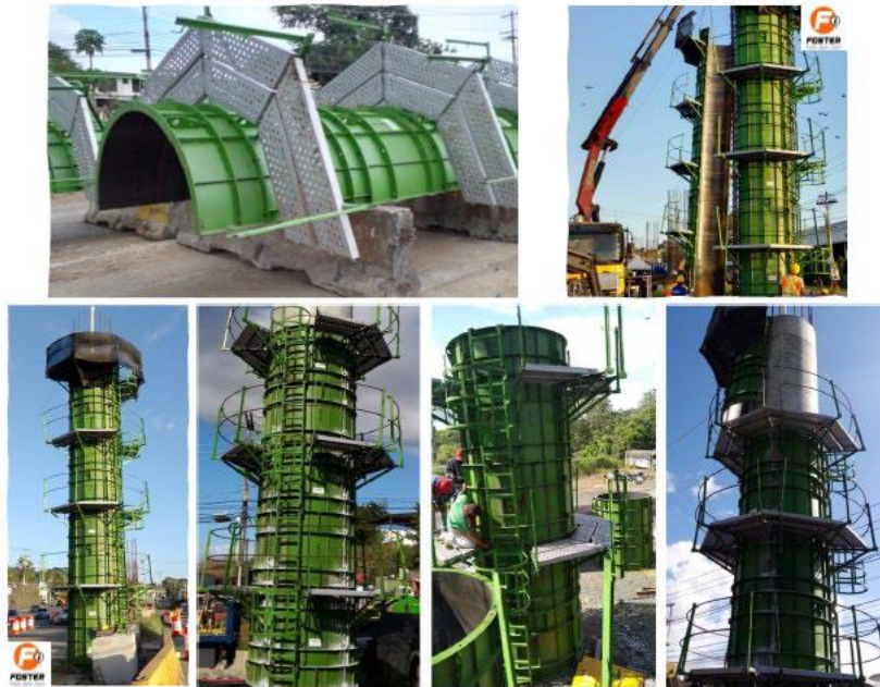
Fotografía 22 Formaleta para construcción de pila (fotos de referencia)
