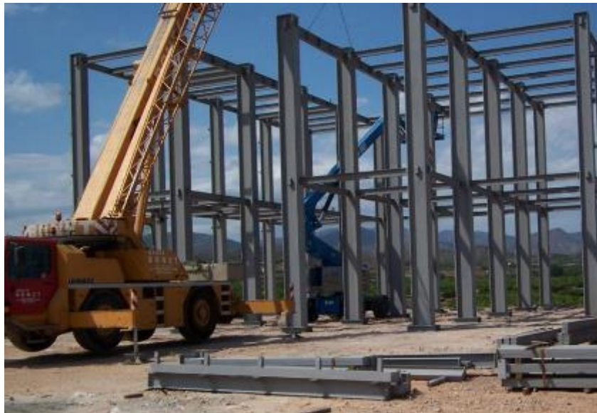
Fotografía 52 Instalación de vigas y columnas
