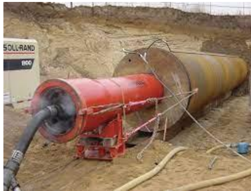
Figura 170 Método Ramming
