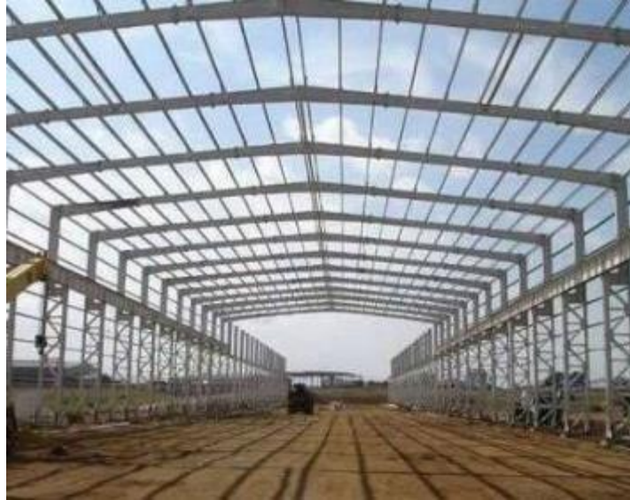
Fotografía 53 Instalación de cerchas
