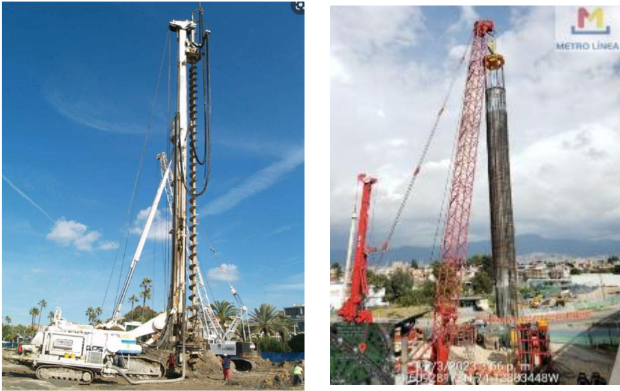
Fotografía 8 Piloteadoras con barreno para pilotes pre excavados – Inserción de canasta con grúa auxiliar
