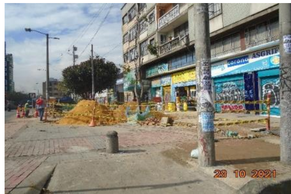
Fotografía 258 ocupación del espacio público, desarrollo de obras, barrio Chapinero.
