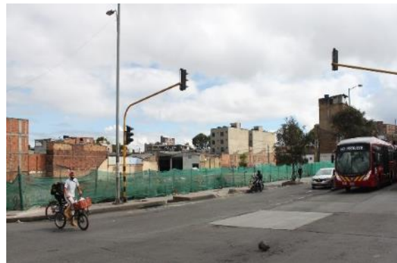
Fotografía 209 Demolición de predios, avenida Caracas.
