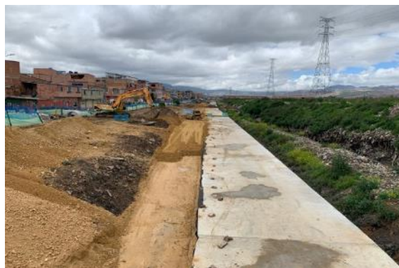
Fotografía 127 Obras sobre el Canal Tintal II
