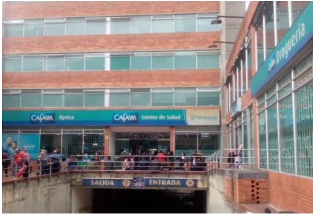
Fotografía 25 Tramo 6 Costado Oriental, Cafam Centro de Salud, Barrio Marly
