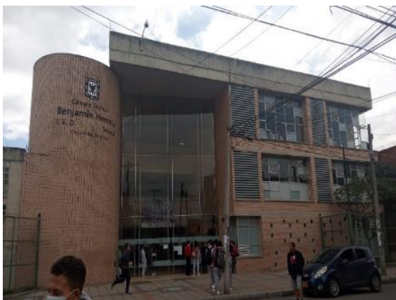
Fotografía 31 Tramo 3 Costado Sur, IED Benjamín Herrera, Barrio Alcalá
