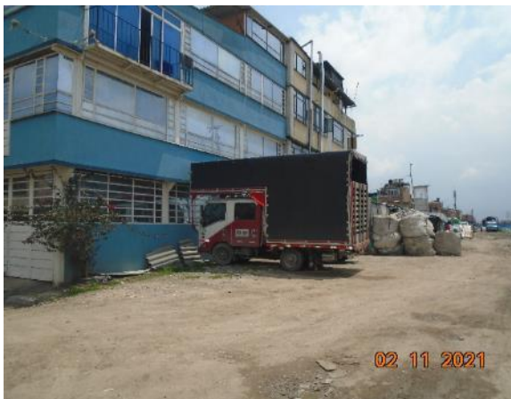
Fotografía 80 Tramo 1, Costado norte, Barrio Las Vegas 2
