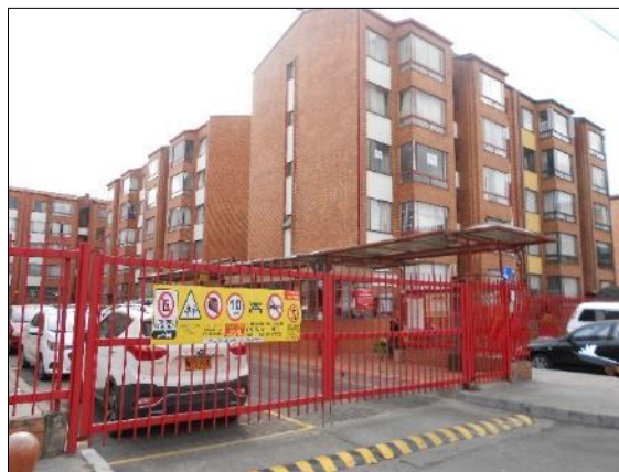
Fotografía 73 Tramo 3, Costado Norte, Conjunto La Guaca – Etapa V, Barrio La Guaca
