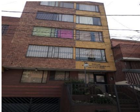
Fotografía 60 Tipología de Vivienda, Tramo 3, Barrio El Tejar
