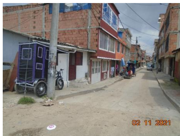
Fotografía 81 Tramo 1, Costado nortel, barrio Las Vegas 2. Estado de las vías locales
