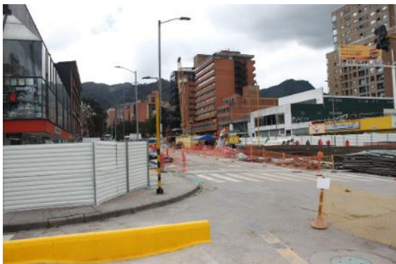
Fotografía 259 Intercambiador vial de la Calle 72 etapa de Construcción.
