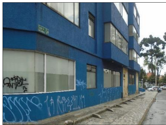
Fotografía 24 Tramo 5 Costado Occidental, Clínica de Especialistas, Barrio Armenia
