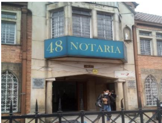
Fotografía 49 Tramo 6, Costado Occidental, Notaría 48, Barrio San Felipe
