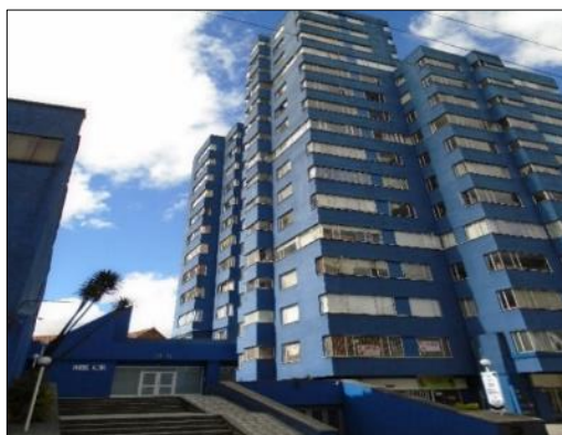
Fotografía 77 Conjunto residencial Torre Azul, Tramo 5, Costado Oriental, Barrio Sucre
