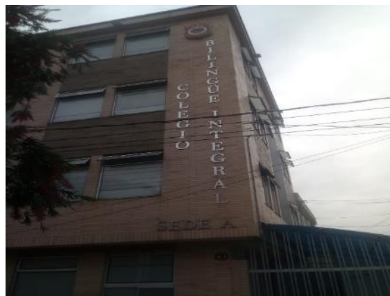
Fotografía 34 Tramo 4, Costado Norte, Colegio Bilingüe Integral, Barrio La Fragua
