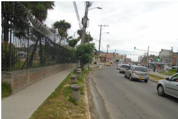
Fotografía 153 Transversal 78 H con Calle 42 F Sur, costado Sur Este, barrio Santa Martha de Pastrana.
