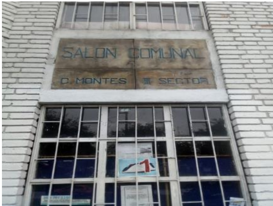
Fotografía 43 Tramo 3, Costado Norte, Salón Comunal, Barrio Ciudad Montes III Sector
