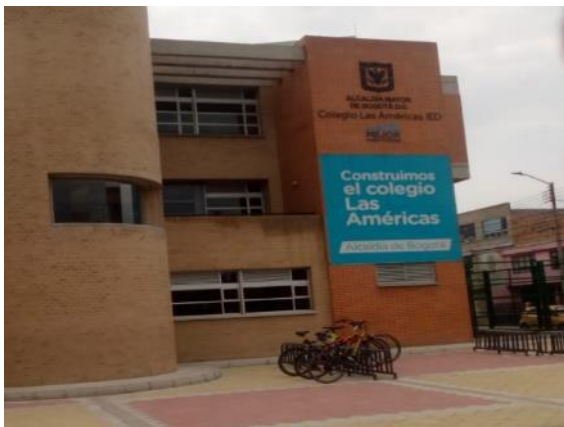
Fotografía 29 Tramo 2, Costado Sur, IED Colegio Las Américas, Barrio Camilo Torres
