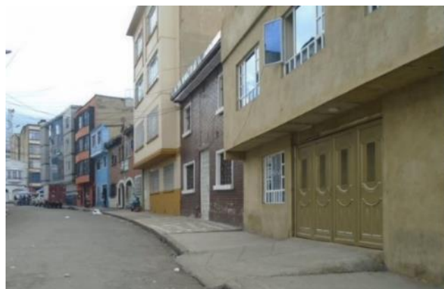
Fotografía 65 Tipología de vivienda, Tramo 5, Costado Occidental, Barrio Santa Fe
