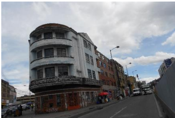
Fotografía 112 Tramo 4 costado Occidental, Barrio La Estanzuela
