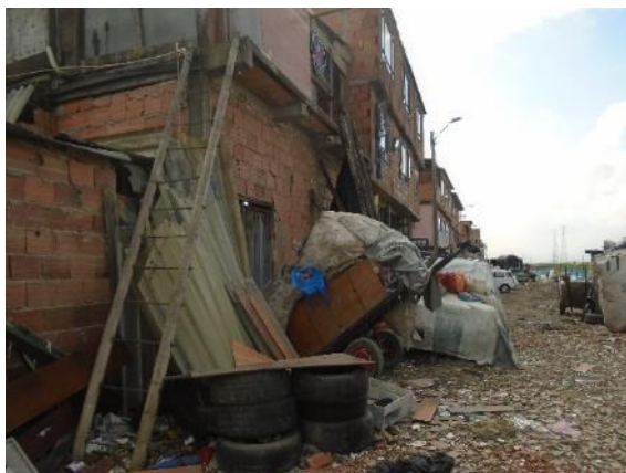
Fotografía 1 Tramo 1 Costado Norte, Jazmín Occidental
