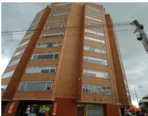
Fotografía 78 Tramo 6, Costado Occidental, Edificio Arboleda
