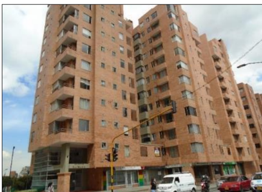
Fotografía 76 Tramo 5, Costado Occidental, Conjunto Residencial Balcones de San Martín, Barrio Teusaquillo
