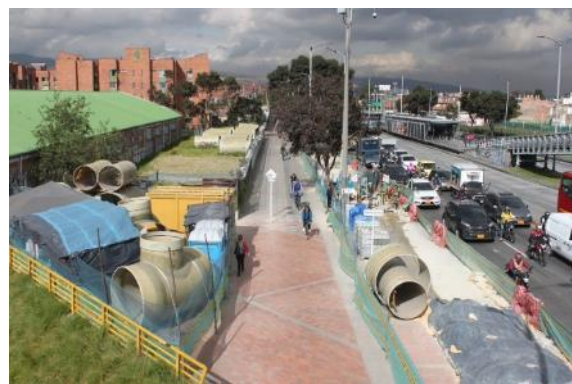
Fotografía 190 Transversal 31 sur, barrio Remanso Sur Estación (BRT) Transmilenio Estación SENA.
