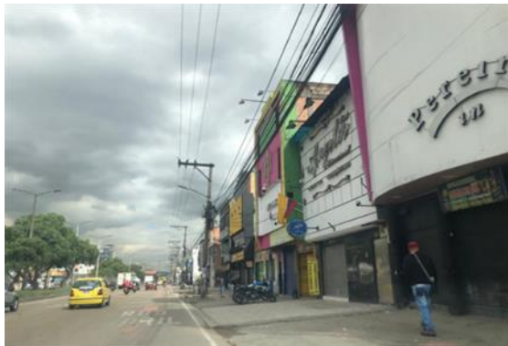
Fotografía 88 Tramo 3, Costado Norte, Barrio La Llanura
