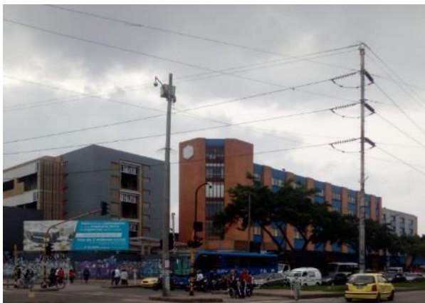
Fotografía 17 Tramo 2 Costado Sur, Hospital de Kennedy, Barrio Timiza
