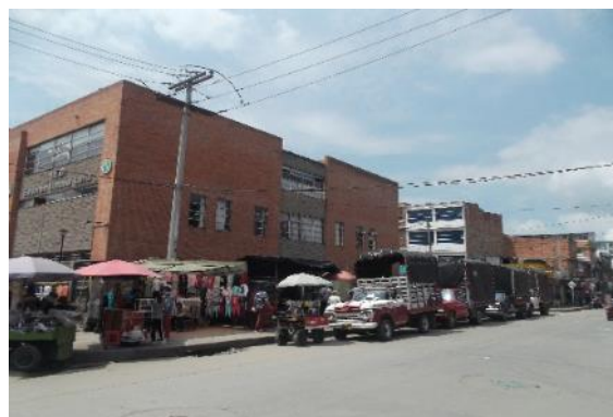
Fotografía 97 Tramo 1, Costado Norte, IED Hernando Duran Dussan
