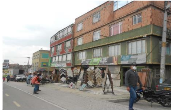
Fotografía 124 Tramo 2, Costado Norte, Barrio Villa Nelly, Localidad Kennedy.
