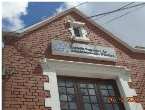
Fotografía 36 Tramo 5, Costado Oriental, Escuela Superior de Administración Pública - ESAP, Barrio Sucre
