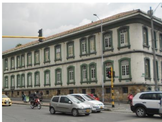
Fotografía 21 Tramo 4 Costado sur, Hospital Materno Infantil, Sector Institucional
