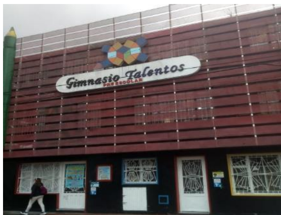
Fotografía 32 Tramo 3 Costado Norte, Gimnasio Talentos, Barrio Santa Matilde
