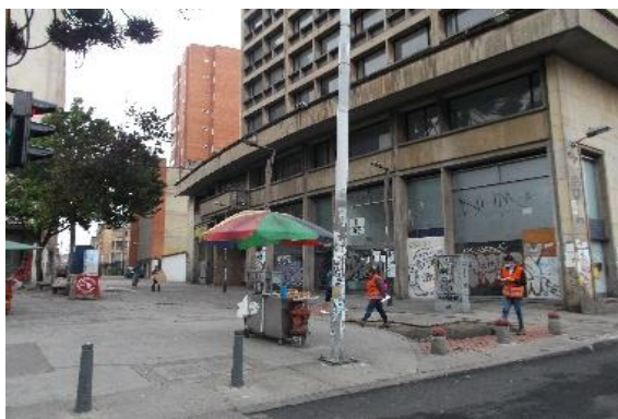
Fotografía 114 Tramo 5 Costado Oriental, barrio La Alameda
