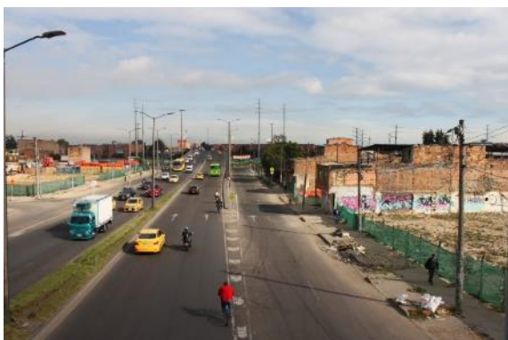
Fotografía 171 Avenida 68, barrio El Tejar, costado Oriental
