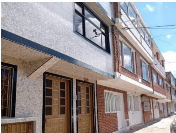
Fotografía 58 Tipología de Vivienda, Tramo 2, Costado Sur, Barrio Aristóteles Onassis
