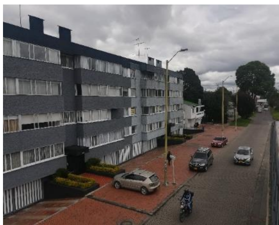
Fotografía 79 Tramo 6, Costado Occidental Conjunto residencial Vivienda Guadalupe, Barrio El Polo
