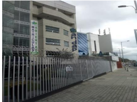
Fotografía 38 Tramo 6, Costado Occidental, ANDAP-Academia Nacional de Aprendizaje, Barrio Juan XIII
