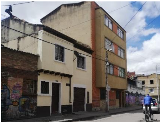
Fotografía 64 Tipología de vivienda, Tramo 5, Costado Occidental, Barrio Santa Fe
