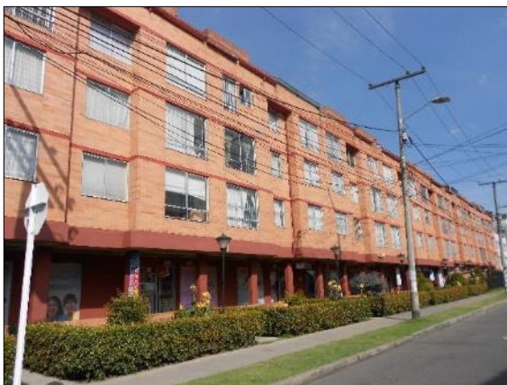
Fotografía 72 Tramo 3, Costado Sur, Conjunto Floralia Real
