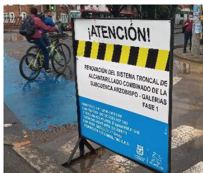
Fotografía 44 Renovación del sistema de alcantarillado - Tramo 4
