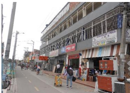
Fotografía 15 Comercio de materiales de construcción– Tramo 2 Coordenadas Magna Sirgas Bogotá 89873,98 E, 103134,56 N. Localidad: Kennedy Fuente: Metro Línea 1, 2023
