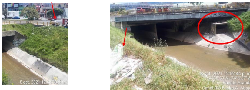
Fotografía 53 Disposición inadecuada de residuos sólidos en Canal Río Fucha
