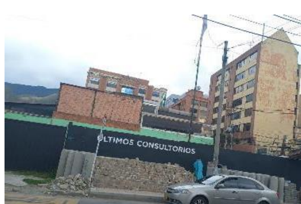
Fotografía 39 Construcción de consultorios – Tramo 6 Coordenadas Magna Sirgas Ciudad Bogotá: 101815,10 E, 106708,31 N. Localidad: Barrios Unidos Fuente: Metro Línea 1, 2023
