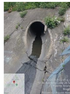
Fotografía 50 Conexiones erradas sobre Canal Rio Seco
