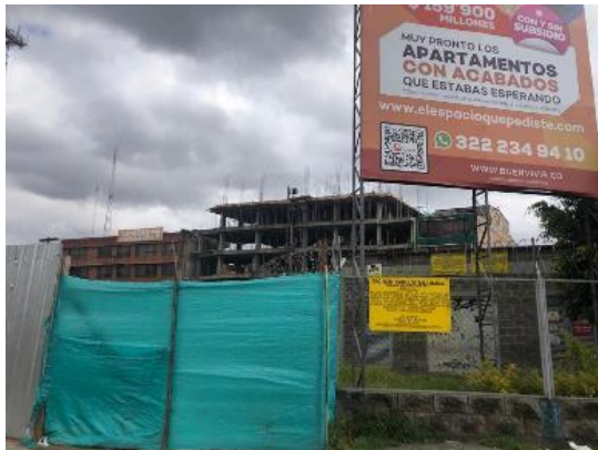
Fotografía 38 Construcción de vivienda – Tramo 2 Coordenadas Magna Sirgas Ciudad Bogotá: 90521,48 E, 102038,73 N. Localidad: Kennedy Fuente: Metro Línea 1, 2023
