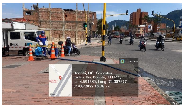
Fotografía 45 Mantenimiento en redes – Tramo 4
