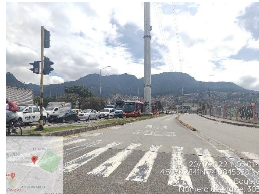
Fotografía 17 Separadores viales tramo 4 Avenida Caracas
