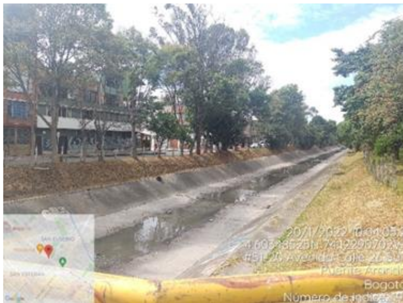
Fotografía 9 Canal del Río Seco Sector 1
