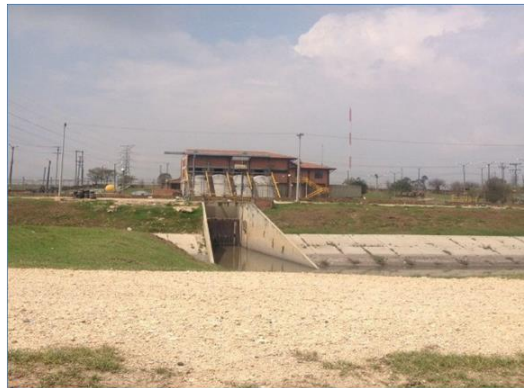
Fotografía 49 Canal Cundinamarca, en el sector que entrega aguas al Rio Bogotá, mediante la estación de bombeo
