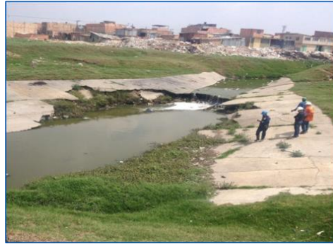
Fotografía 52 Canal Tintal II, antes del inicio de las obras en el sector que entrega aguas a canal Cundinamarca
