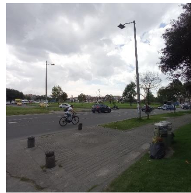
Fotografía 19 Glorieta Avenida Primero de mayo con Carrera 50 Tramo 3
