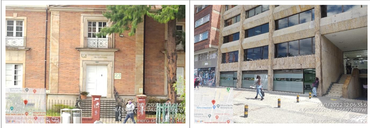
Fotografía 46 Infraestructura presente en el Tramo 6
