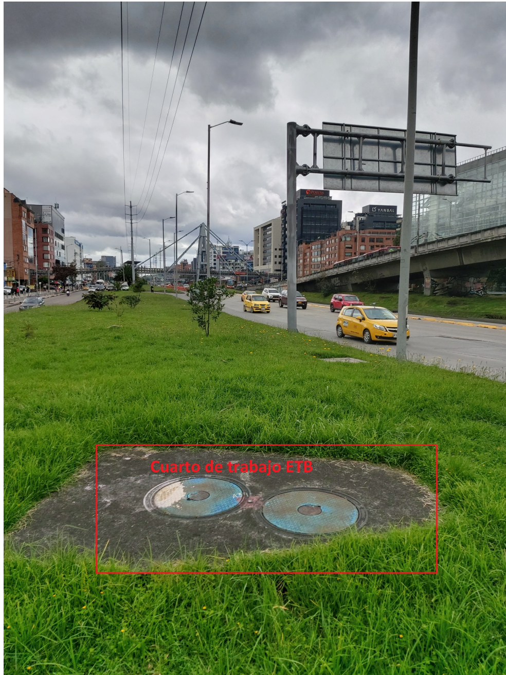
Fotografía 12. Redes de ETB sobre separador occidental autopista norte con calle 93 Fuente: Imagen de campo
