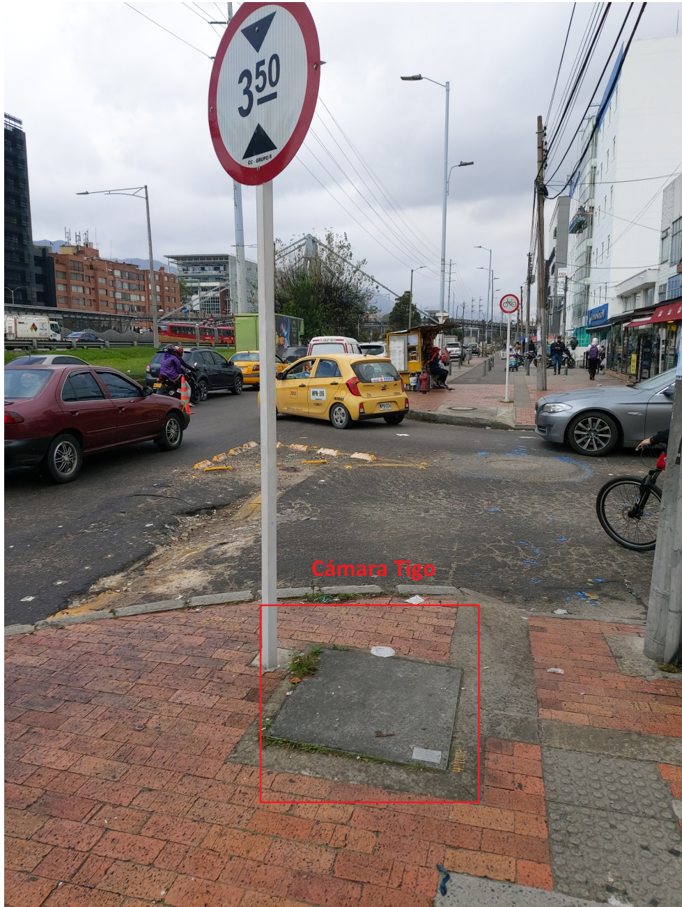
Fotografía 14. Redes de Tigo sobre la Av. carrera 45 con calle 95 costado occidental Fuente: Imagen de campo
