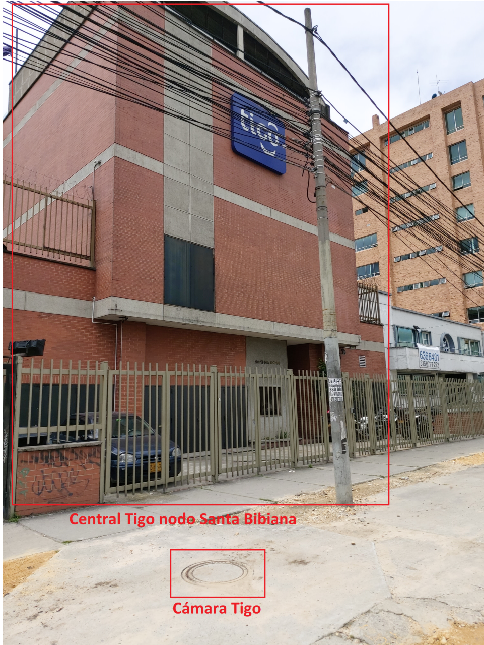
Fotografía 16. Central Tigo nodo Santa Bibiana sobre la autopista norte # 102-50 Fuente: Imagen de campo
