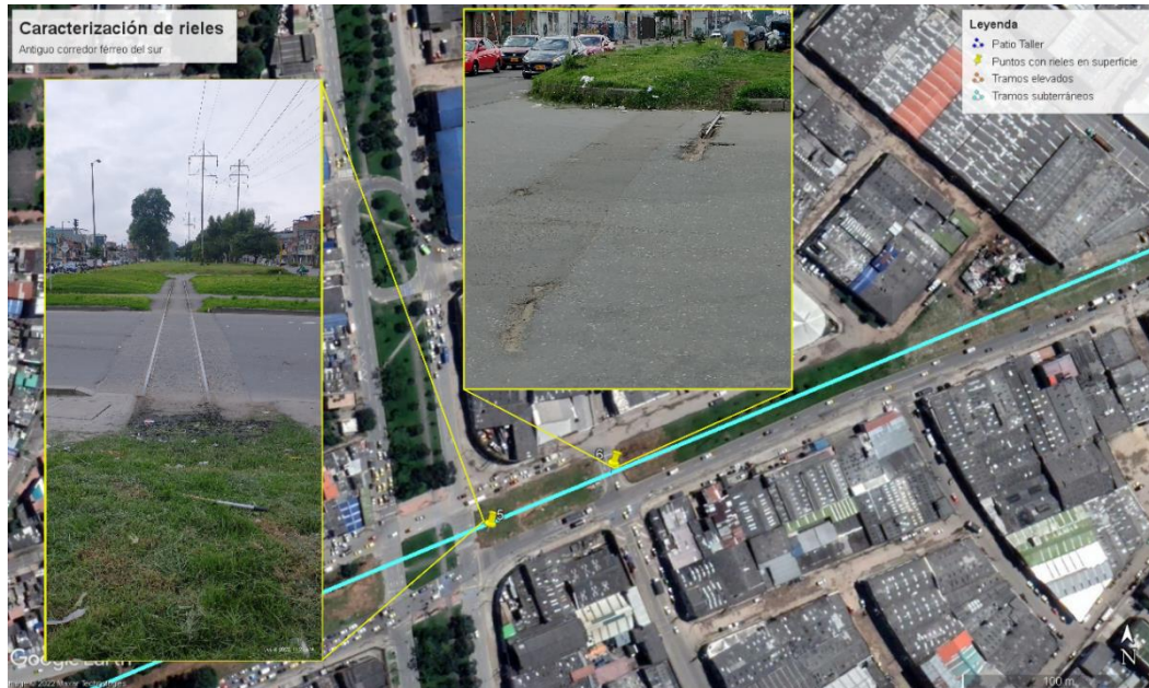
Ilustración 5. Recorrido realizado al corredor férreo de sur. Punto No 5 (Trans. 42 con calle 6) y 6 (Trans. 42 con calle 9)
