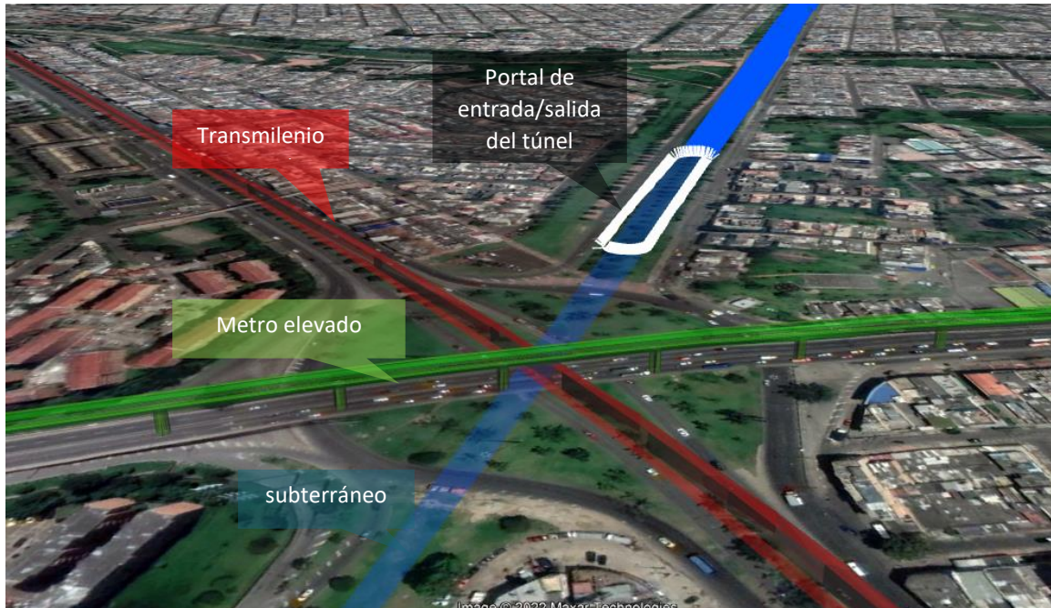
Figura 26. Intersección AV. 68 y 1 Mayo.
