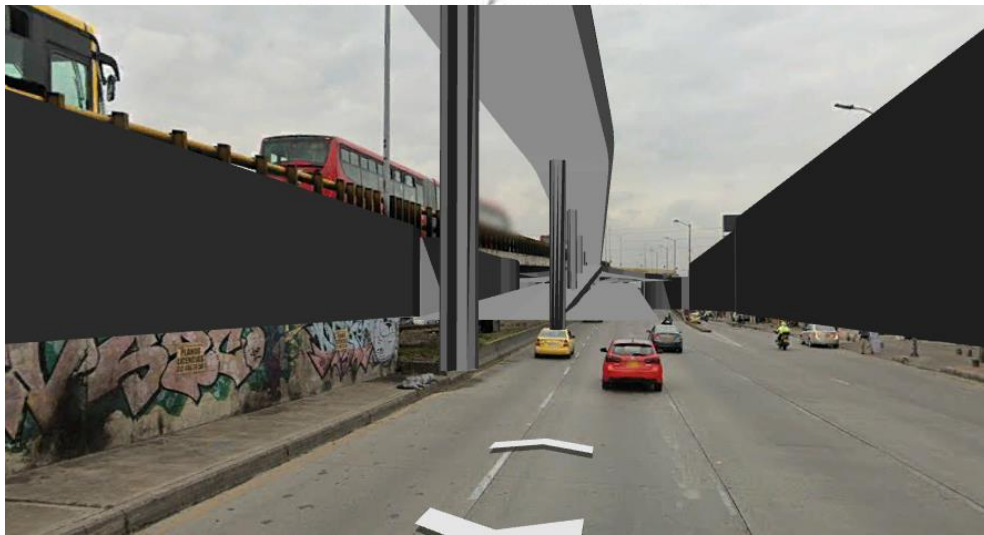
Figura 36. Vista del viaducto sobre la calle la NQS.
