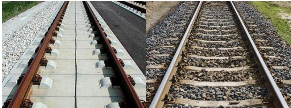
Figura 41. Comparación entre la vía en placa la vía y la vía convencional.
