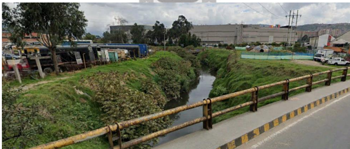
Fotografía 7-2 Espejo de agua del río Tunjuelo con intercepción Alternativa 1
