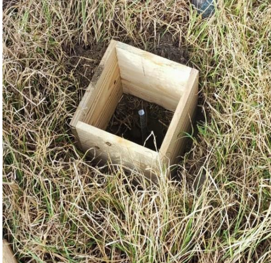
Figura 26. Materialización mojón para GPS 02.
