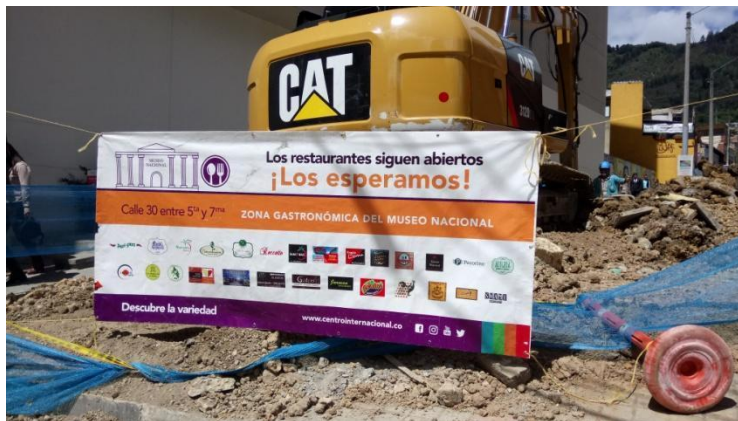
Fotografía 8.2.6 Instalación de Vallas Informativas.
