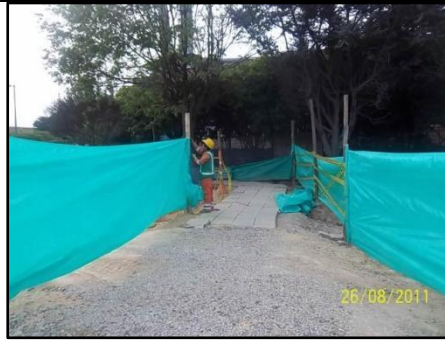
Fotografía 8.1 Uso de RCD para Adecuación de Pasos Peatonales.
