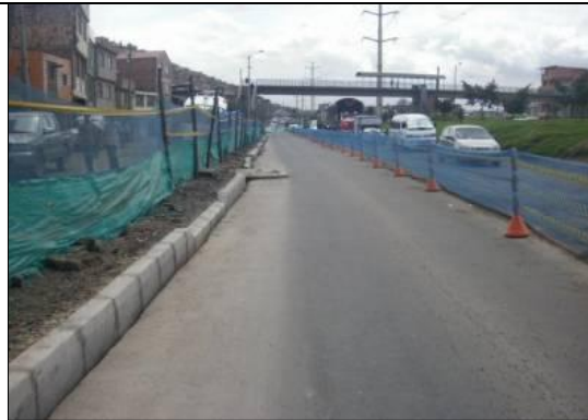
Fotografía 8.14 Señalización de Avance de Obra.
