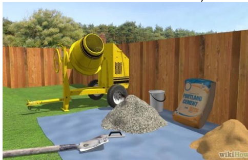
Figura 8.2 Cobertura con Geotextil para Mezcla de Concreto
