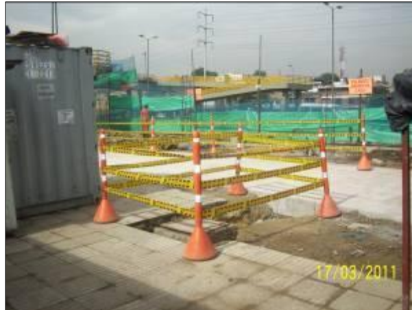
Fotografía 8.7 Señalización de los Sitios de Excavación.
