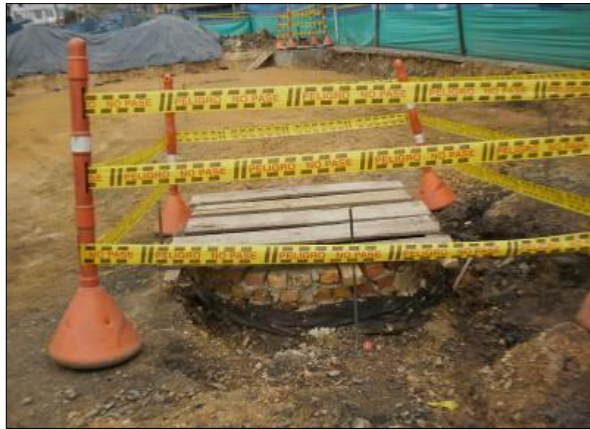
Fotografía 8.10 Señalización para pozos de inspección o sumideros.
