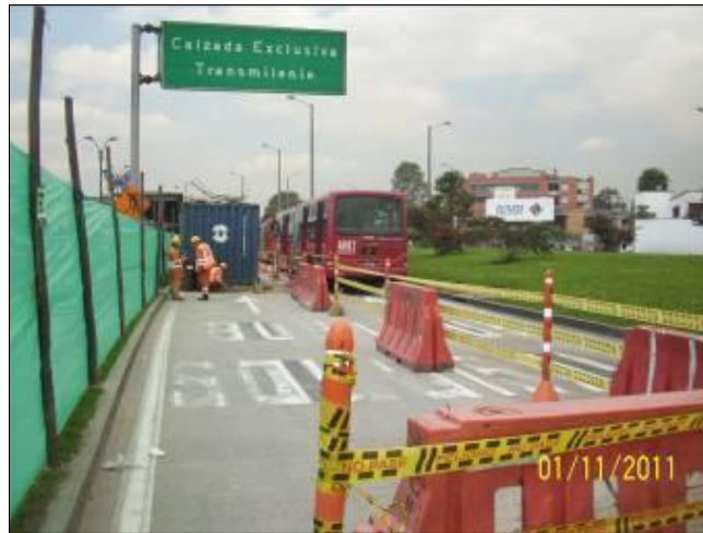
Fotografía 8.9 Señalización de Obras.
