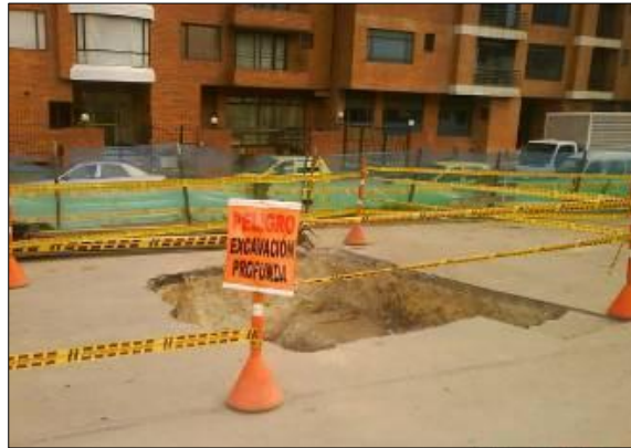
Fotografía 8.13 Señalización de Excavaciones Profundas.
