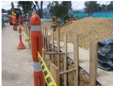
Fotografía 8.2 Entibado de Excavaciones con Profundidad mayor a 1,5 m.
