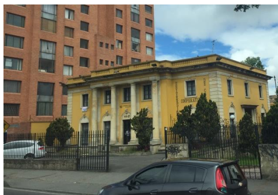
Edificio patrimonial barrio Santa Teresita
